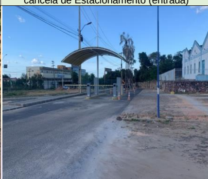
Figura 04: Estrutura de proteção para a cancela de Estacionamento (entrada)
