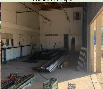
Figura 10: Metalúrgica-Estrutura Metálica da Fachada Principal
