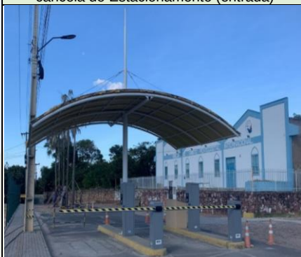
Figura 05: Estrutura de proteção para a cancela de Estacionamento (entrada)
