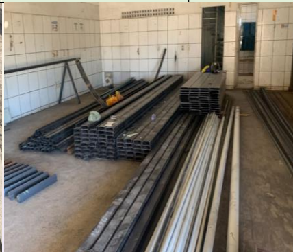
Figura 12: Metalúrgica-Estrutura Metálica da Fachada Principal
