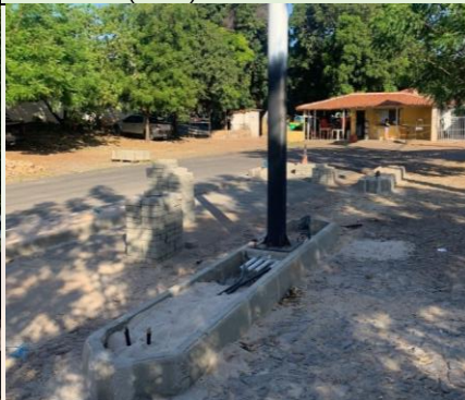
Figura 14: Cancelas de Estacionamento (saída)-Infra-Estrutura
