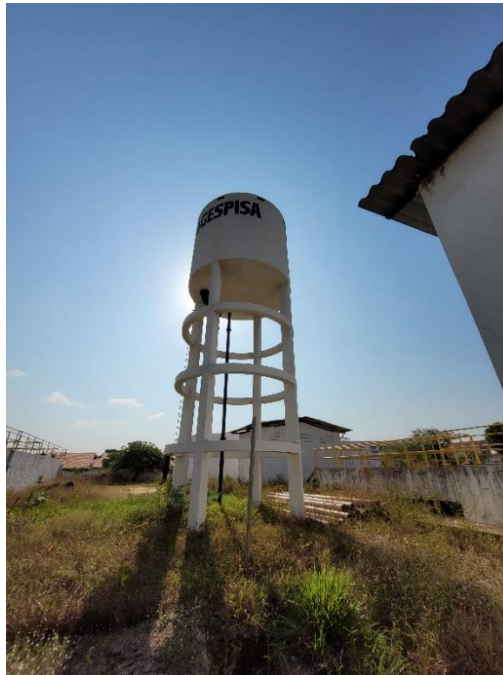
Figura 28 - Reservatório Elevado da AGESPISA na cidade de Parnaíba
