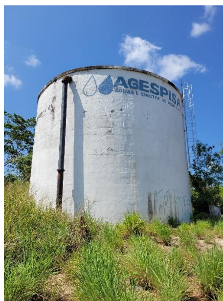
Figura 29 - Reservatório Apoiado da AGESPISA na cidade de Altos
