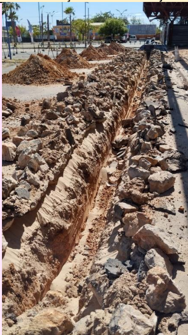
Figura 06: Instalação Sanitária Lojas Externas
