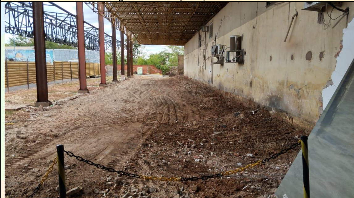
Figura 03: Demolição Lojas Externas
