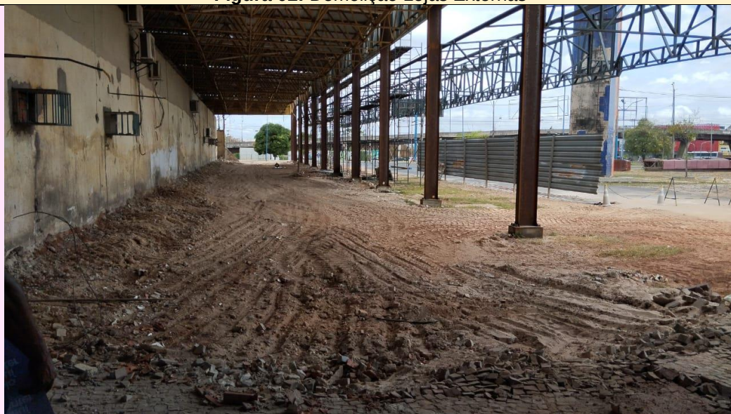
Figura 02: Demolição Lojas Externas
