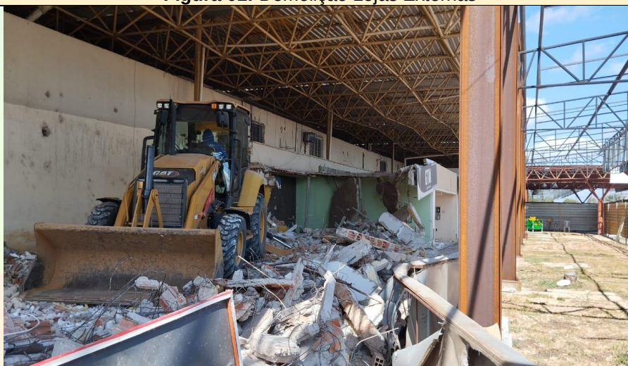
Figura 01: Demolição Lojas Externas
