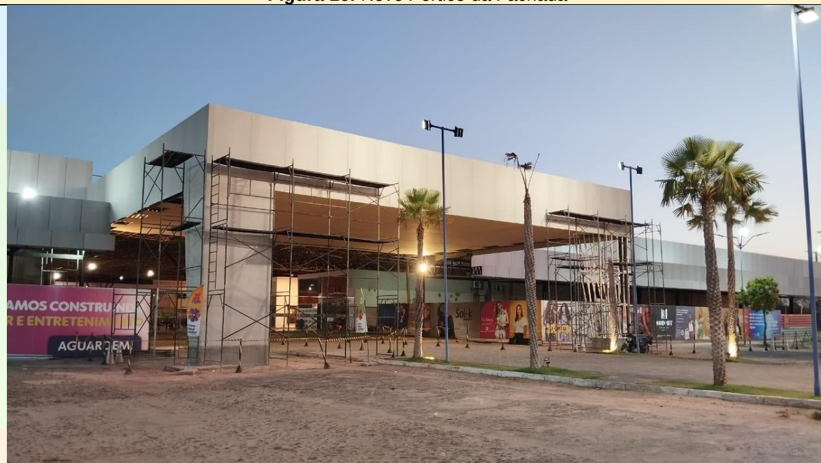
Figura 16: Novo Pórtico da Fachada
