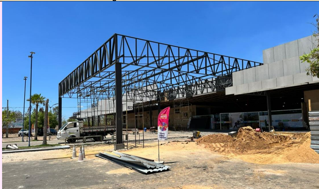
Figura 13: Novo Pórtico da Fachada
