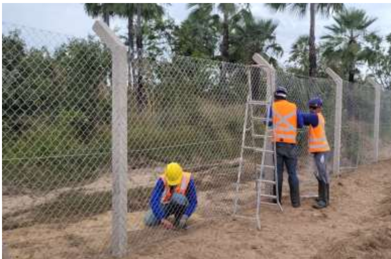
Registro de trabalhadores realizando a implantação da Cerca de Proteção.
