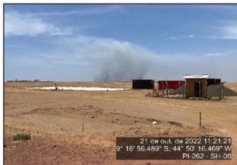
Canteiro de obra da Praça de Pedágio P4 já implantado pela Concessionária
