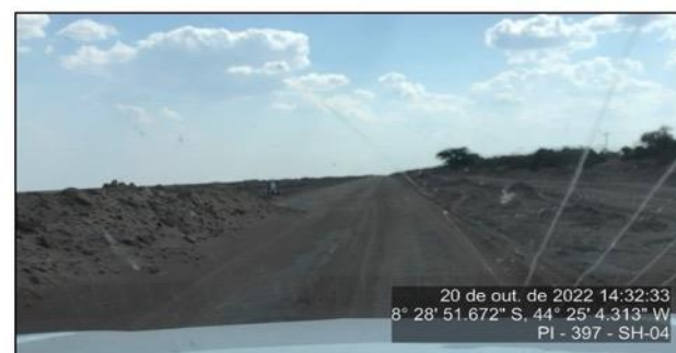
Final do trecho em serviço de terraplenagem
