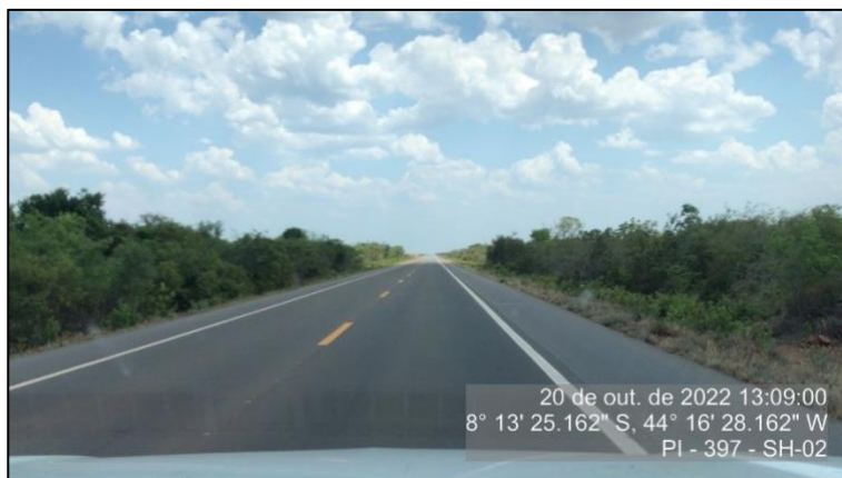
Figura 51 - Pintura em bom estado - SH-02
