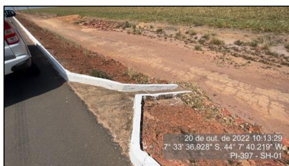
Figura 26 – Descida d'água desobstruída e em boas condições – SH-01
