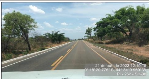
Pavimento e sinalização horizontal em bom estado
