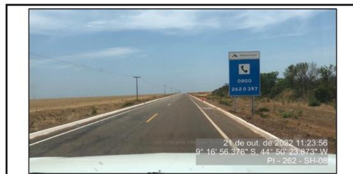
Sinalização vertical implantada
