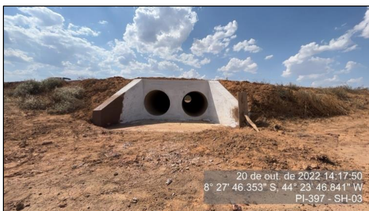
Figura 63 - Bueiro duplo do km 116,60 reparado e desobstruído (out/22) - SH-03
