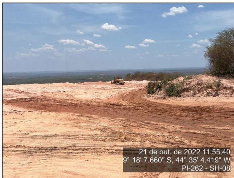
Figura 130 - Bota-fora da obra de correção do traçado do km 33 - SH-08
