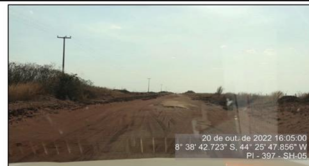
Trecho do segmento com material solto.
