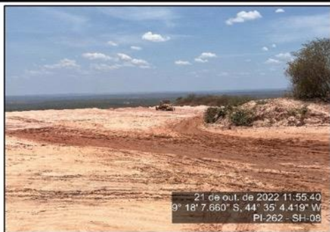
Bota-fora da Obra de correção do traçado da Serra do Quilombo, km 33,65 da Rodovia PI-262, a serviço da SETRANS-PI.
