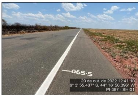
Diferença de nível do pavimento asfáltico entre as faixas de rolamento da pista, no KM 65,50.
