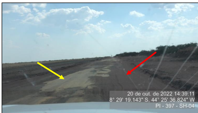
Figura 71 - Superfície do pavimento em leito natural - SH-04
