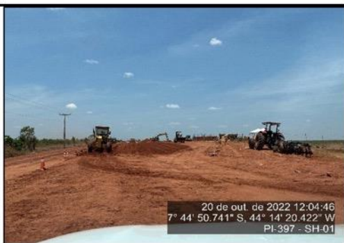
Obras das instalações da praça de pedágio 01.
