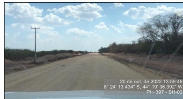
Serviço de terraplenagem sendo executado no segmento.
