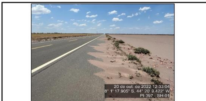
Material solto sendo depositado no pavimento da pista
