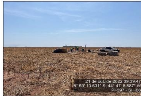
Mobilização de canteiro de obras para torre de comunicação
