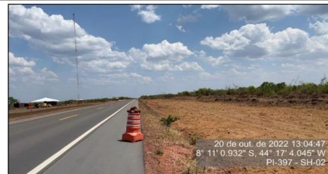
Alargamento da faixa da pista na obra da P2 - SH-02
