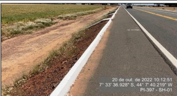
Meio-fio instalado e talude com vegetação baixa de acordo com o previsto no PER que é de 30cm.
