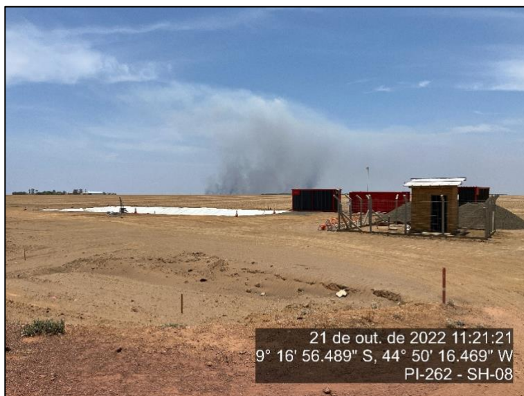
Figura 127 - Canteiro da P4 - SH-08
