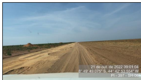
Figura 90 - Batente formado pela compactação do material do subleito - SH-06 - 4
