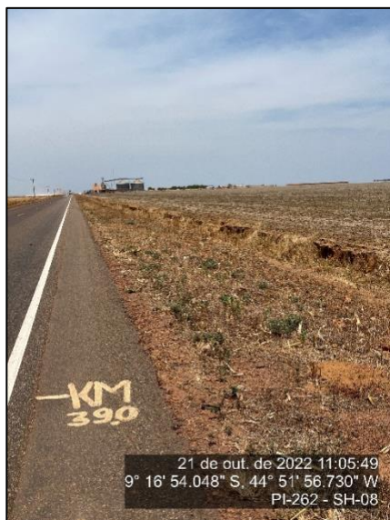
Figura 125 - Talude com cobertura vegetal - SH-08
