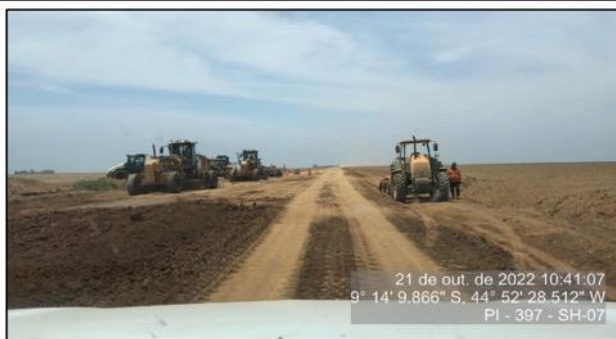
Execução de terraplenagem das obras de ampliação e melhoria no segmento.
