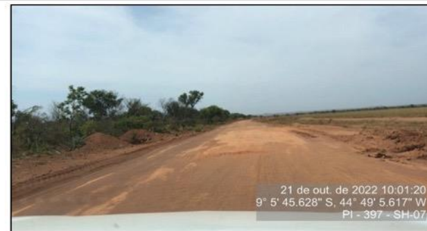
Batente em formação com material solto
