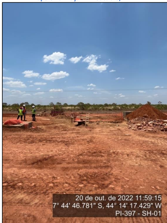
Figura 40 – Execução de fundação da Praça P1 – outubro/22
