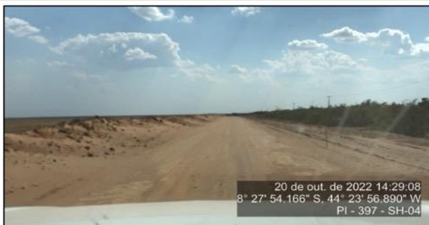
Início do Segmento 04 com material depositado no bordo da pista
