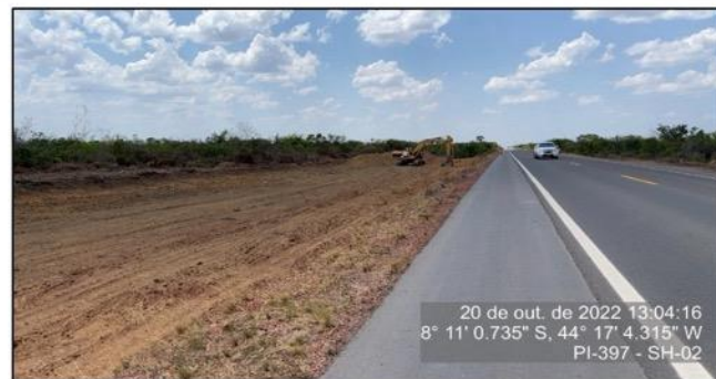
Obra da P2 - Serviços de Terraplenagem - SH-02
