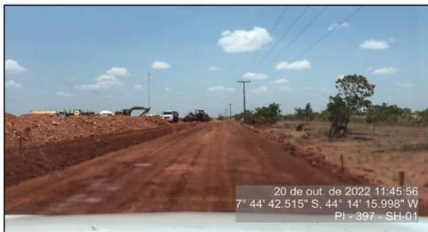
Obras das instalações da praça de pedágio 01.
