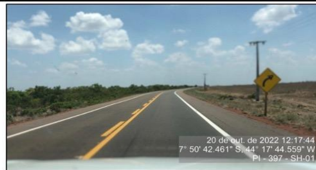
Implantação da sinalização vertical no segmento.
