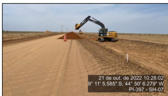
Figura 108 – Escavação do material do bordo da pista – outubro/22 – SH 07
