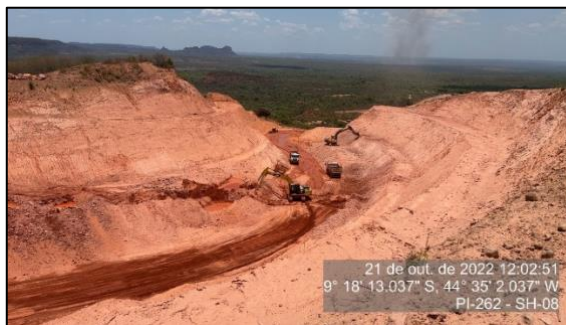
Figura 129 - Obra do km 33 em terraplenagem - SH-08 - 2
