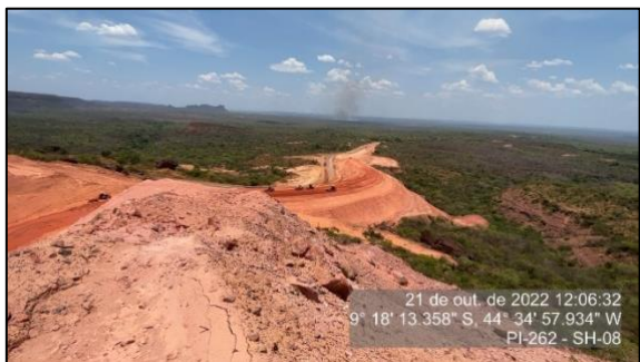
Figura 128 - Obra do km 33 em terraplenagem - SH-08 - 1
