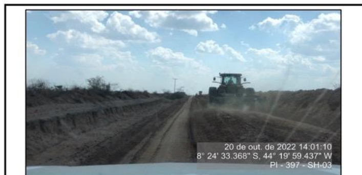
Serviço de terraplenagem sendo executado no segmento.
