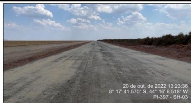
Serviço de imprimação executado no Início do Segmento
