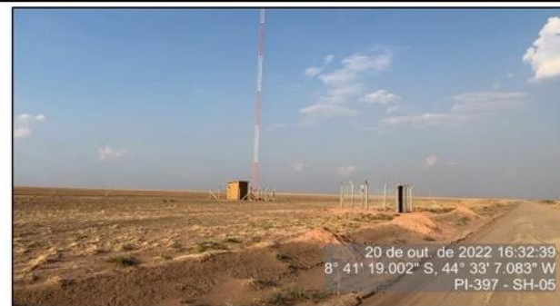
Torre de comunicação e poço instalados na P3
