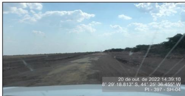
Serviço de limpeza e roçada executado na lateral da pista
