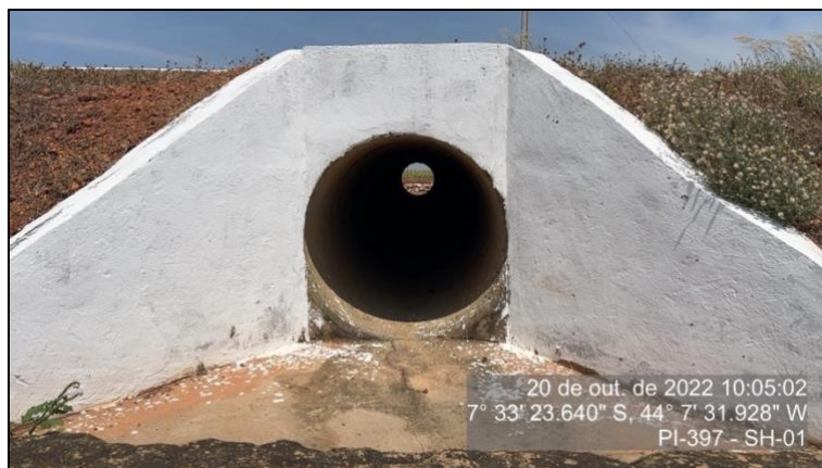
Figura 28 – Bueiro simples 01 localizado no KM 0 do segmento – SH1.
