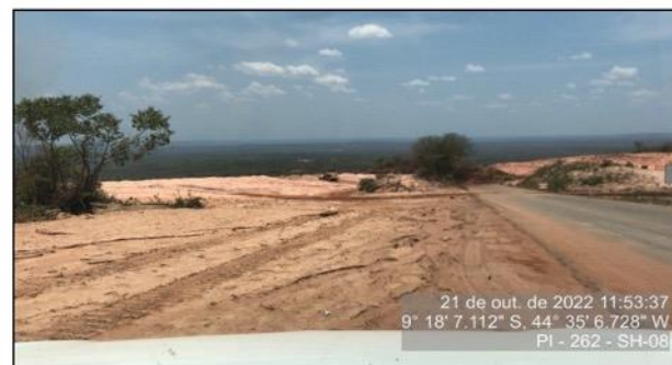
Entrada para obra do km 33
