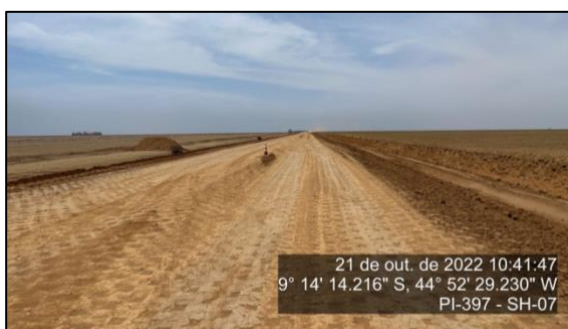
Figura 109 – Trecho em execução de melhorias e ampliação – SH 07
