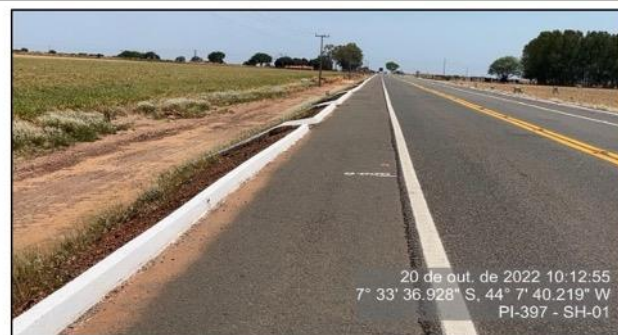
Sinalização horizontal (pintura) em boas condições.
