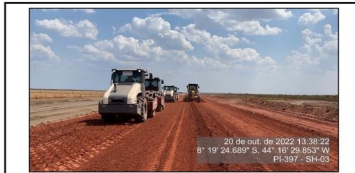
Serviço de terraplenagem sendo executado no segmento.
