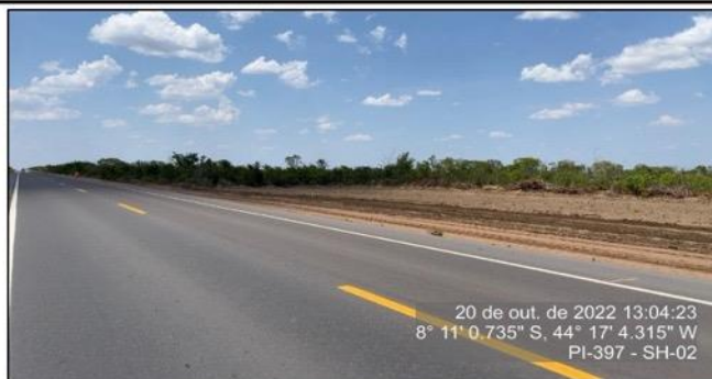
Obra da P2 - Serviços de Terraplenagem - SH-02
