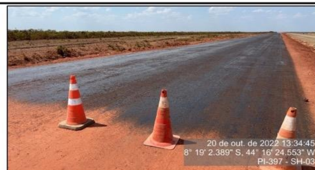
Trecho com imprimação recém executada
