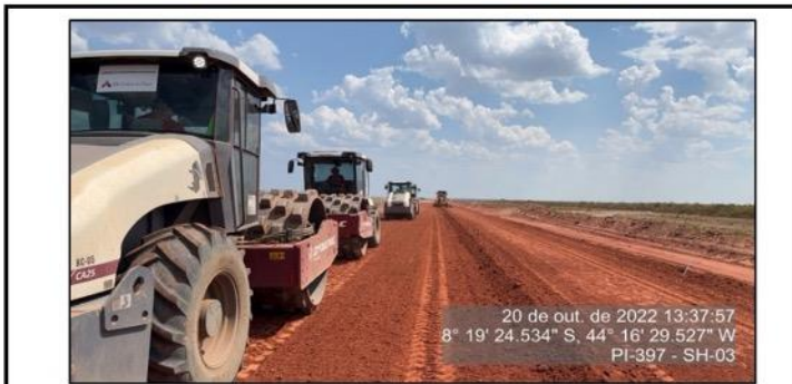
Serviço de terraplenagem sendo executado no segmento.
