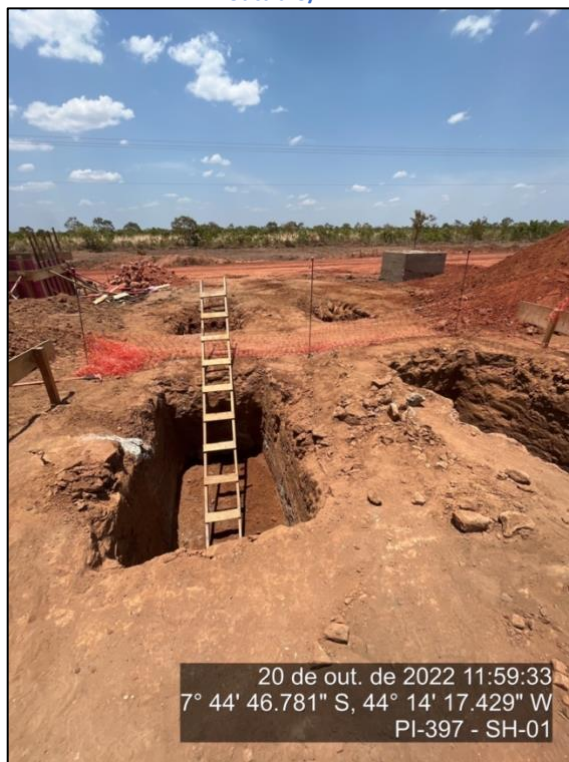
Figura 41 - Execução de fundação da Praça P1 – outubro/22
