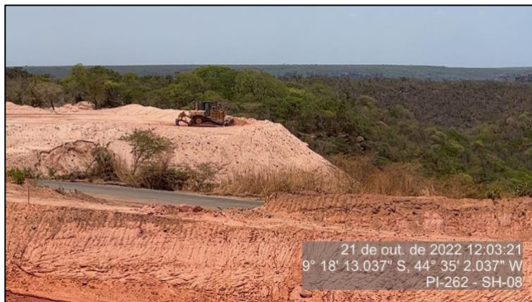
Figura 131 - Talude do bota-fora da obra do km 33 - SH-08
