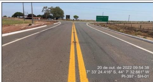
Tachas refletivas na interseção da Transcerrados com a PI-PI-247 / BR 324, cumprindo o indicador do item 5.2.2 do PER.
