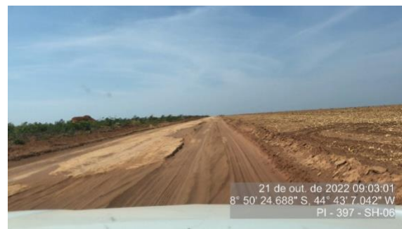
Figura 92 - Batente formado pela compactação do material do subleito - SH-06 - 6
