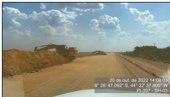
Figura 65 – Escavação e carga nas caixas de empréstimo (2) - SH-03
