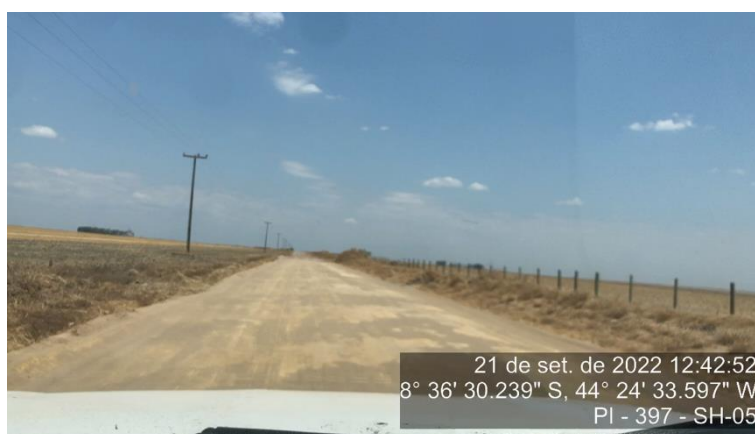
Figura 3 - Postes Existentes - SH-05
