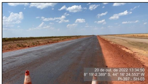
Figura 68 – Execução de imprimação (1) - SH-03
