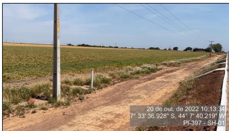
Figura 37 – Delimitadores da faixa de domínio – SH-01
