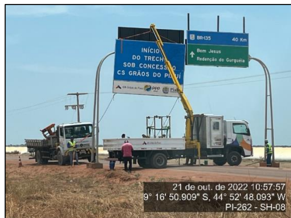
Figura 121 - Implantação de Sinalização Aérea - SH-08 - 2
