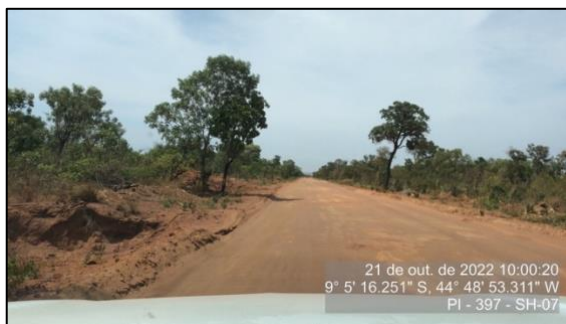
Figura 105 – Trecho com vegetação baixa após serviço de roçada – SH-06
