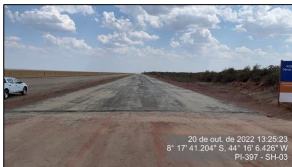
Figura 69 – Execução de imprimação (2) - SH-03
