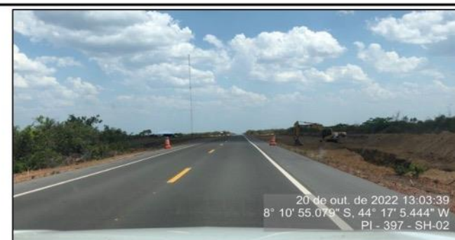
Sinalização de obra da P2 - SH-02
