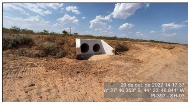
Bueiro presente no segmento
