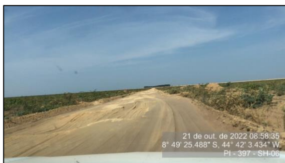
Figura 87 - Batente formado pela compactação do material do subleito - SH-06 – 1
