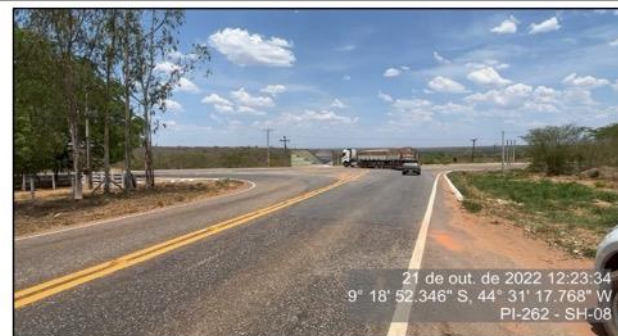
Final do segmento homogêneo 8 - interseção entre a PI-262 e a PI-135
