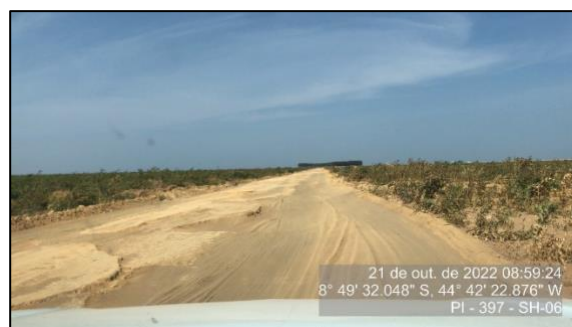
Figura 88 - Batente formado pela compactação do material do subleito - SH-06 - 2
