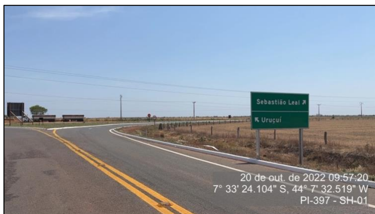
Figura 24 – Sinalização vertical implantada– SH1.
