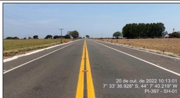
Sinalização horizontal (pintura) em boas condições.
