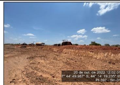
Obras das instalações da praça de pedágio 01.
