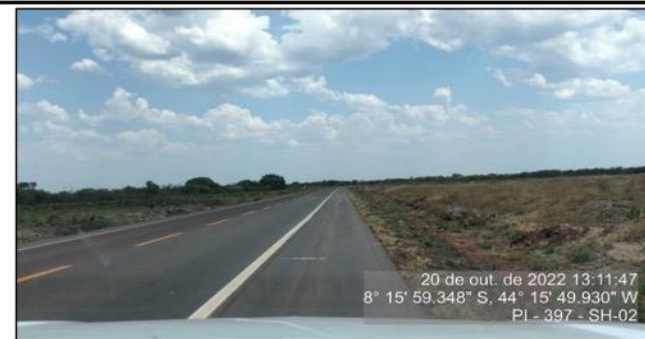
Talude lateral com cobertura vegetal - SH-02
