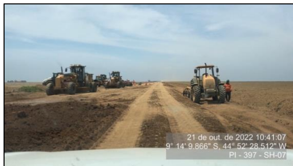
Figura 106 – Frente de execução de aterro – SH 07
