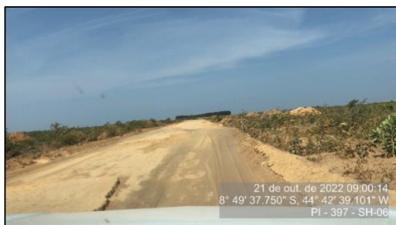
Figura 89 - Batente formado pela compactação do material do subleito - SH-06 – 3
