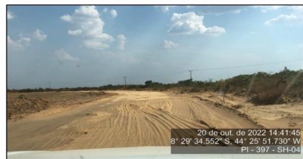
Final do serviço de limpeza e roçada executado na lateral da pista
