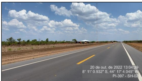
Figura 58 - Serviço de Terraplenagem e torre de comunicação ao fundo - P02
