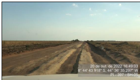
Figura 81 – trecho com elevadas marcas de trilhas de roda – SH-05
