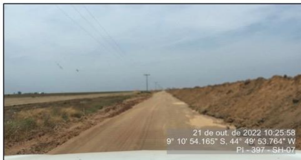
Depósito do material escavado na pista.
