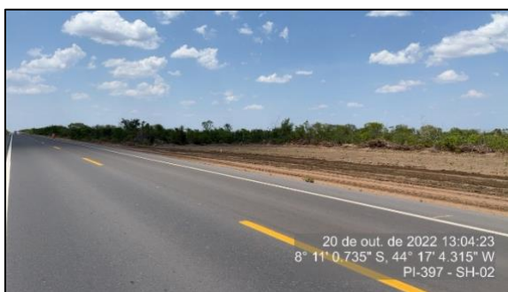
Figura 56 - Serviço de terraplenagem executado a direita - P02
