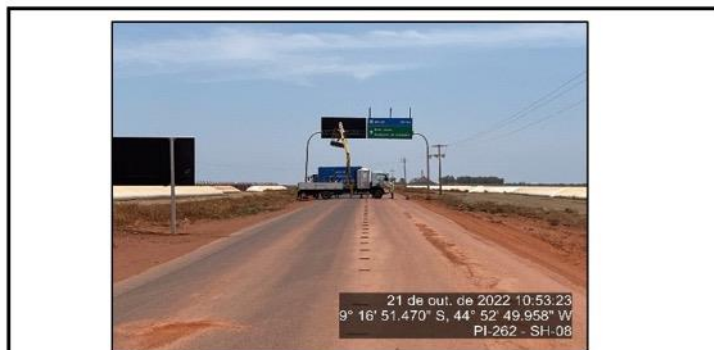
Início do segmento homogêneo 8 - segmento pavimentado.
