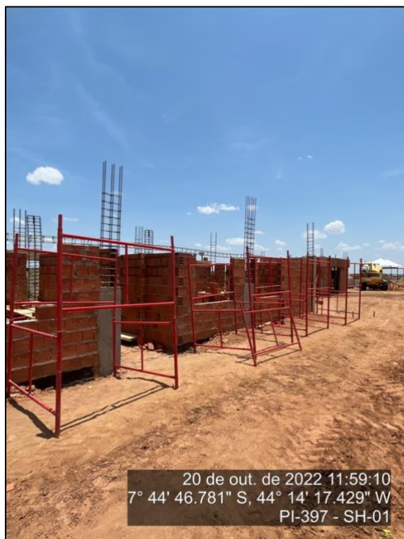
Figura 38 – Execução de obras civis das instalações de apoio na Praça P1 – outubro/22
