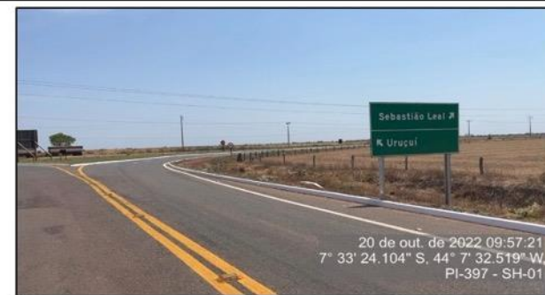
Trevo da interseção da Transcerrados(PI-397) com a PI-247 / BR 324 após os serviços de capina e roçada.
