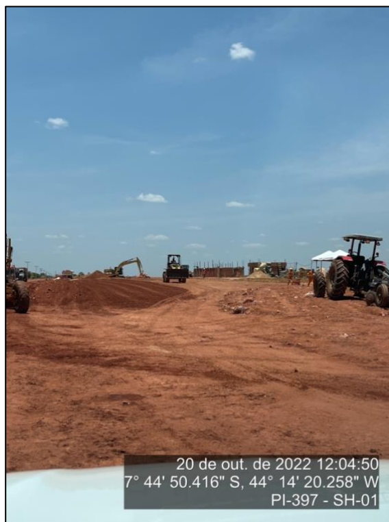
Figura 43 - Execução de terraplenagem na Praça P1 – outubro/22
