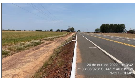
Figura 27 - Drenagem em boas condições – SH-01
