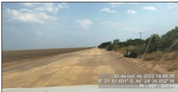
Segmento em leito natural com material solto à direita
