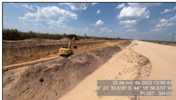
Figura 64 – Escavação e carga nas caixas de empréstimo (1) - SH-03
