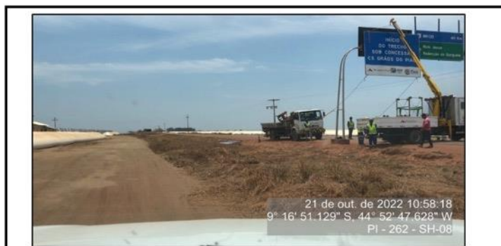
Implantação de sinalização vertical
