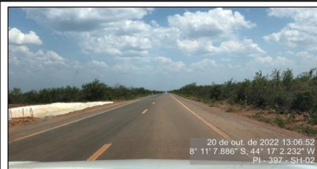
Saída do Canteiro da P2 - SH-02
