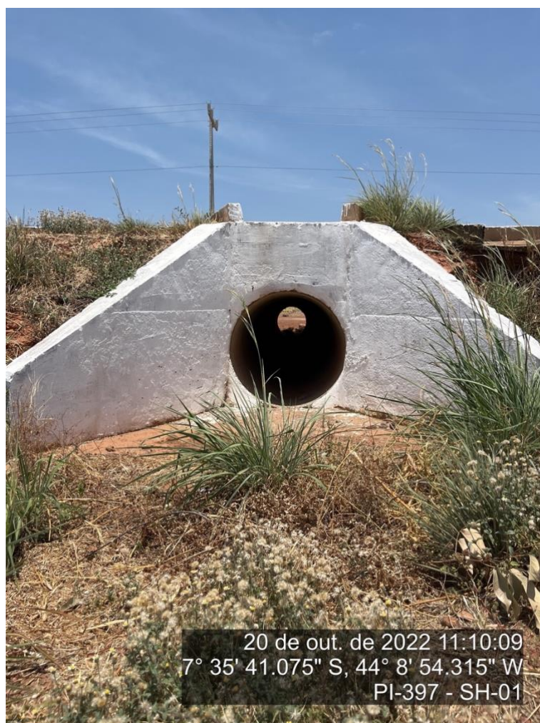
Figura 29 – Bueiro simples 03 localizado no KM 12,70 do segmento – SH1.
