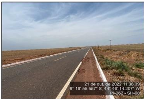
Buraco no acostamento do Segmento 08
