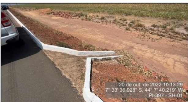
Descida d'água - SH-01
