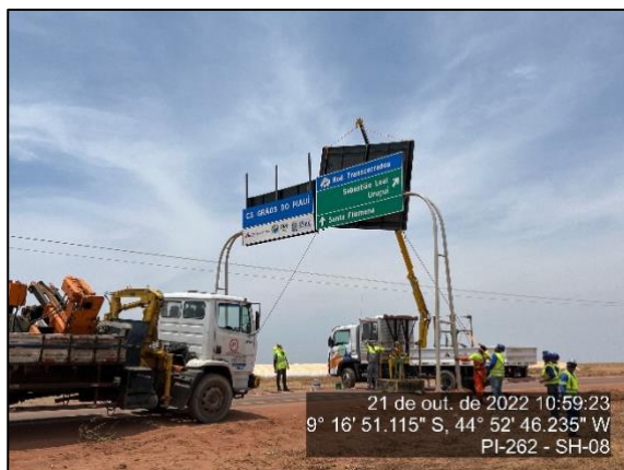
Figura 120 - Implantação de Sinalização Aérea - SH-08 - 1
