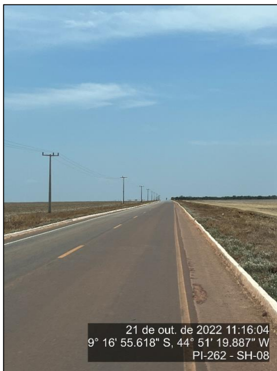
Figura 114 - Buraco no acostamento - SH-08
