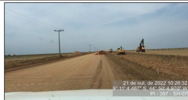
Serviços de terraplenagem em execução no Segmento 07
