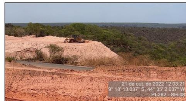
Bota-fora da Obra de correção do traçado da Serra do Quilombo, km 33,65 da Rodovia PI-262, a serviço da SETRANS-PI.
