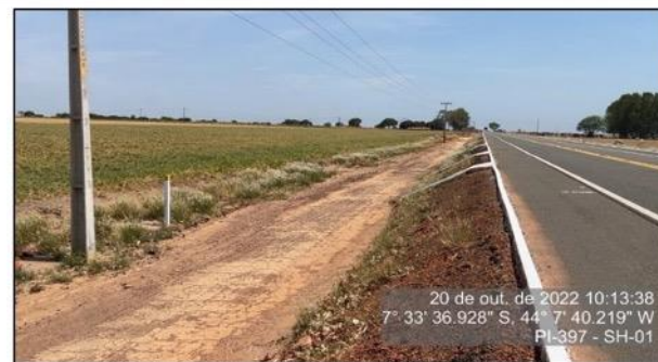
Delimitador de faixa de domínio implantado pela Concessionária
