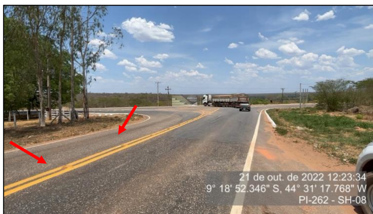
Figura 119 - Tachas refletivas instaladas na interseção - SH-08
