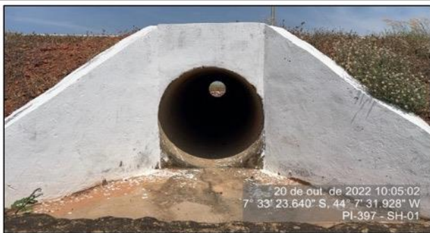
Bueiro simples de drenagem sem obstruções, localizado no KM 0.
