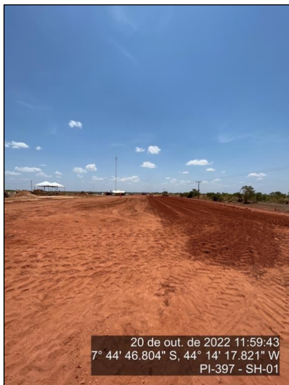
Figura 42 - Execução de terraplenagem Praça P1 – outubro/22
