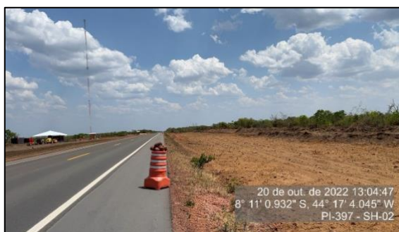
Figura 57 - Limpeza e alargamento da pista - P02
