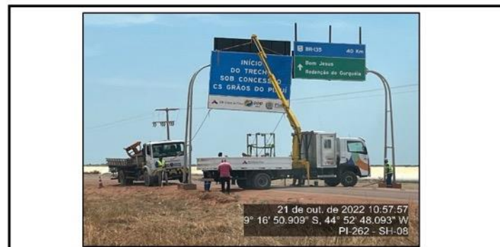
Implantação de sinalização vertical
