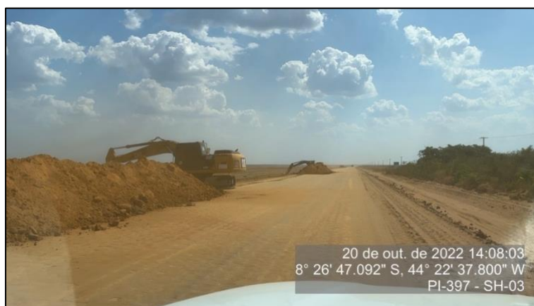
Figura 61 – Frente de serviço de terraplanagem no SH-03
