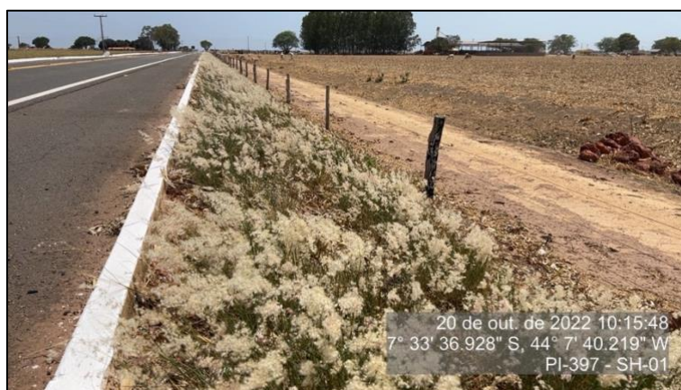
Figura 32 – Terrapleno em boas condições – SH-01
