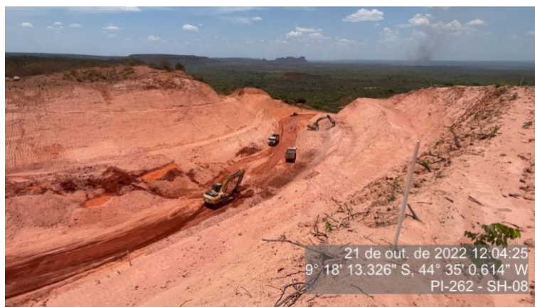
Figura 111 - Obra de correção do traçado do km 33 - SH-08
