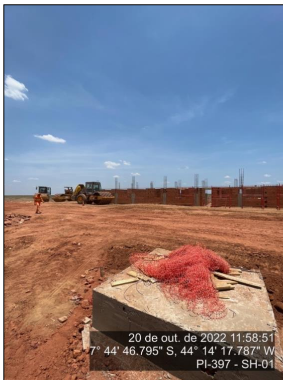
Figura 39 - Execução de fundações na Praça P1 – outubro/22
