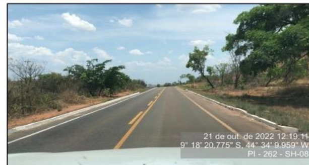
Pavimento e sinalização horizontal em bom estado
