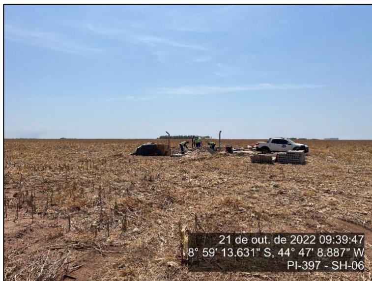
Figura 97 - Obra de torre de comunicação - SH-06
