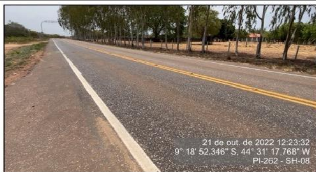
Sinalização horizontal implantada no Trevo do final do Segmento 08
