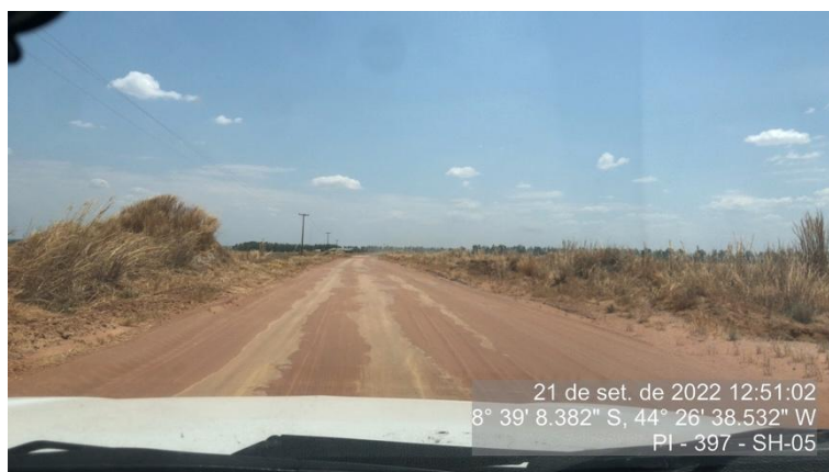
Figura 1 - Postes Existentes - SH-05
