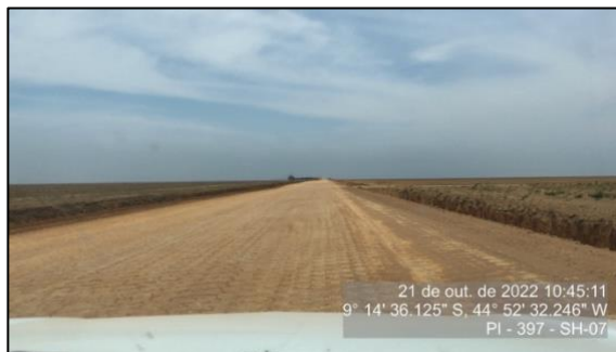
Figura 107 – Plataforma de terraplanagem acabada – SH-07
