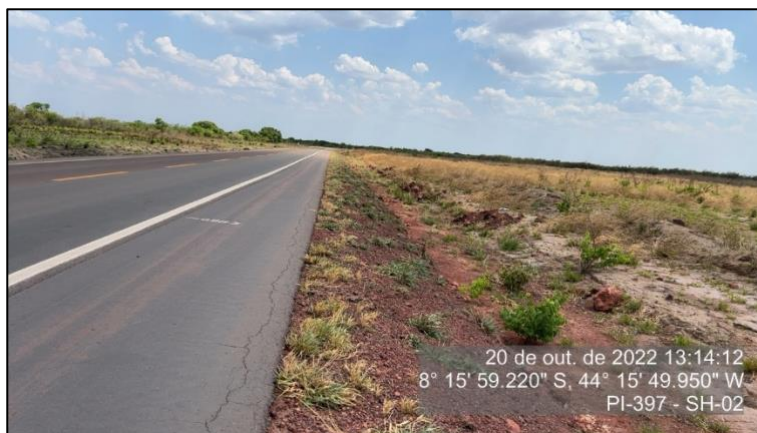
Figura 52 - Talude com cobertura vegetal - SH-02
