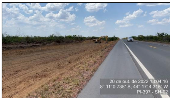
Figura 59 - Equipamento de terraplenagem em serviço - P02
