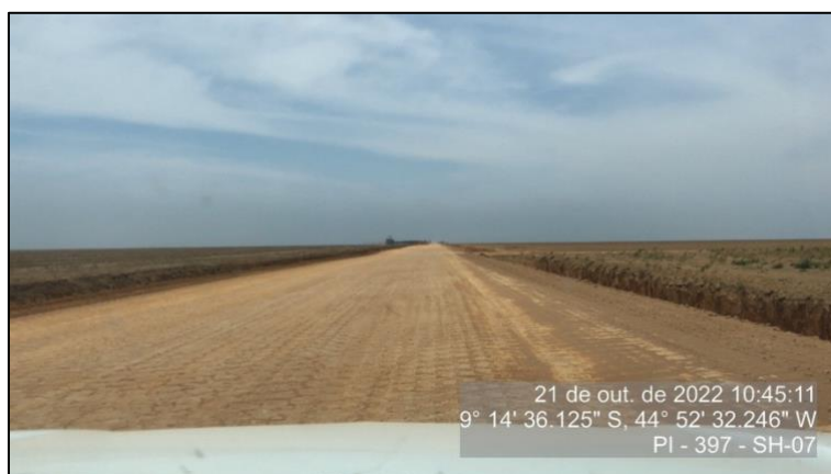
Figura 103 - Plataforma da rodovia após serviços de terraplenagem - SH-07
