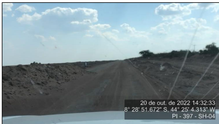
Figura 76 - Final dos serviços de escavação e depósito na pista - SH-04
