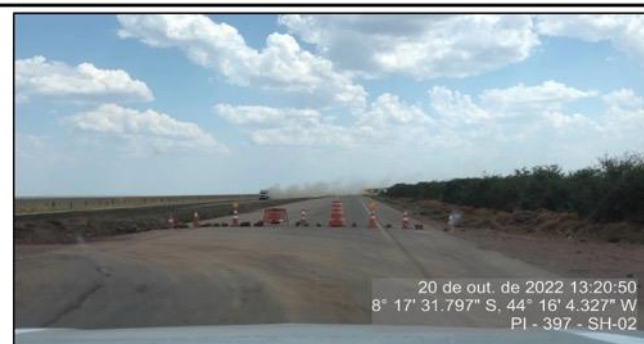
Fim do Segmento 02 e Início das obras do SH-03
