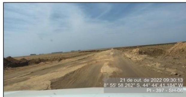
Ponto com irregularidade que formam batentes e com baixa trafegabilidade
