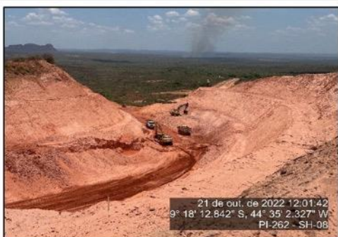
Obra de correção do traçado da Serra do Quilombo, km 33,65 da Rodovia PI-262, a serviço da SETRANS-PI.
