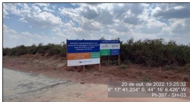
Início do segmento homogêneo 3 – segmento não pavimentado.
