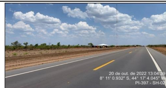
Canteiro de obras da P2 - SH-02
