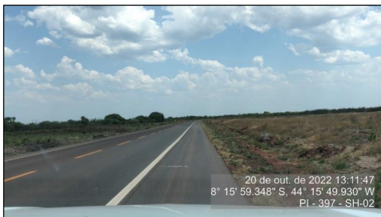
Figura 53 - Talude com cobertura vegetal e vegetação lateral baixa - SH-02
