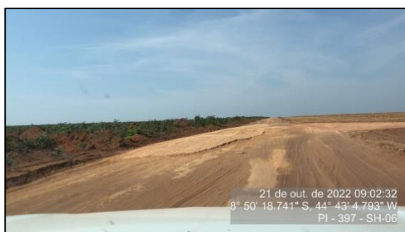
Figura 91 - Batente formado pela compactação do material do subleito - SH-06 - 5
