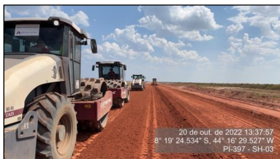
Figura 66 – Execução de aterro, base e sub-base (1) - SH-03
