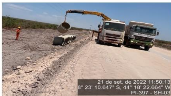
Mobilização de materiais para a implantação dos dispositivos de drenagem.
