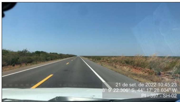
Figura 48 - Pavimento da faixa de rolamento em boas condições
