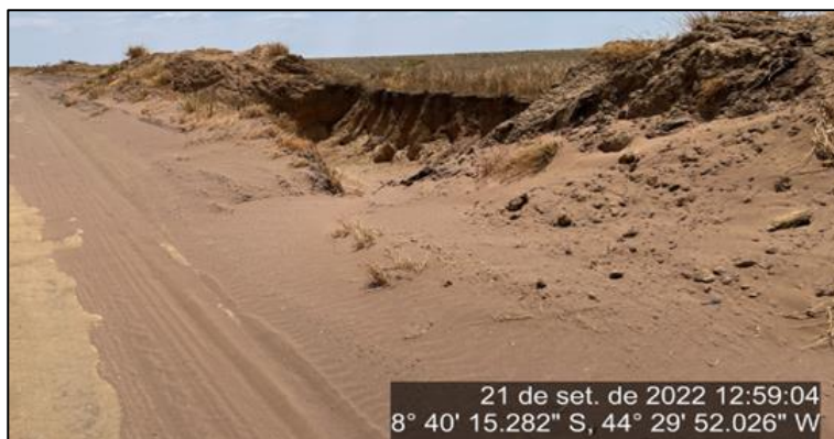
Figura 84 – Poço de drenagem – SH-05
