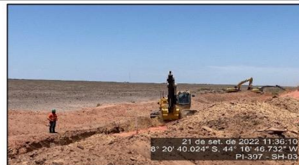
Escavação de caixa de empréstimo e bota-dentro.
