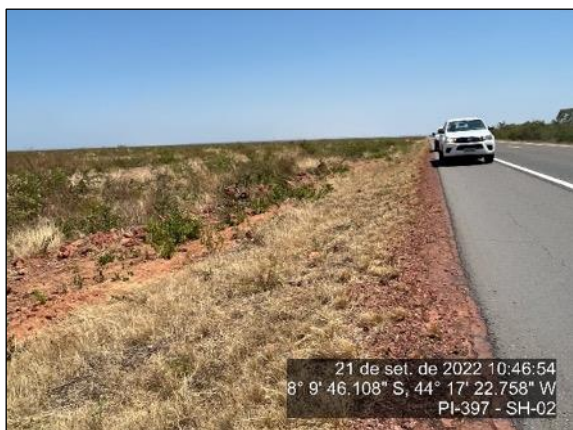
Figura 53 - Cobertura vegetal nos taludes da pista - 1
