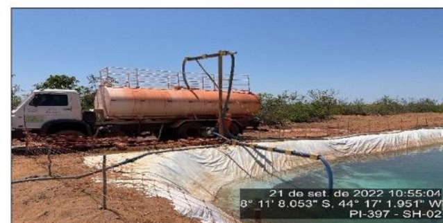
Reservatório de água do canteiro da P2
