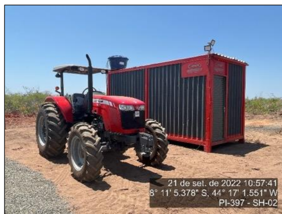
Figura 59 - Trator mobilizado no canteiro
