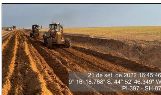
Figura 115 – Execução de terraplenagem no SH 07 – setembro/22
