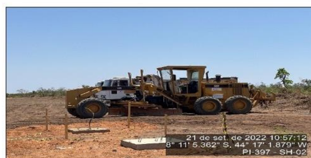
Equipamentos de terraplenagem no canteiro da P2
