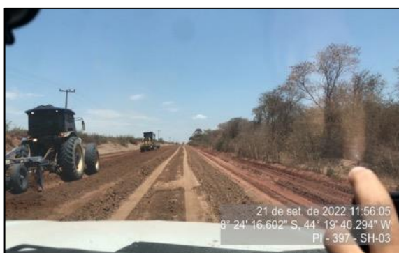
Figura 71 – Serviço de terraplanagem – SH-03
