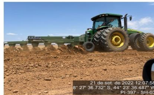
Serviço de terraplenagem sendo executado no segmento.
