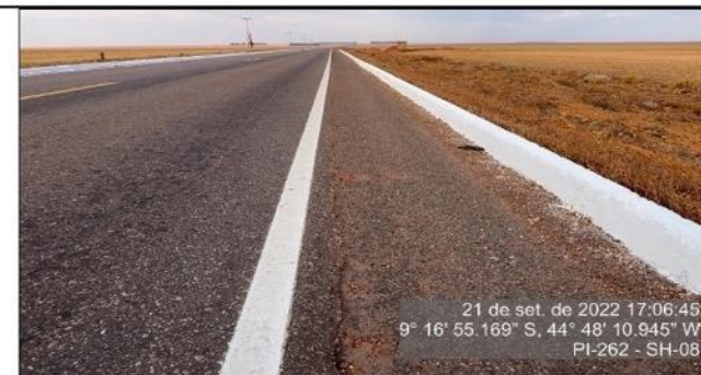
Linha de bordo e meio-fio da pista em bom estado.
