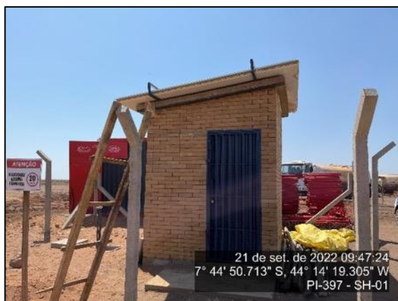
Figura 46 – Torre de comunicação da P01 – setembro/22
