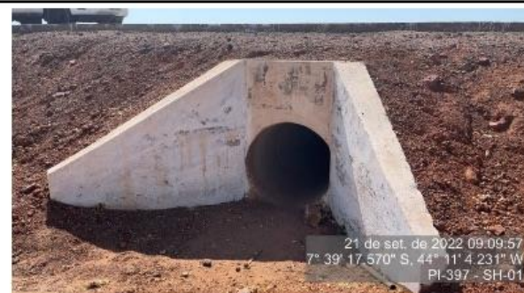
Bueiro simples de drenagem sem obstruções, localizado no KM 12,7.
