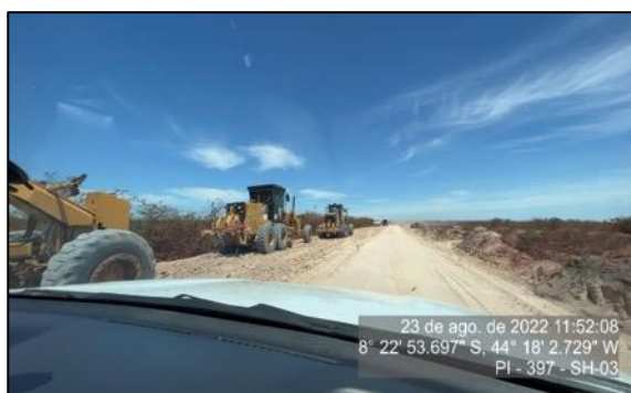
Figura 69 – Obras de melhoria e ampliação no mês de agosto/22 - SH-03
