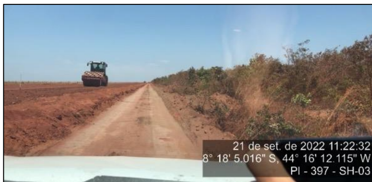
Figura 66 – Frente de serviço de terraplanagem no SH-03
