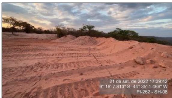
Figura 136 – Topo do depósito de material escavado (bota-fora)
