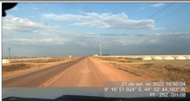
Início do segmento homogêneo 8 - segmento pavimentado.
