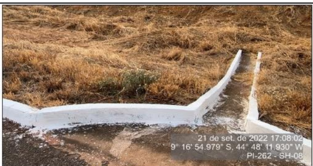
Descida d'água sem obstruções e em perfeito funcionamento.
