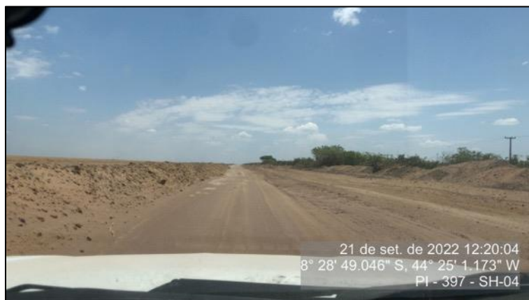
Figura 79 - Material depositado na pista - SH-04
