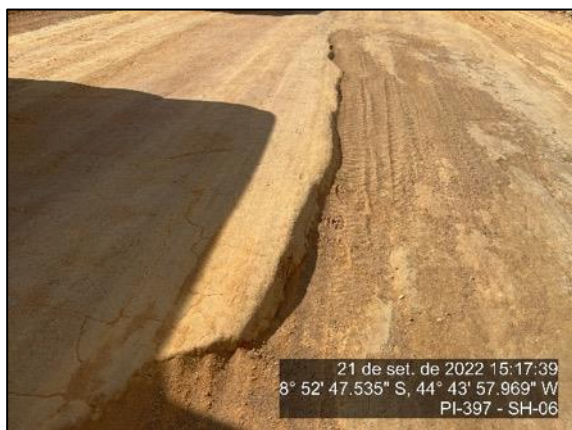
Figura 95 - Batente formado pela compactação do material do subleito - SH-06 - 1
