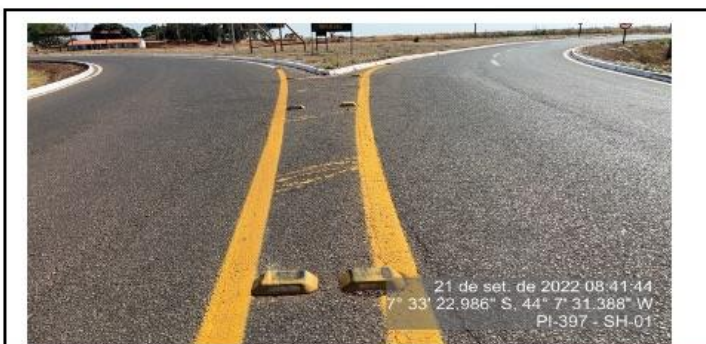
Tachas refletivas na interseção da Transcerrados com a PI-PI-247 / BR 324, cumprindo o indicador do item 5.2.2 do PER.
