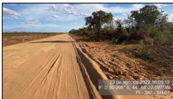
Figura 106 – Faixa de domínio após o serviço de limpeza da vegetação em agosto/22 – SH 07
