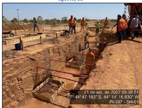
Figura 41 – Execução de fundação da Praça P1 – setembro/22
