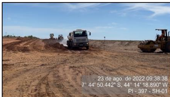
Figura 39 – Execução de terraplenagem na Praça P1 – agosto/22
