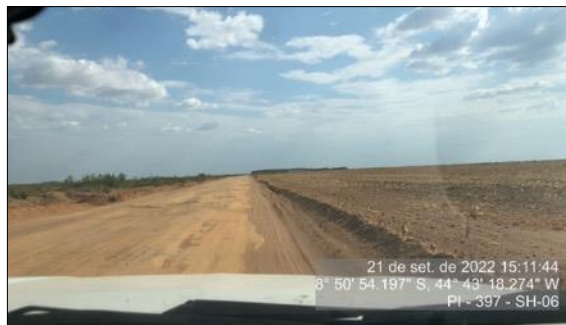
Figura 100 - Trecho sujeito a alagamento no mês de setembro/22 - SH-06
