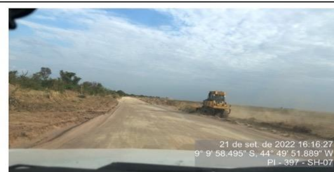
Maquinário da Concessionária realizando o serviço de limpeza da vegetação na faixa de domínio .
