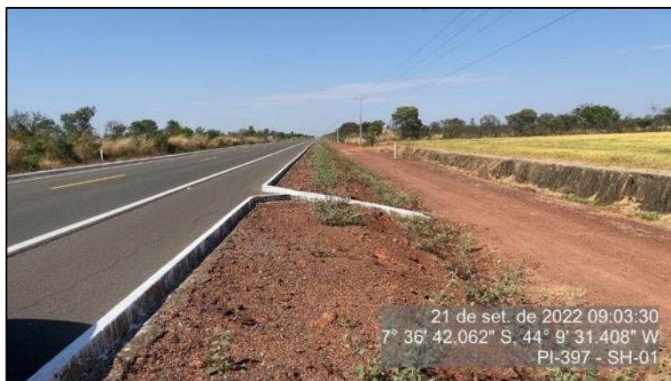
Figura 37 – Faixa de domínio limpa – SH-01
