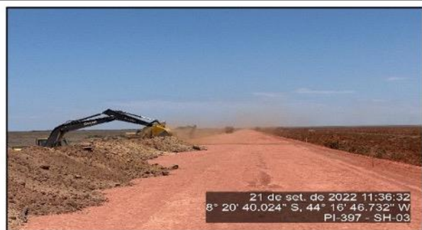
Depósito do material escavado na pista.
