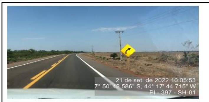
Implantação da sinalização vertical no segmento.
