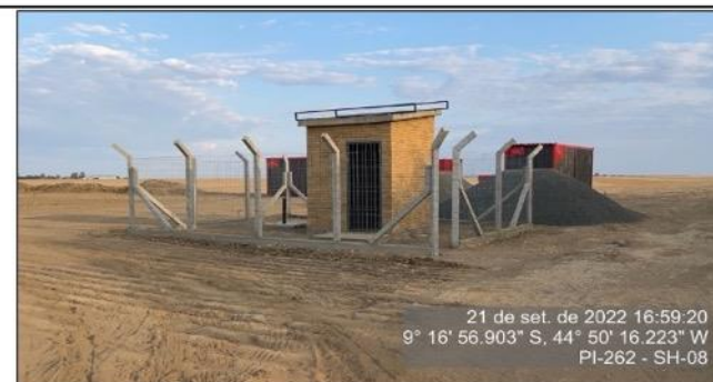
Edificação da torre de comunicação da P4.
