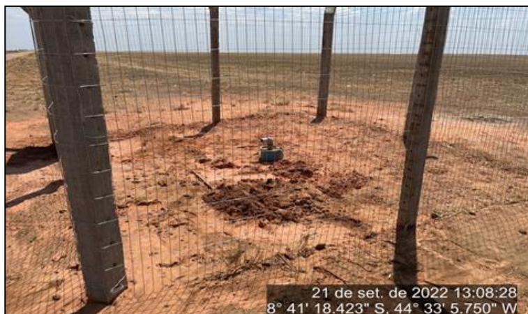
Figura 90 – Poço de abastecimento da Praça de Pedágio P3 – SH-05
