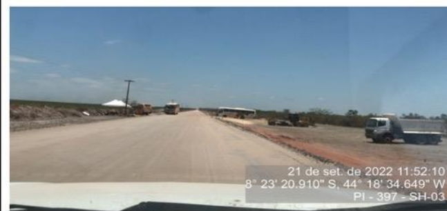
Serviços de melhoria e ampliação no segmento - Área de vivência.
