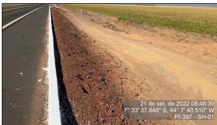
Figura 33 – Terrapleno em boas condições – SH-01
