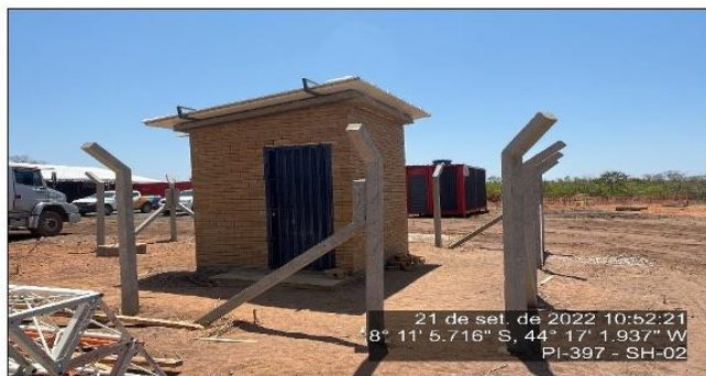
Edificação da torre de comunicação da P2
