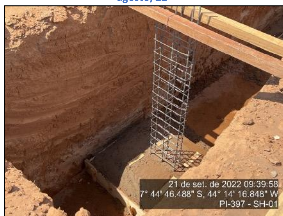
Figura 42 – Execução de fundação da Praça P1 – setembro/22
