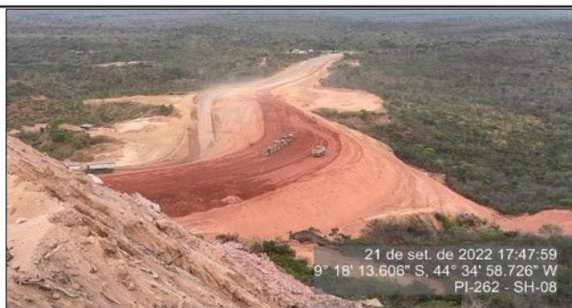
Obra de correção do traçado da Serra do Quilombo, km 33,65 da Rodovia PI-262, a serviço da SETRANS-PI.
