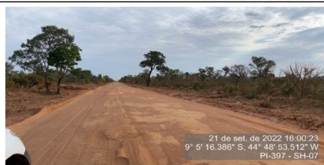
Bordos da pista após o serviço de limpeza da vegetação na faixa de domínio .
