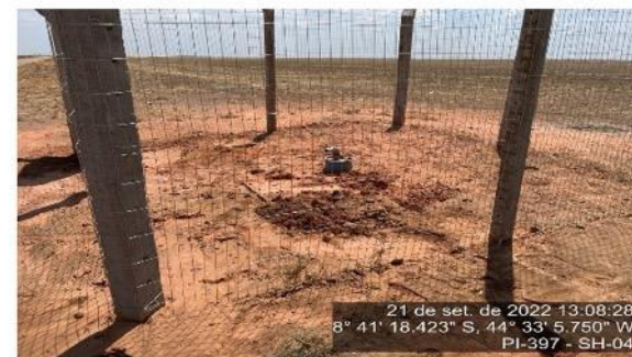
Poço de água da Praça de Pedágio P3 já implantado pela Concessionária.
