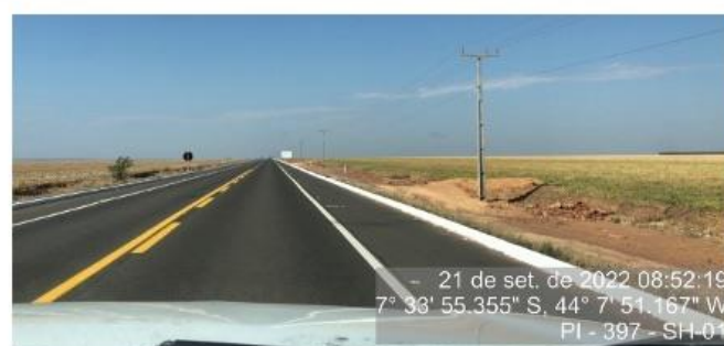
Sinalização horizontal (pintura) em boas condições.
