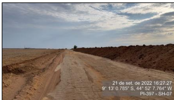
Figura 113 – Depósito do material escavado na pista – setembro/22 – SH 07
