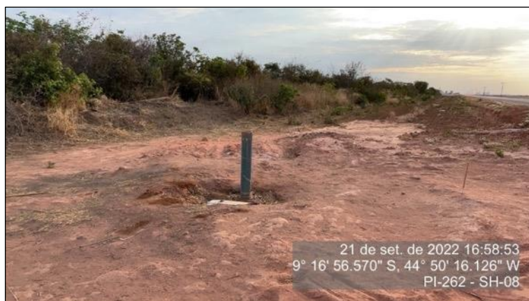
Figura 133 - Poço de abastecimento d'água - Praça de Pedágio P4
