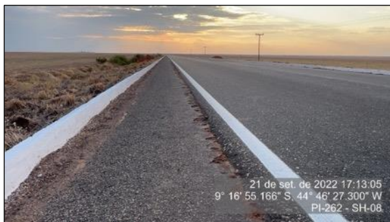
Figura 128 - Meio fio da pista - SH-08
