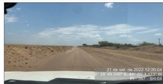
Depósito de material na lateral da pista, originado da escavação do bordo da pista do Segmento 04
