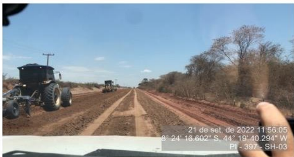
Serviço de terraplenagem sendo executado no segmento.
