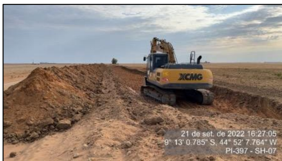
Figura 112 – Escavação do material do bordo da pista – setembro/22 – SH 07
