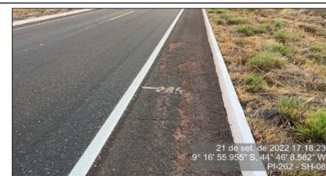
Buraco no acostamento do Segmento 08
