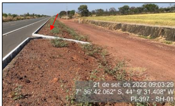
Figura 27 – Descida d'água desobstruída e em boas condições – SH-01
