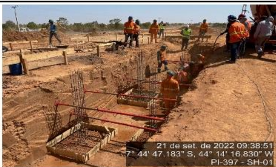
Obras das instalações da praça de pedágio 01.
