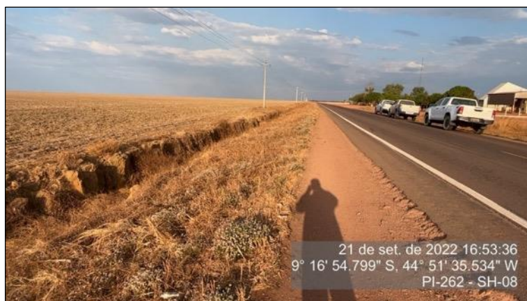
Figura 130 - Terrapleno com cobertura vegetal - SH-08
