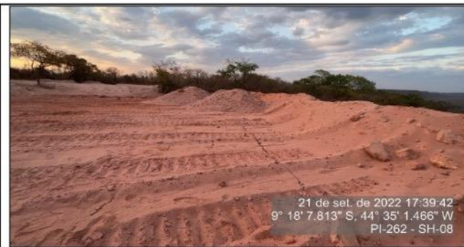
Bota-fora da Obra de correção do traçado da Serra do Quilombo, km 33,65 da Rodovia PI-262, a serviço da SETRANS-PI.
