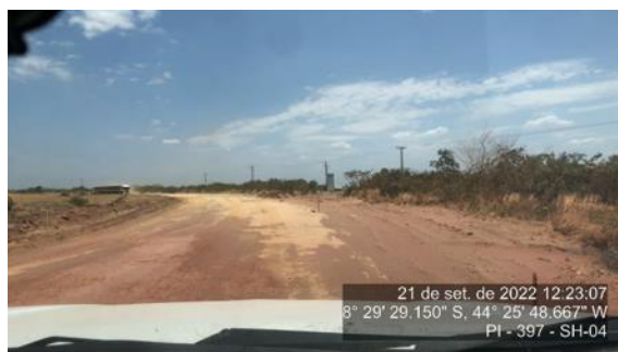
Figura 80 - Final da limpeza do SH-04
