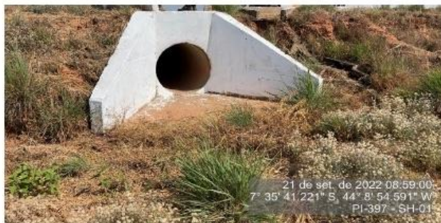
Bueiro simples de drenagem sem obstruções, localizado no KM 0.
