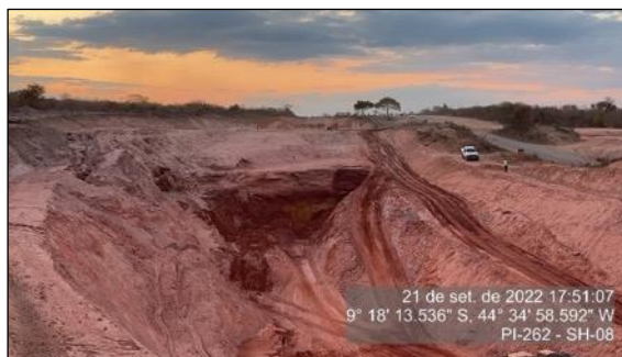
Figura 125 - Obra de correção do traçado do Km 33 - Início da Subida da Serra do Quilombo - SH-08-2
