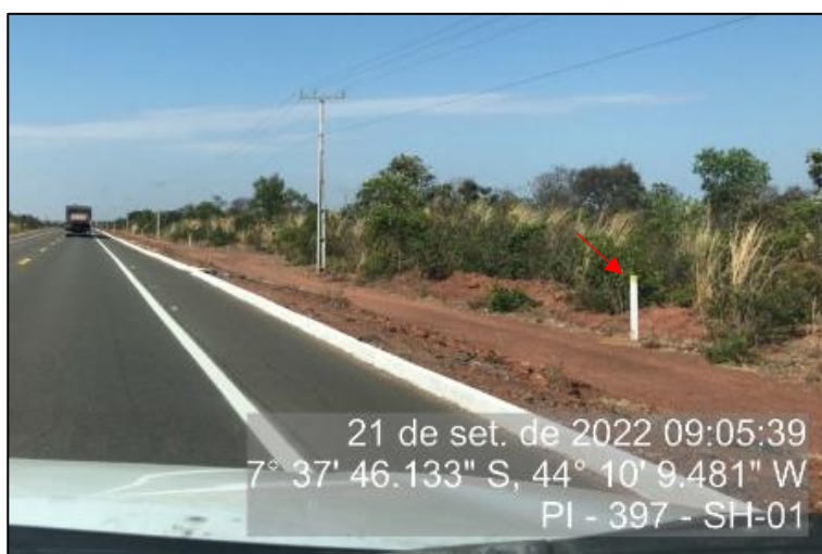
Figura 38 – Delimitadores da faixa de domínio – SH-01
