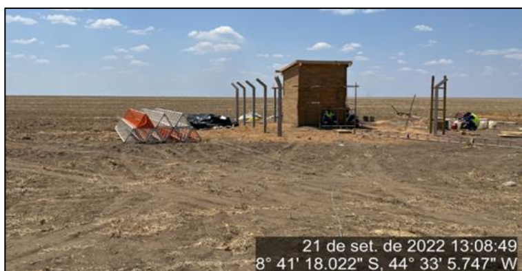
Figura 91 – Torre de comunicação da Praça de Pedágio P3 – SH-05
