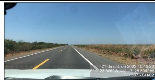
Pavimento asfáltico em boas condições para tráfego. Sinalização horizontal (pintura) em boas condições.
