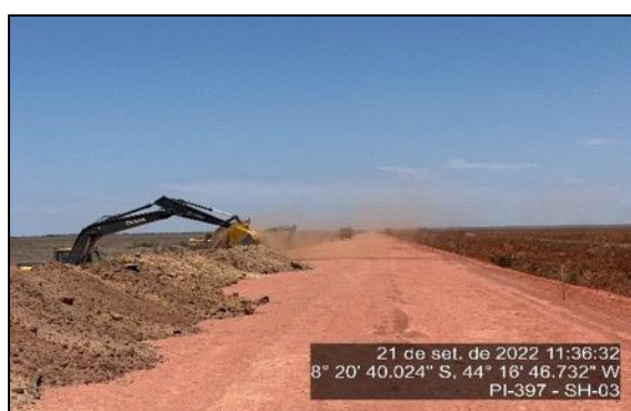
Figura 74 – Depósito do material escavado na pista – SH-03
