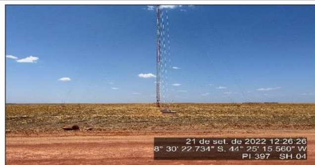
Torre de comunicação implantada no Segmento 04
