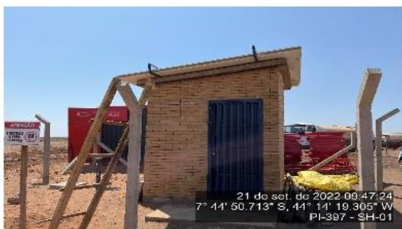
Cabine da torre de comunicação da Praça de Pedágio 01.
