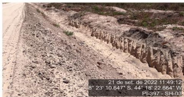
Talude e caixa de empréstimo
