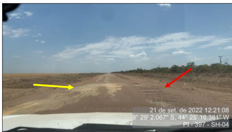
Figura 76 - Superfície do pavimento em leito natural - SH-04
