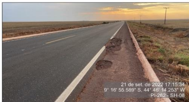
Buraco no acostamento do Segmento 08
