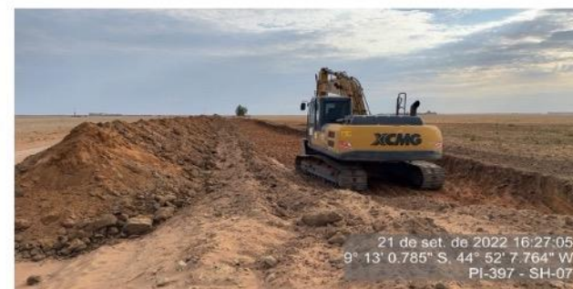
Escavação do material do bordo da pista.
