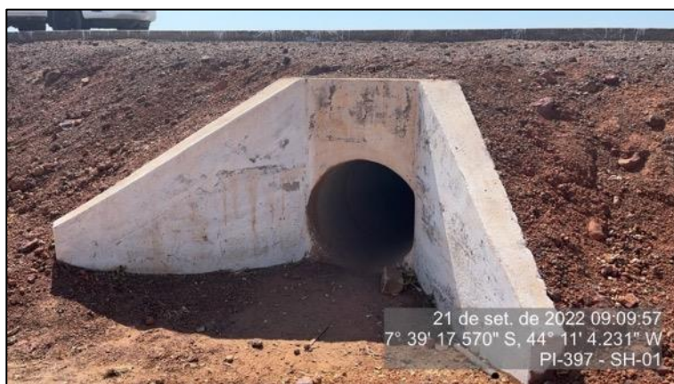
Figura 30 – Bueiro simples 03 localizado no KM 12,70 do segmento – SH1.
