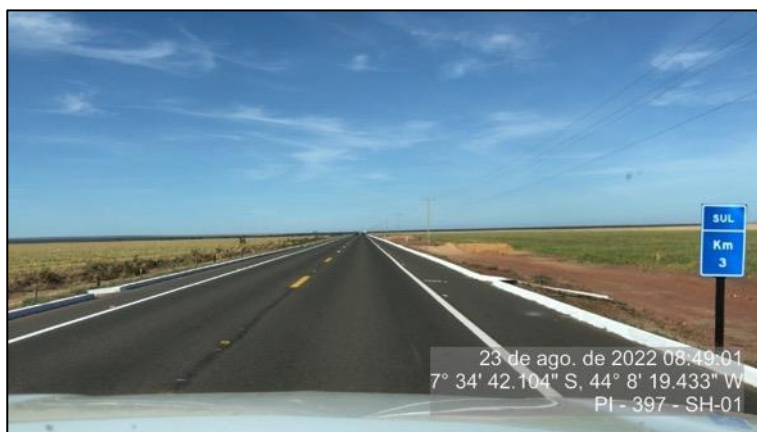
Figura 23 – Sinalização vertical implantada no mês de agosto/22 – SH1.
