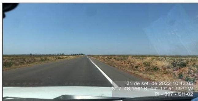
Início do segmento homogêneo 2 - segmento pavimentado. Ainda precisando de complementação na sinalização horizontal.
