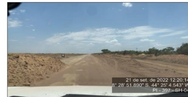
Final do trecho em serviço de terraplenagem
