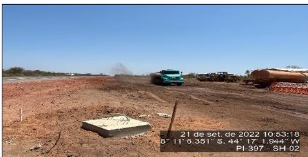
Serviços de terraplenagem em execução na P2
