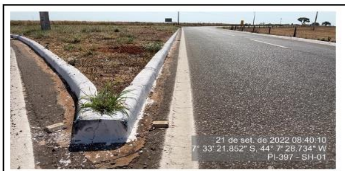
Trevo da interseção da Transcerrados(PI-397) com a PI-247 / BR 324 após os serviços de capina e roçada.
