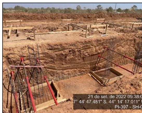
Figura 44 – Execução de fundação da Praça P1 – setembro/22
