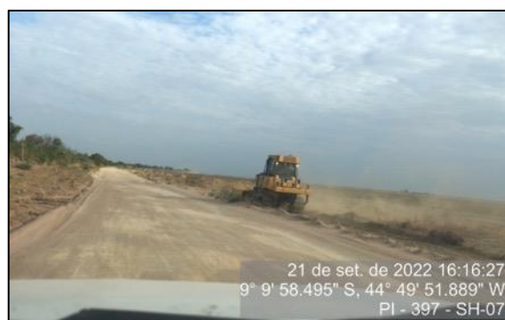
Figura 109 – Maquinário realizando o serviço de limpeza na faixa de domínio – SH 07
