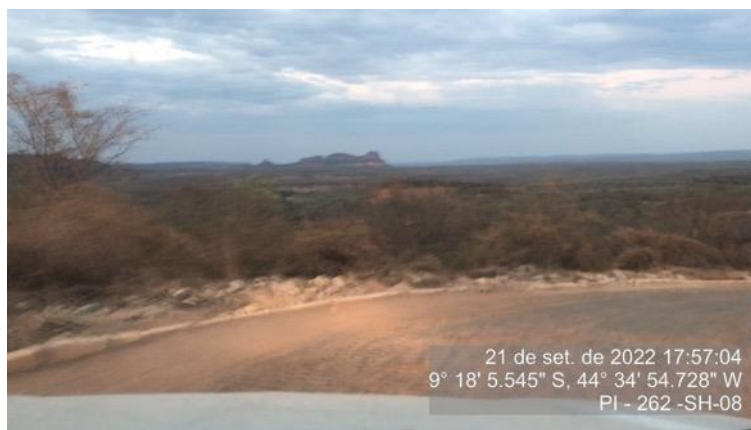
Figura 139 - Pavimento da subida da Serra do Quilombo
