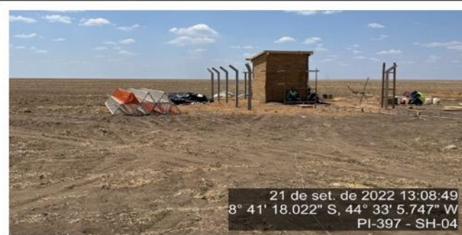
Torre de comunicação da Praça de Pedágio P3 em implantação pela Concessionária.
