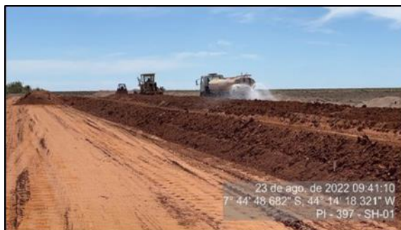
Figura 40 – Execução de terraplenagem na Praça P1 – agosto/22
