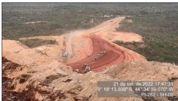
Figura 124 - Obra de correção do traçado do Km 33 - Início da Subida da Serra do Quilombo - SH-08-1
