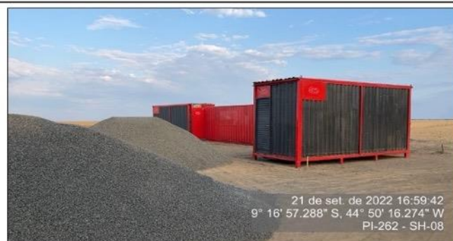
Início da instalação do Contêiner de Obras da Paraça P04
