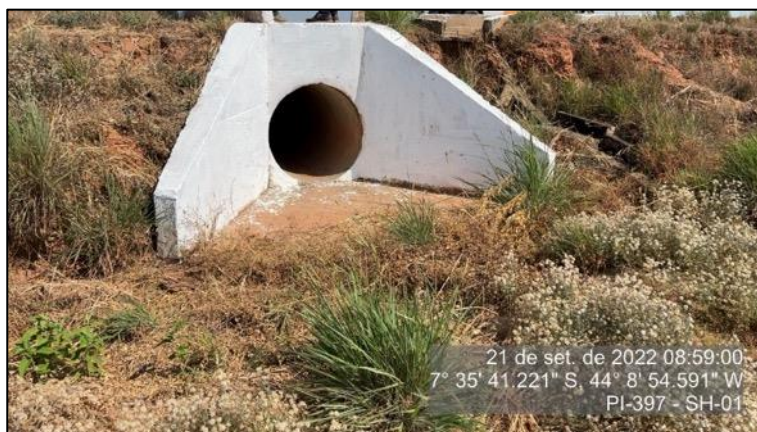
Figura 29 – Bueiro simples 01 localizado no KM 0 do segmento – SH1.
