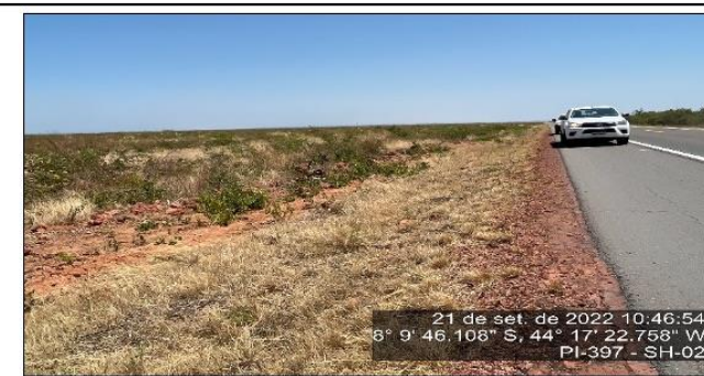
Talude lateral da pista - lado direito sentido decrescente da pista.
