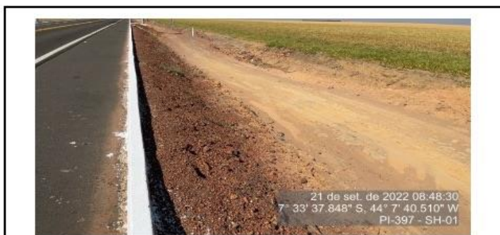
Talude de aterro em boas condições.
