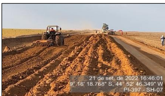
Figura 114 – Execução de terraplenagem no SH 07 – setembro/22
