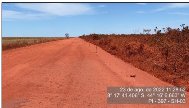
Figura 65 - Marcação topográfica das obras no SH-03
