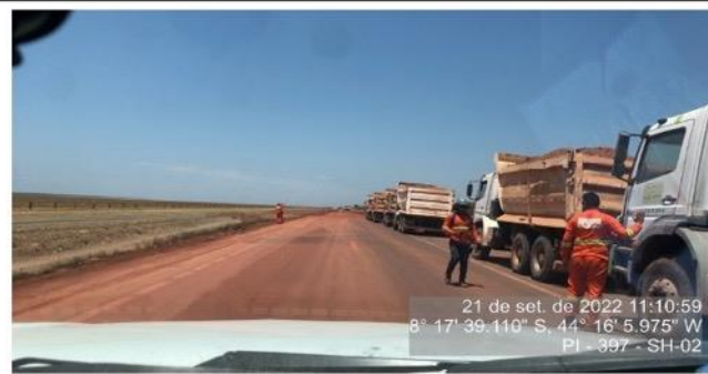
Final do Segmento 2. Entrada para as obras de Melhoria e Ampliação do SH-03
