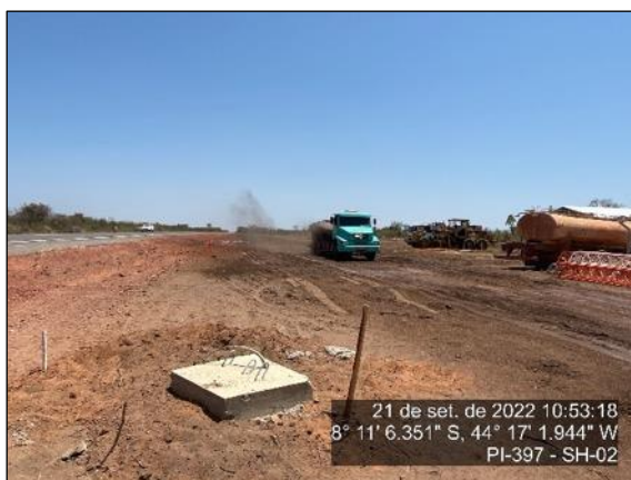
Figura 58 - Serviços de terraplenagem
