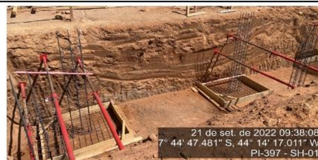
Obras das instalações da praça de pedágio 01.
