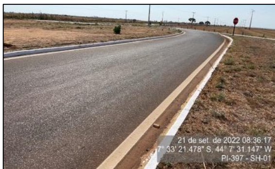
Figura 28 - Drenagem desobstruída e em boas condições – SH-01
