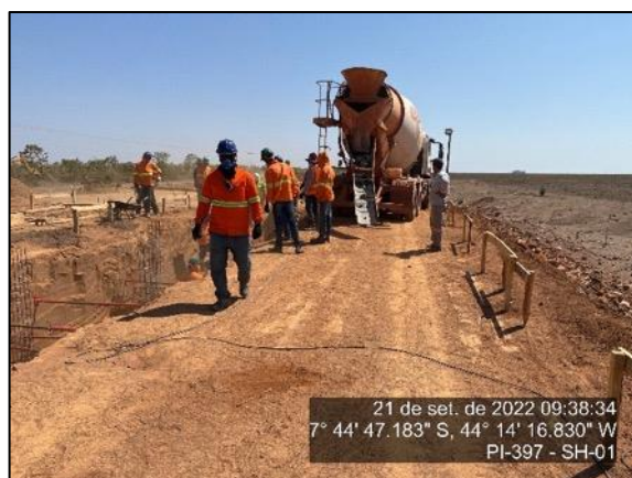
Figura 43 – Execução de fundação da Praça P1 – setembro/22
