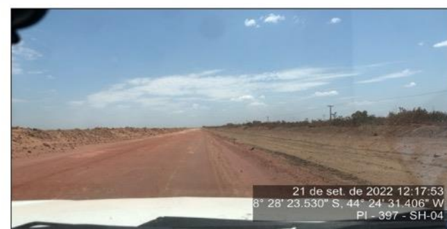
Trecho em serviço de terraplenagem
