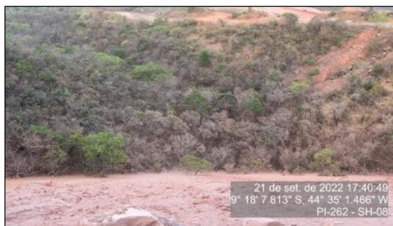
Figura 137 - Talude de bota-fora avançando sobre vegetação nativa
