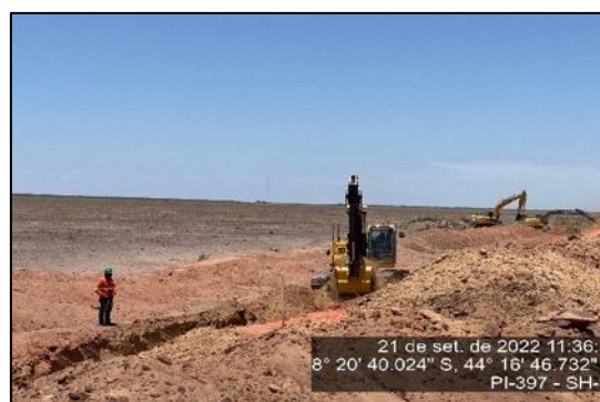
Figura 72 – Escavação do material do bordo da pista – SH-03
