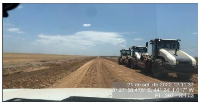
Frentes de serviço das obras do SH-03 na interseção com o SH-04
