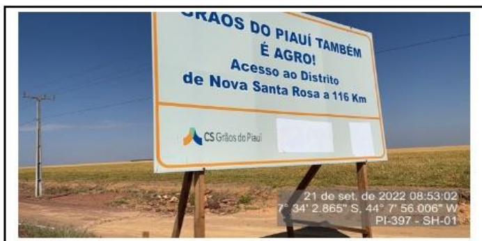
Sinalização vertical, placa informativa, com fixação de madeira implantada pela Concessionária.
