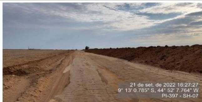
Depósito do material escavado na pista.
