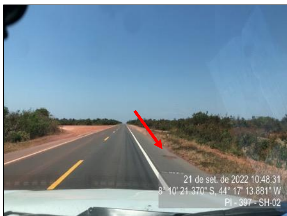
Figura 63 – Buraco no acostamento do SH-02
