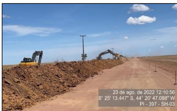
Figura 70 – Obras de melhoria e ampliação no mês de agosto/22 - SH-03
