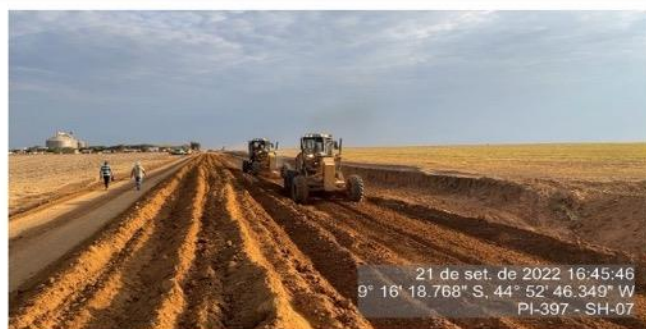
Execução de terraplenagem das obras de ampliação e melhoria no segmento.
