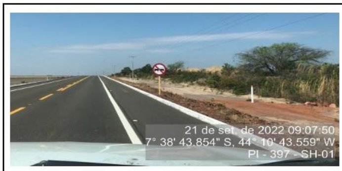
Implantação da sinalização vertical no segmento.
