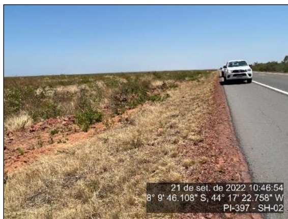
Figura 54 - Cobertura vegetal nos taludes da pista - 2
