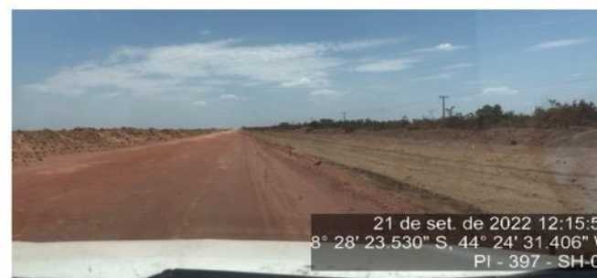
Final do segmento homogêneo 3 – segmento não pavimentado.
