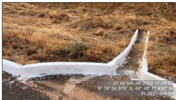
Figura 129 - Descida d'água - SH-08
