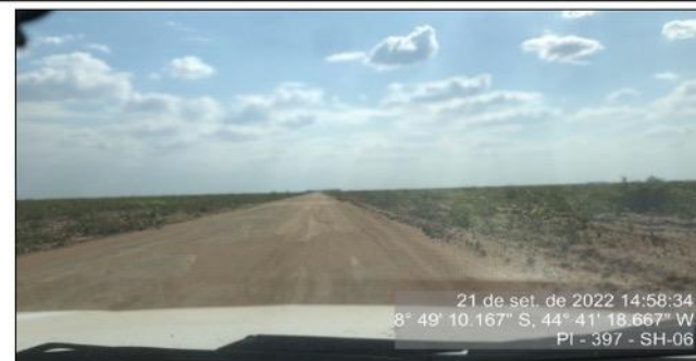
Trecho do segmento com abaulamento transversal
