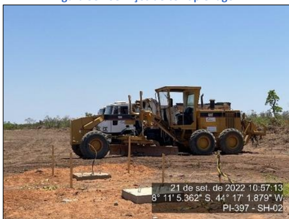
Figura 60 - Equipamentos de terraplenagem
