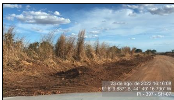
Figura 107 – Faixa de domínio após o serviço de limpeza da vegetação em agosto/22 – SH 07
