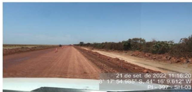
Início do segmento homogêneo 3 – segmento não pavimentado.
