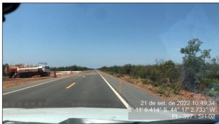
Figura 57 - Canteiro de obras da P2
