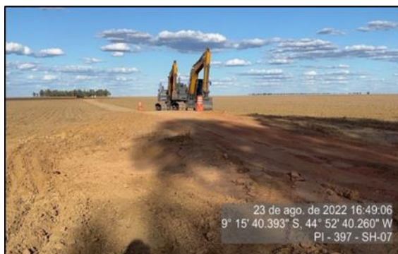
Figura 111 – Mobilização de equipamentos para as obras de melhoria e ampliação - agosto/22- SH 07
