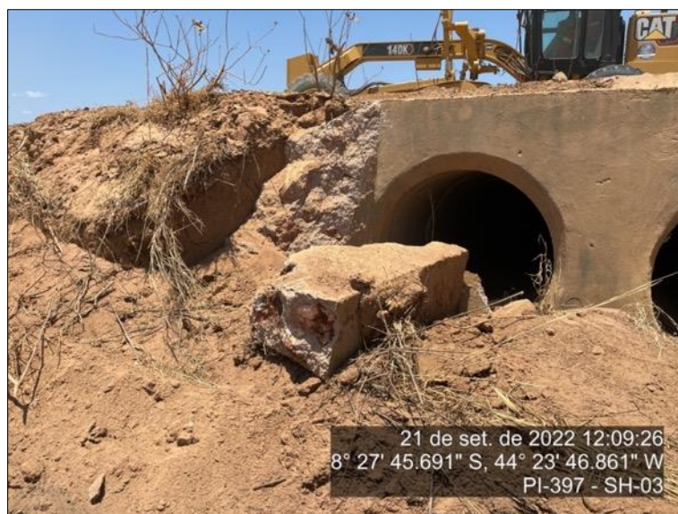
Figura 67 - Bueiro duplo não identificado no Georreferenciado no SH-03
