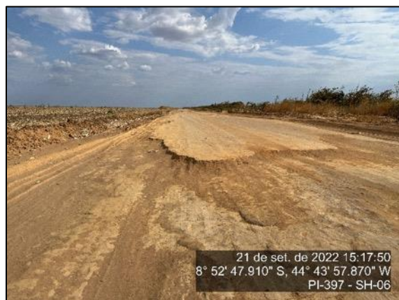
Figura 96 - Batente formado pela compactação do material do subleito - SH-06 - 2
