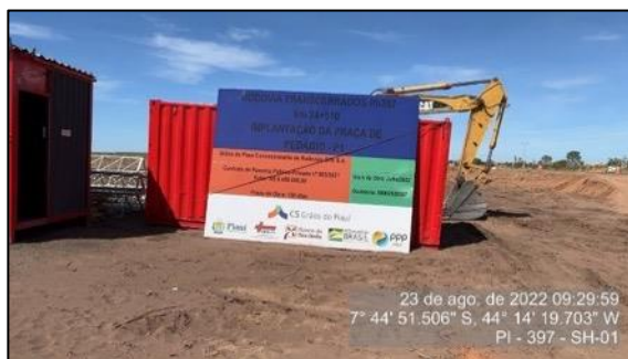
Figura 45 – Placa de obra – agosto/22
