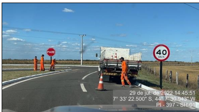
Figura 20 – Sinalização vertical sendo implantada no mês de julho/22 – SH1.
