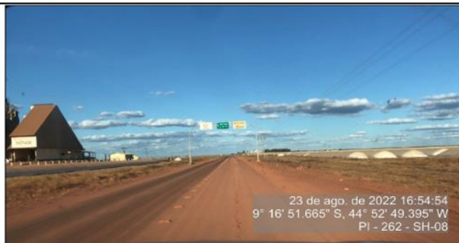
Início do segmento homogêneo 8 - segmento pavimentado.
