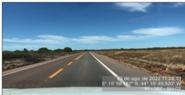
Pavimento em boas condições de trafegabilidade.
