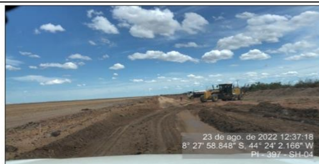
Final do trecho em serviço de terraplenagem
