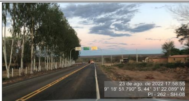
Final do segmento homogêneo 8 - sinalização horizontal conservadas.
