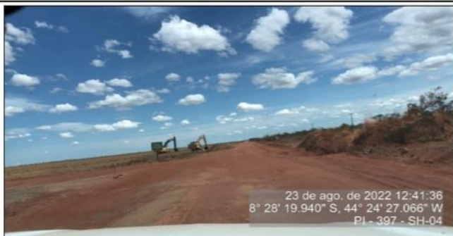
Equipamentos realizando serviço de escavação do bordo da pista do Segmento 04
