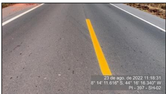
Figura 53 - Sinalização horizontal no SH-02 (agosto/22) - 1
