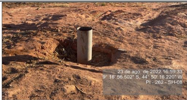
Poço de água da Praça de Pedágio P4 já implantado pela Concessionária.
