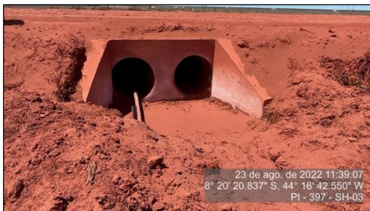
Figura 72 - Bueiro duplo de acordo com o Georreferenciado - SH-03
