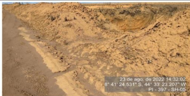
Poço de drenagem em perfeitas condições.
