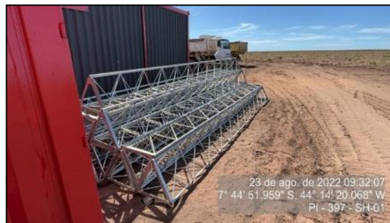
Figura 49 – Material para a instalação da torre – agosto/22
