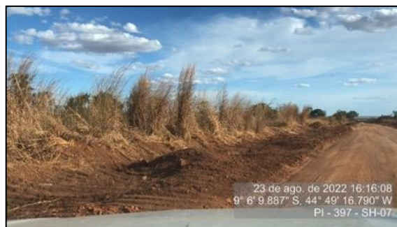
Figura 120 – Faixa de domínio após o serviço de limpeza da vegetação – SH 07
