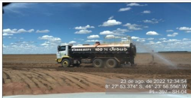
Caminhão pipa em serviço no início do segmento 04
