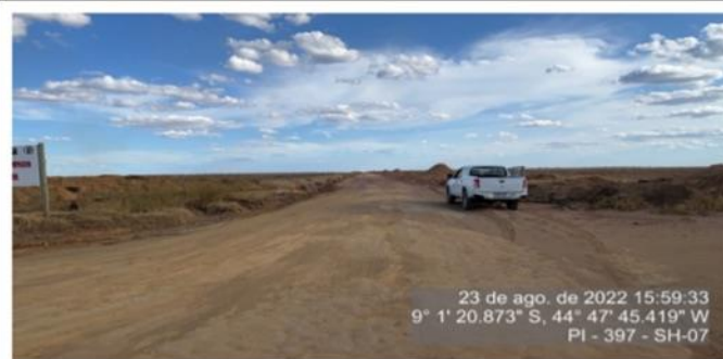
Início do segmento homogêneo 7 - segmento em leito natural.
