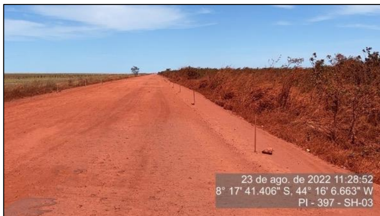
Figura 71 - Marcação topográfica das obras no SH-03
