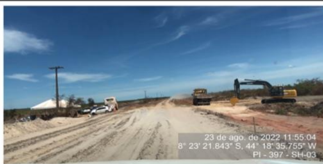
Obras de Melhoria e Ampliação no segmento.
