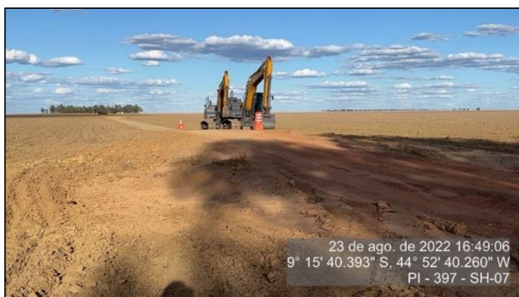
Figura 124 – Escavadeiras mobilizadas para a execução das obras - SH 07
