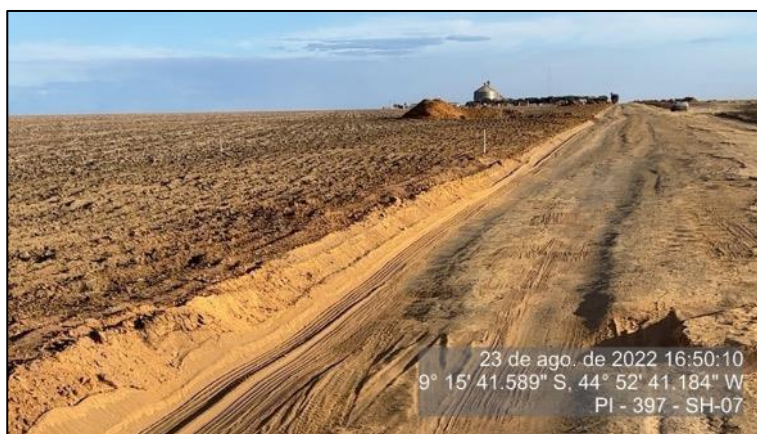
Figura 125 – Bordos da pista limpo e com estaqueamento - SH 07
