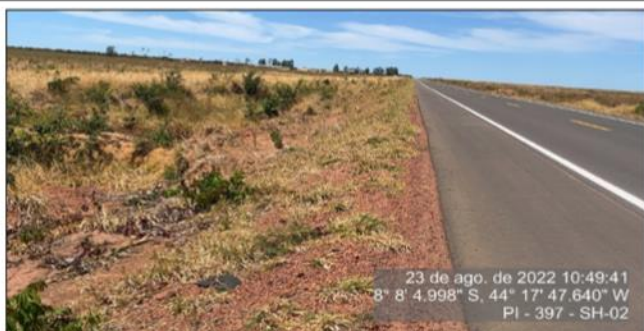
Talude lateral da pista - lado esquerdo sentido crescente da pista.
