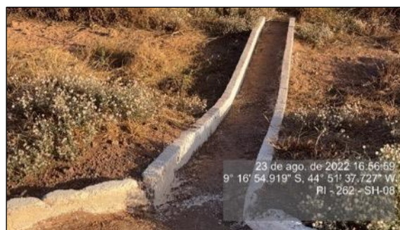
Figura 139 - Descida d'água-SH-08
