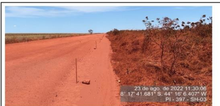
Marcação topográfica no segmento para implantação das obras de Melhoria e Ampliação.
