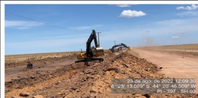
Escavação de caixa de empréstimo e bota-dentro.
