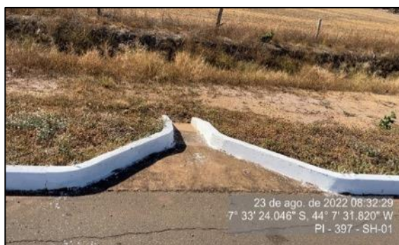
Figura 25 - Drenagem desobstruída e em boas condições – SH-01
