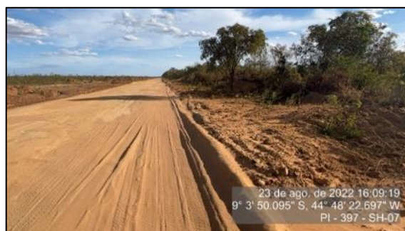
Figura 122 – Faixa de domínio após o serviço de limpeza da vegetação – SH 07
