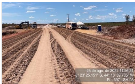
Figura 80 – Material compactado na pista – SH-03
