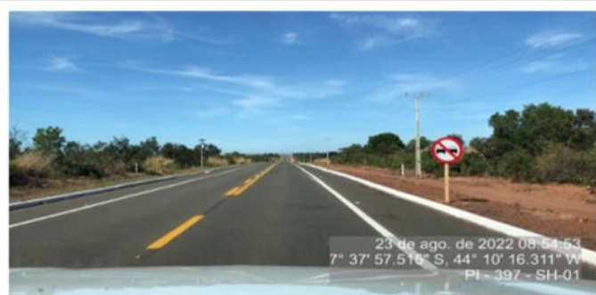
Implantação da sinalização vertical no segmento.
