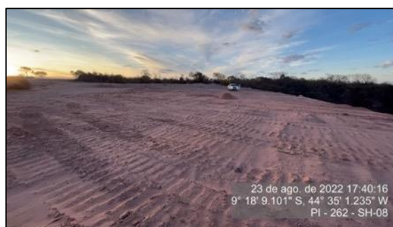
Figura 146 – Topo do depósito de material escavado (bota-fora)
