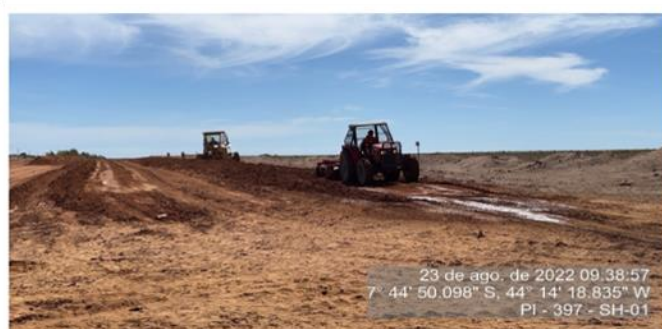
Equipe de serviço realizando o serviço de terraplenagem.
