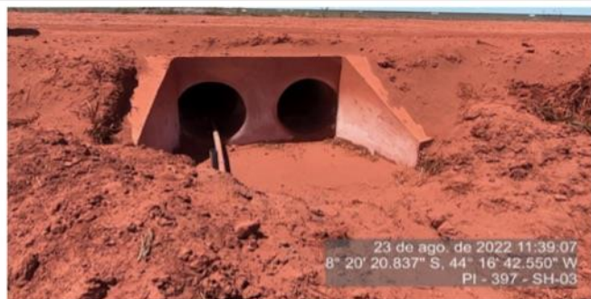
Bueiro duplo localizado no KM 97,4 do segmento, não está danificado ou obstruído.
