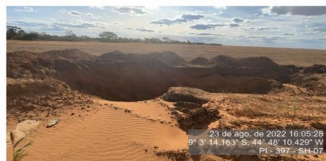
Poço de drenagem.
