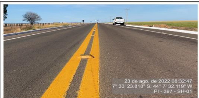
Sinalização horizontal (pintura) em boas condições.
