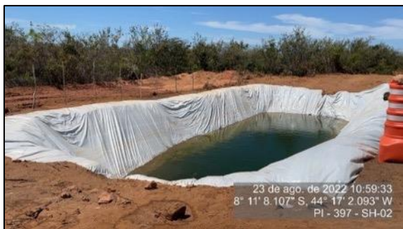
Figura 66 - Reservatório de água da P2 - 1
