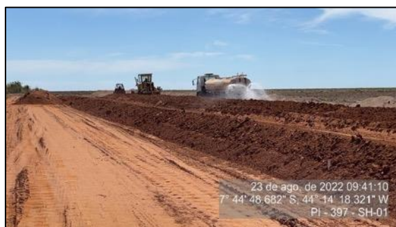
Figura 40 - Execução de terraplenagem na Praça P1 – agosto/22
