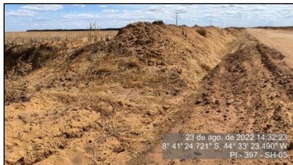
Figura 93 – Valeta de drenagem – SH-05
