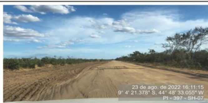
Bordos da pista após o serviço de limpeza da vegetação na faixa de domínio .
