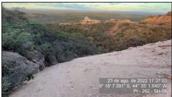
Figura 147 - Talude de bota-fora avançando sobre mata nativa - 2
