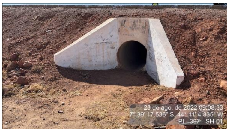
Figura 28 – Bueiro simples 03 localizado no KM 12,70 do segmento – SH1.
