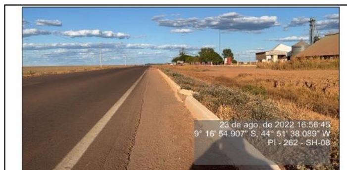
Linha de bordo e meio-fio da pista em bom estado.
