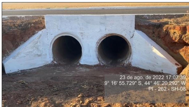
Figura 137 - Bueiro do Segmento 08
