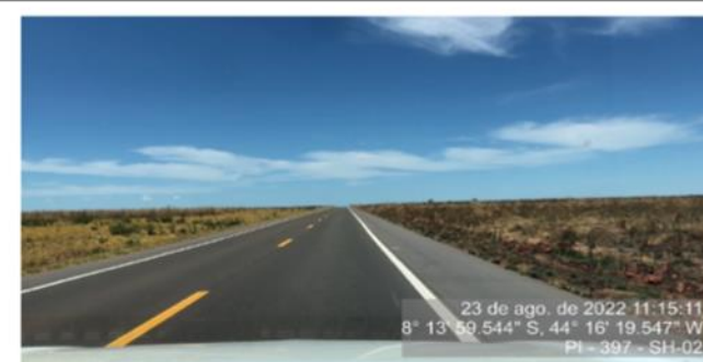
Pintura em boas condições.
