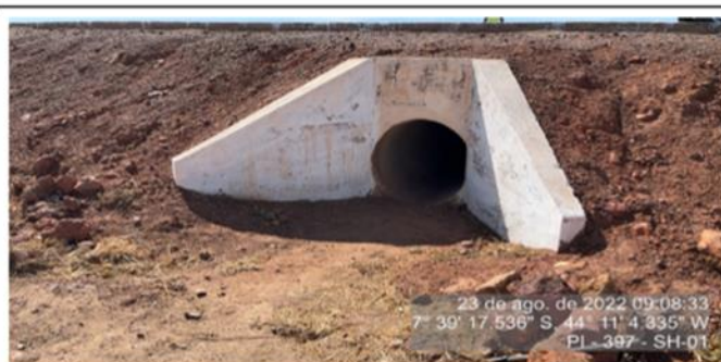
Bueiro simples de drenagem sem obstruções, localizado no KM 12,7.
