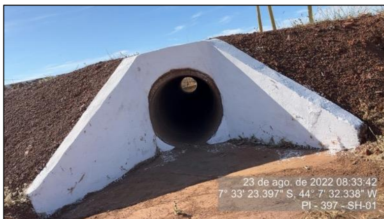
Figura 26 – Bueiro simples 01 localizado no KM 0 do segmento – SH1.
