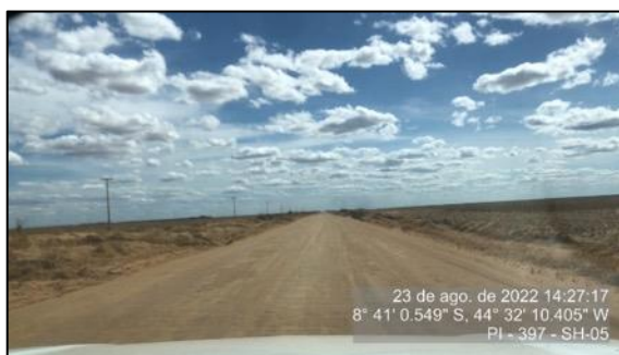
Figura 96 – Leito estradal após intervenção da Concessionária – SH-5
