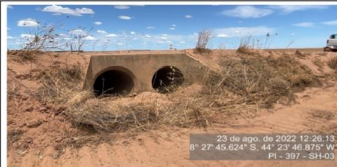
Bueiro duplo localizado no KM 116,6 do segmento, não está danificado ou obstruído.
