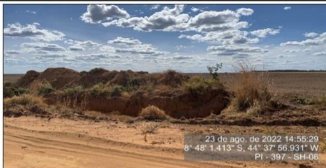
Poço de drenagem feito pela Concessionária.
