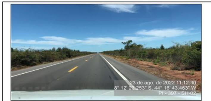
Pavimento asfáltico em boas condições para tráfego. Sinalização horizontal (pintura) em boas condições.
