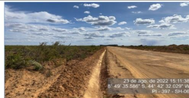
Valeta de drenagem.
