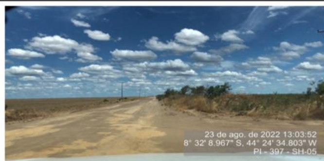
Início do segmento homogêneo 5 - segmento em leito natural.
