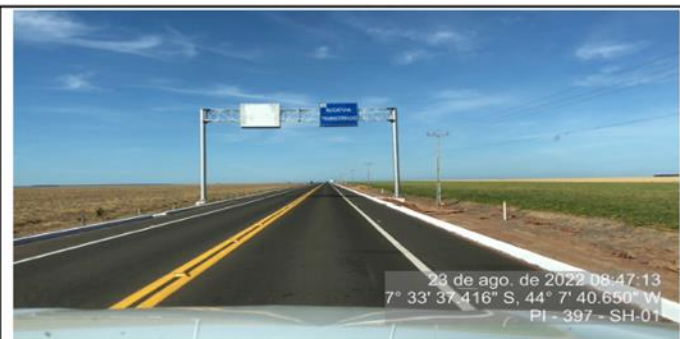
Rodovias PI-397/ PI-262 - início do segmento homogêneo 1 - segmento pavimentado.
