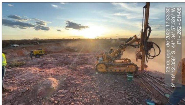
Figura 134 - Execução de furos para desmonte de rocha
