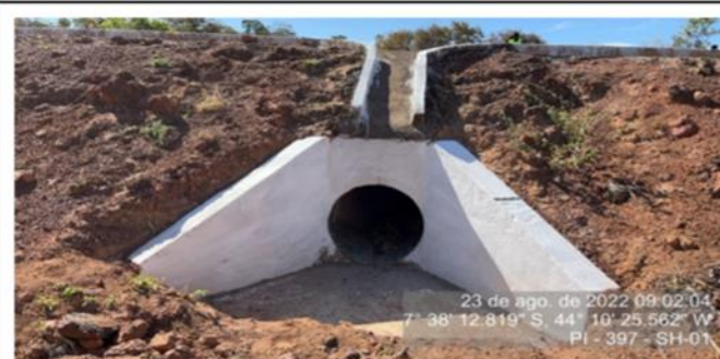
Bueiro simples de drenagem sem obstruções, localizado no KM 10,4.
