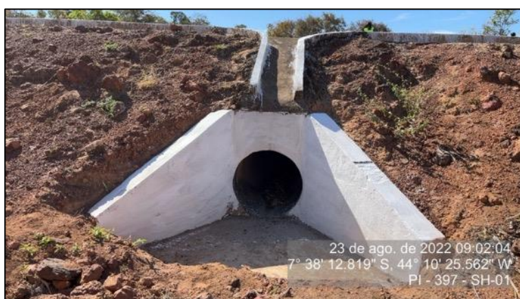
Figura 27 – Bueiro simples 02 localizado no KM 10,40 do segmento – SH1.
