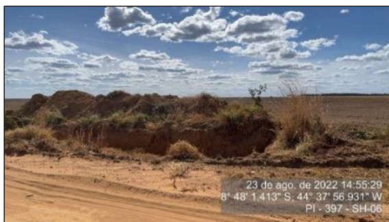
Figura 108 - Poço de drenagem
