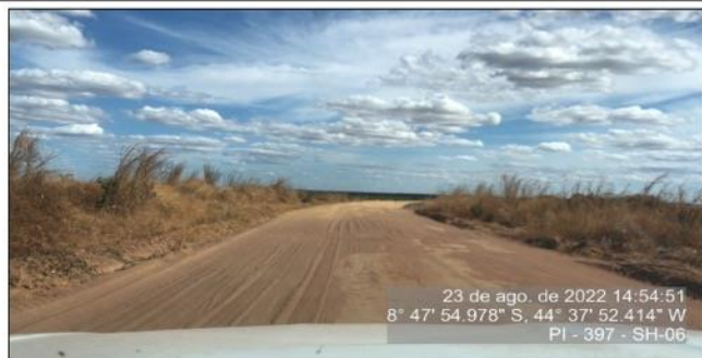
Início do segmento homogêneo 6 - segmento em leito natural apresentando material solto e vegetação de bordo alta
