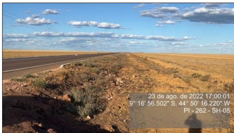
Figura 140 - Terrapleno com cobertura vegetal-SH-08
