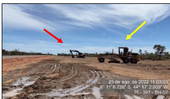
Figura 65 - Escavadeira hidráulica (vermelha) e motoniveladora (amarelo)
