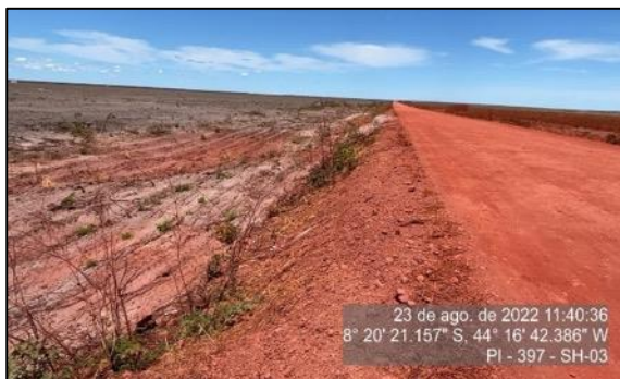
Figura 74 – Talude de aterro com bom aspecto – SH-03
