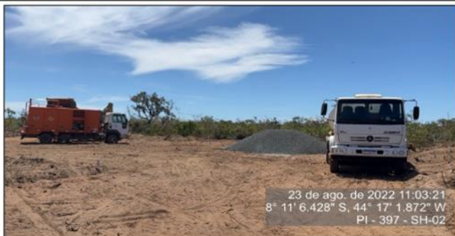
Caminhão comboio a esquerda e caminhão pipa a direita-Canteiro da P2
