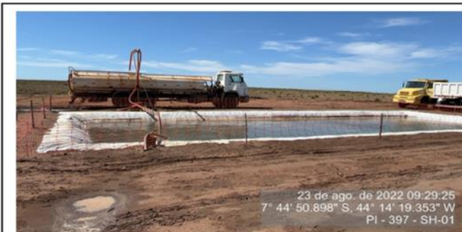
Reservatório de água para o abastecimento do caminhão pipa.
