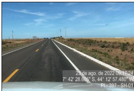
Figura 16 - Ponto com desgaste no pavimento – SH-01
