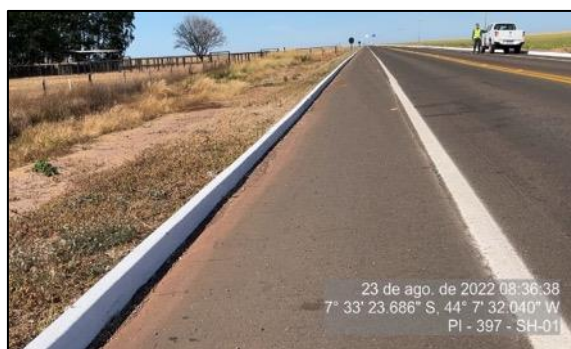
Figura 24 - Drenagem desobstruída e em boas condições – SH-01
