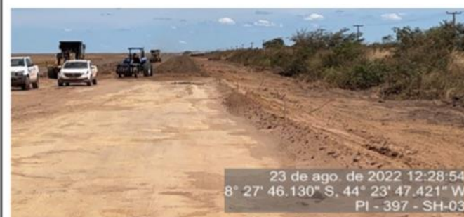
Serviço de terraplenagem sendo executado no segmento.
