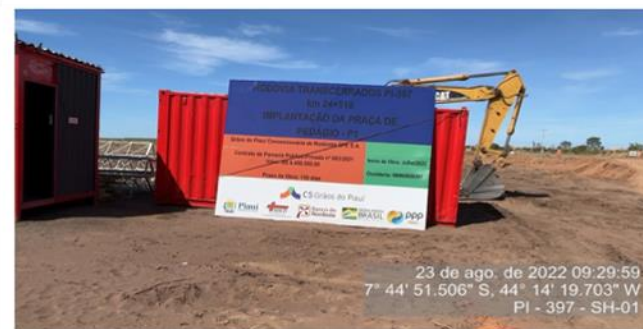
Placa da obra da implantação da Praça de Pedágio 01.
