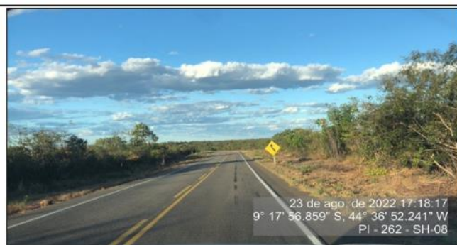
Sinalização vertical visível após serviço de roçada nos bordos da pista.
