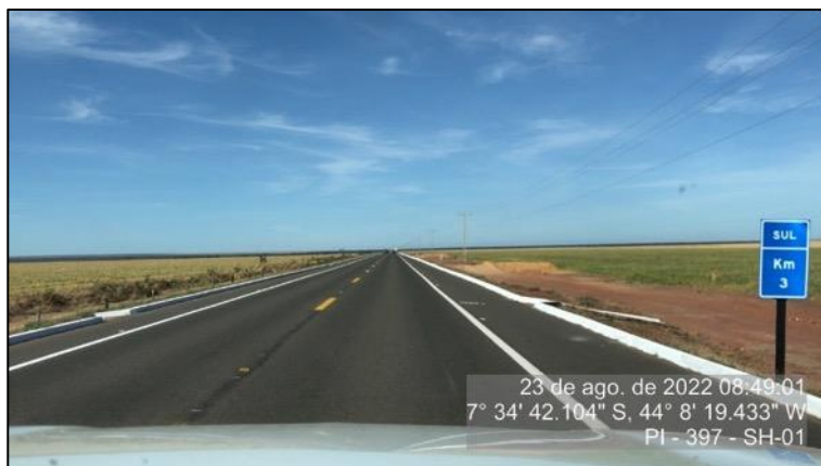
Figura 21 – Sinalização vertical implantada no mês de agosto/22 – SH1.
