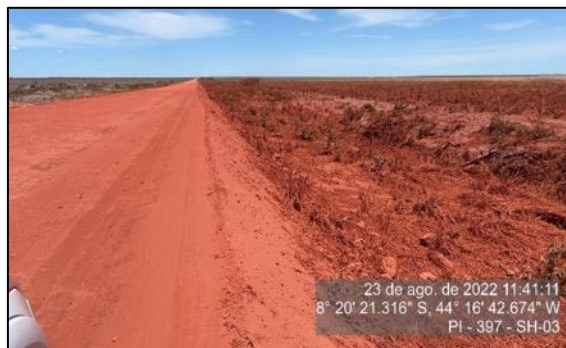
Figura 75 – Talude de aterro com revestimento vegetal – SH-03
