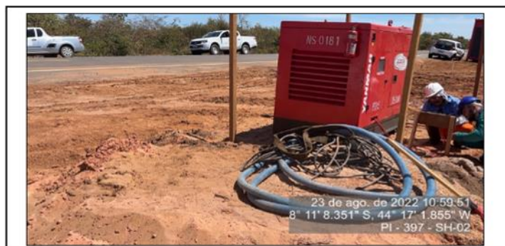
Poço de água e instalação de gerador na Praça de Pedágio P2
