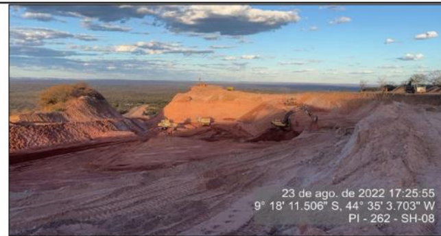
Obra de correção do traçado da Serra do Quilombo, km 33,65 da Rodovia PI-262, a serviço da SETRANS-PI.
