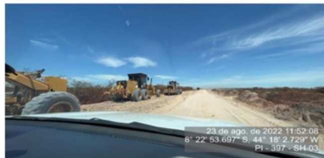
Motoniveladora espalhando o material na pista.
