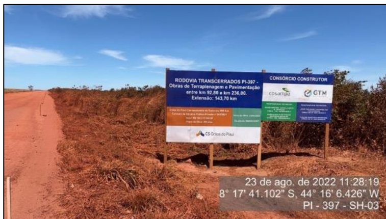
Figura 76 - Placa de Obra de Terraplenagem e Pavimentação – SH-03
