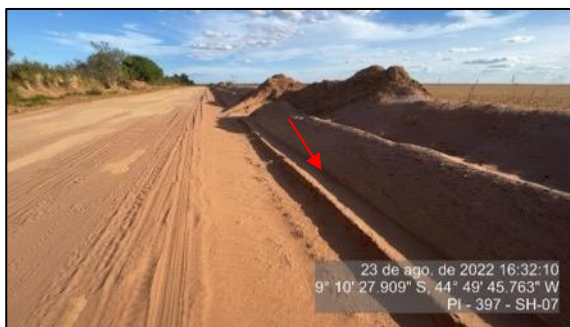
Figura 117 – Valeta de drenagem no SH-07
