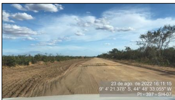
Figura 121 – Faixa de domínio após o serviço de limpeza da vegetação – SH 07
