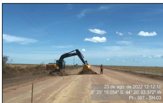
Figura 82 – Escavação do material do bordo da pista – SH-03
