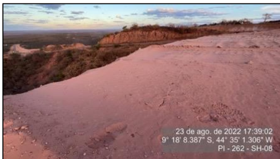
Figura 149 – Formação de trincas no bordo do Bota-fora - 1
