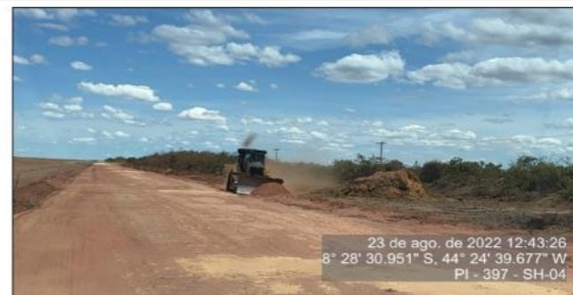
Trator realizando serviços de remoção vegetal mecanizada na lateral da pista do Segmento 04
