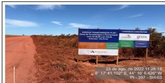
Placa de obras de Terraplenagem e pavimentação no segmento.
