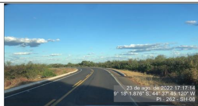
Curva com sinalização horizontal e pavimento em bom estado
