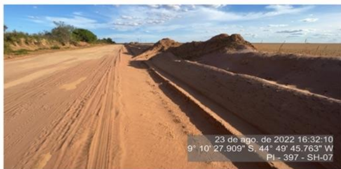
Valeta de drenagem para escoamento de águas pluviais para os poços de drenagem.
