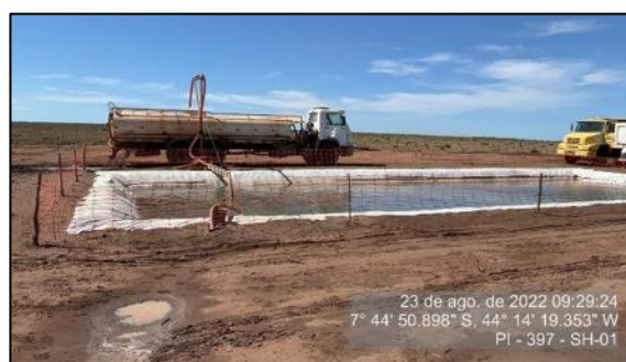
Figura 47 – Reservatório abastecendo caminhão pipa – agosto/22
