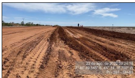
Figura 41 - Execução de terraplenagem na Praça P1 – agosto/22
