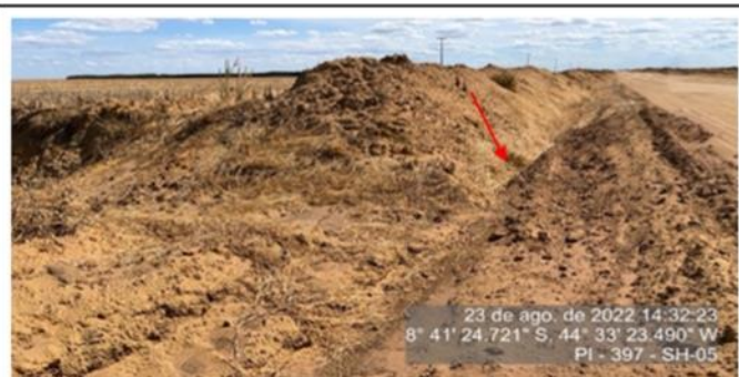
Valeta de drenagem para melhorar o escoamento da água para os poços de drenagem.
