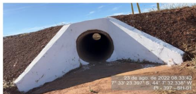
Bueiro simples de drenagem sem obstruções, localizado no KM 0.
