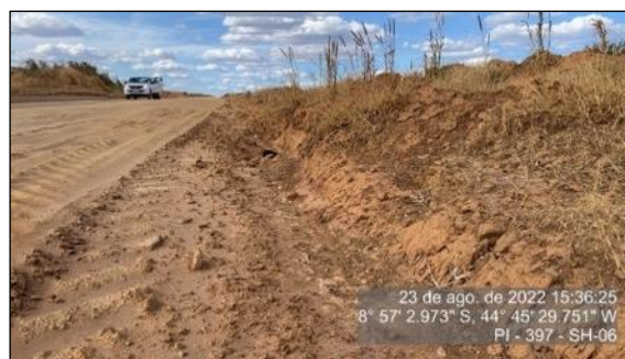
Figura 107 - Valeta de drenagem lado esquerdo (sentido crescente)
