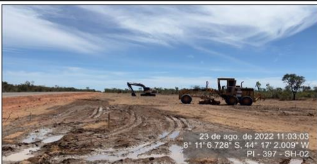
Escavadeira hidráulica ao fundo e motoniveladora a direita-Canteiro da P2
