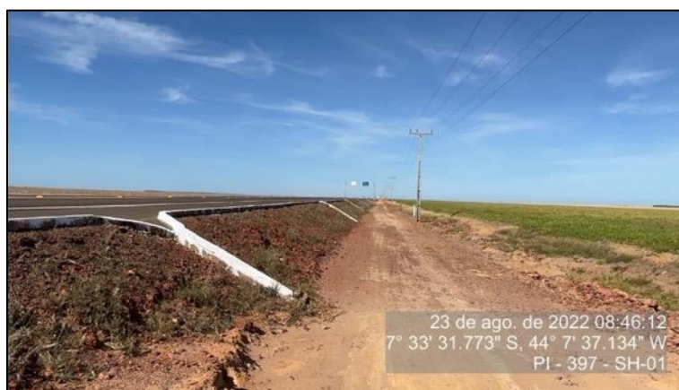
Figura 31 – Terrapleno em boas condições – SH-01
