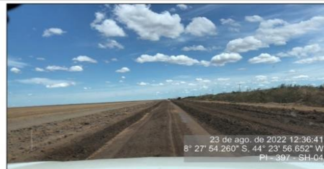
Trecho do segmento 04 em serviço de terraplenagem
