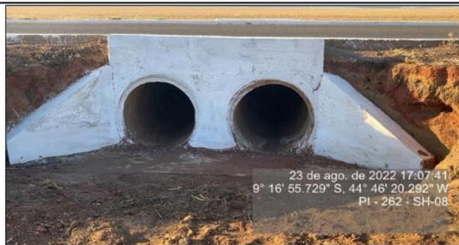
Bueiro situado no Segmento 08.
