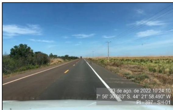
Figura 30 - Trecho sem dispositivos de drenagem – SH-01
