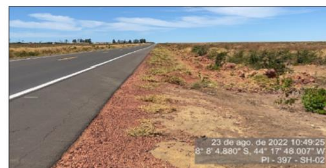
Talude lateral da pista - lado direito sentido crescente da pista.
