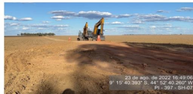
Início da mobilização de equipamentos para obra de melhoria e ampliação do segmento.
