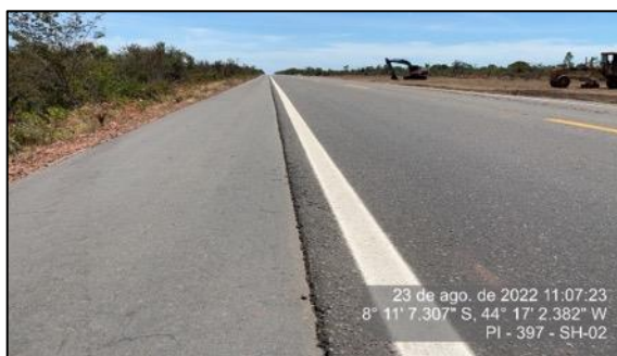
Figura 54 - Sinalização horizontal no SH-02 (agosto/22) - 2
