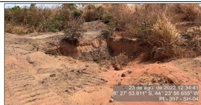
Poço de drenagem do Segmento 04
