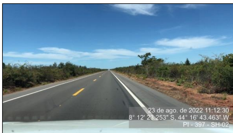
Figura 51 - Faixa de rolamento e acostamento em bom estado - SH-02
