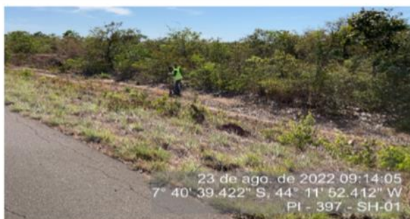
Equipe da Concessionária instalando os delimitadores de faixa de domínio.
