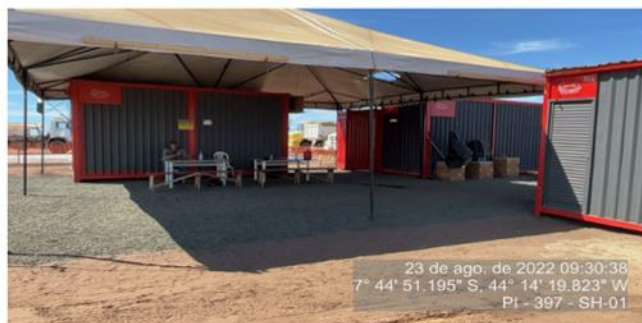
Canteiro de obras da Praça de Pedágio 01.
