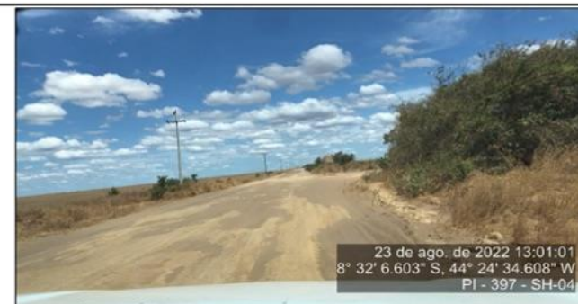
Final do segmento homogêneo 4 – segmento com leito natural. Vegetação alta no bordo da pista.
