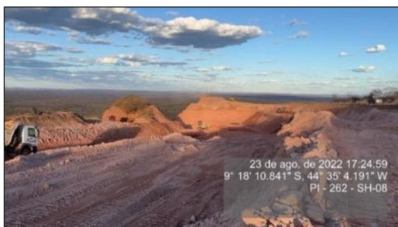
Figura 132 - Obra de correção do traçado no Km 33 – Início da Subida da Serra - SH-08
