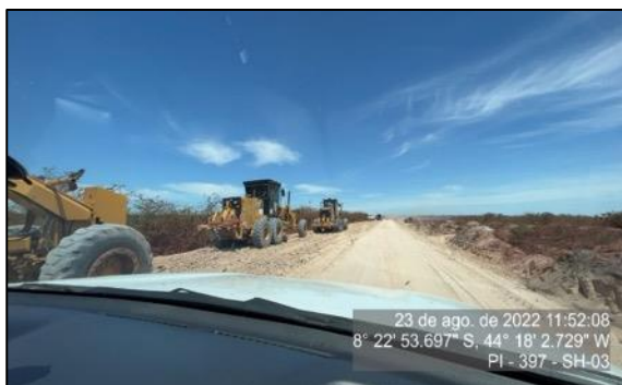
Figura 79 – Motoniveladoras espalhando o material na pista – SH-03
