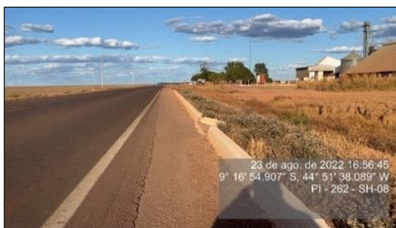
Figura 138 - Meio-fio à direita-SH-08
