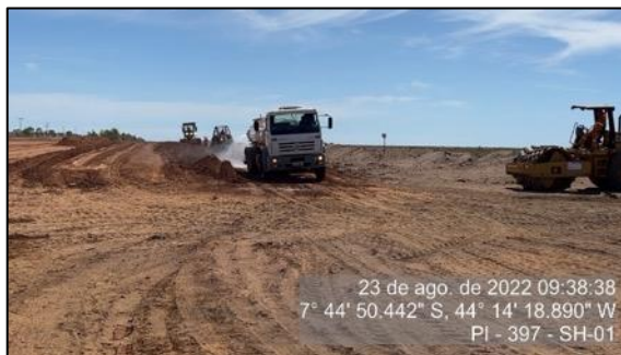
Figura 39 - Execução de terraplenagem na Praça P1 – agosto/22
