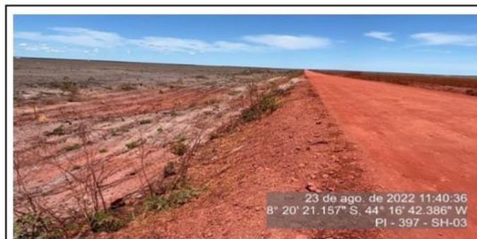
Terraplino em boas condições.
