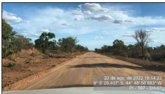
Figura 119 – Faixa de domínio após o serviço de limpeza da vegetação – SH 07
