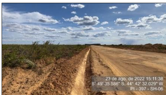
Figura 106 - Valeta de drenagem lado direito (sentido crescente)
