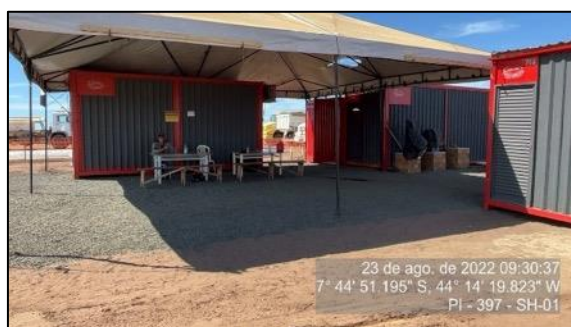
Figura 42 – Canteiro de obra da P01 – agosto/22
