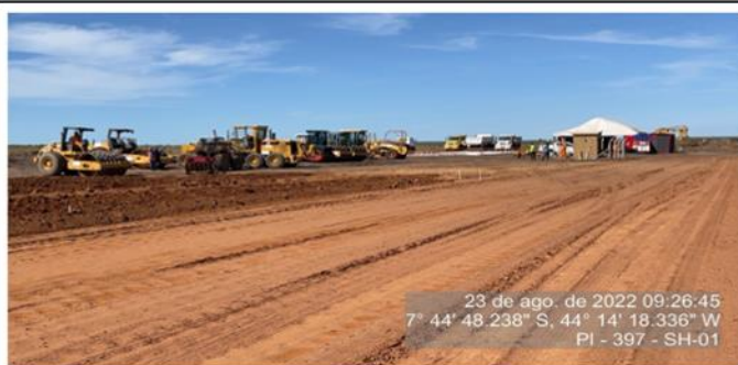
Obras das instalações da praça de pedágio 01.
