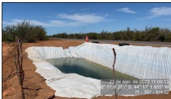
Figura 67 - Reservatório de água da P2 - 2
