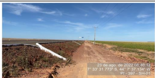
Talude de aterro em boas condições.
