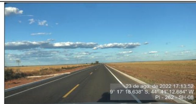
Sinalização horizontal em boas condições.
