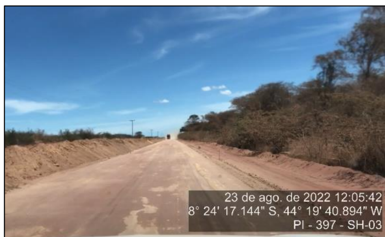
Figura 77 - Vegetação lateral elevada - SH 03
