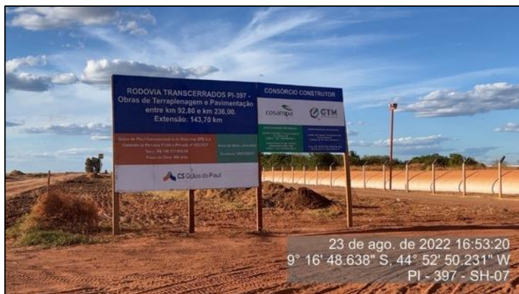
Figura 123 – Placa de obra entre o KM 92,8 e KM 236 - SH 07
