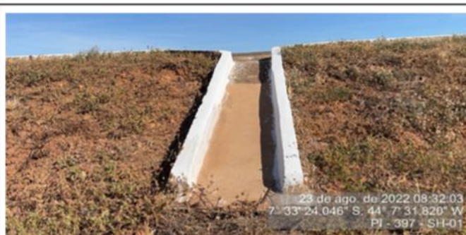
Decida d'água sem obstruções.
