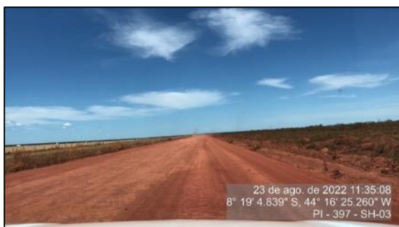
Figura 69 - Revestimento existente nos dois primeiros terços do SH-03
