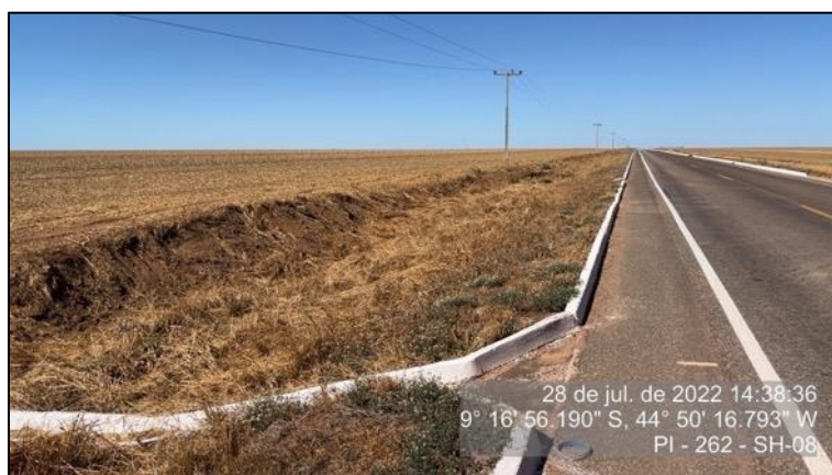
Figura 101 - talude com recobrimento vegetal no SH-08
