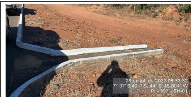
Decida d'águas sem obstruções.
