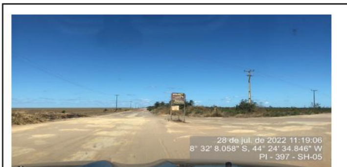
Início do segmento homogêneo 5 - segmento em leito natural. Vegetação alta no bordo da pista.
