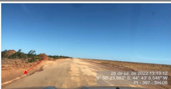
Valeta de drenagem para facilitar o escoamento da água pluvial para os poços de drenagem.
