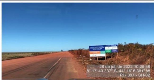
Final do Segmento 2. Placa de obras de Melhoria e Ampliação
