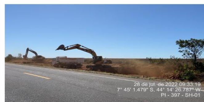
Obras das instalações da praça de pedágio 01.
