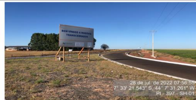
Sinalização vertical, placa informativa, com fixação de madeira implantada pela Concessionária.
