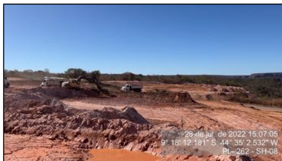
Figura 97 – Obra de correção do traçado no Km 33 – Final da Subida da Serra - SH-08
