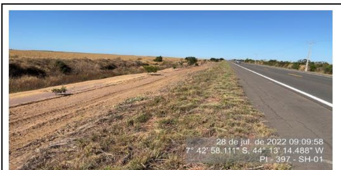
Bordos da pista após serviço de roçada de acordo com o previsto no PER, vegetação com altura inferior a 0,30 m.
