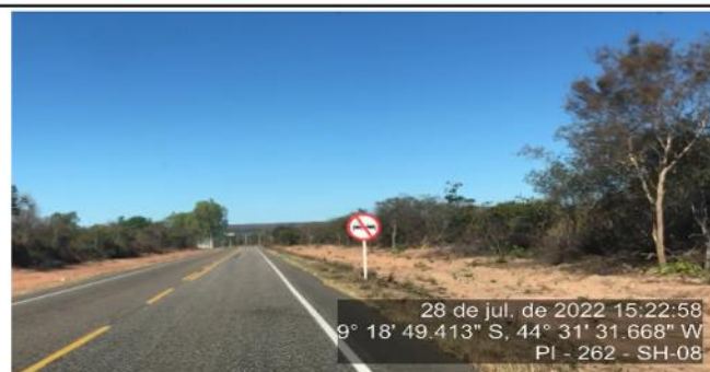
Sinalização vertical visível após serviço de roçada nos bordos da pista.
