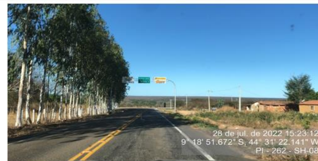
Final do segmento homogêneo 8 - sinalização horizontal conservadas.
