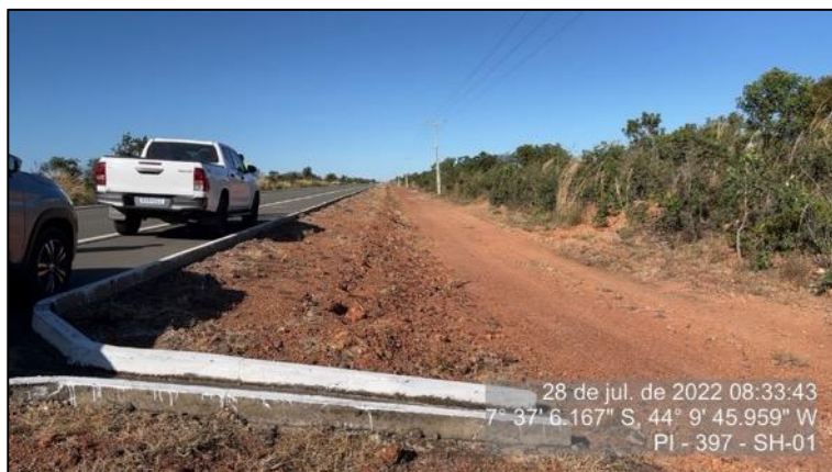
Figura 36 – Terrapleno em boas condições – SH-01
