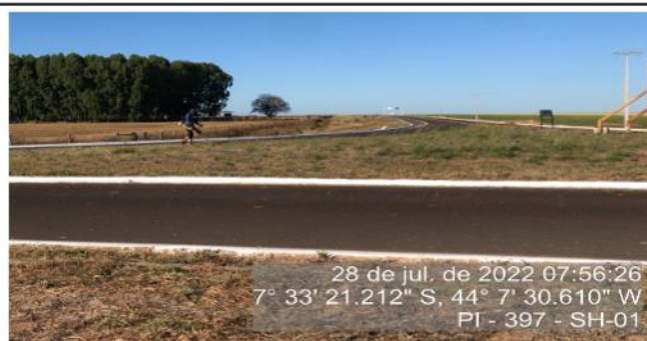
Serviço de limpeza e roçada no trevo da interseção da Transcerrados(PI-397) com a PI-247 / BR 324.
