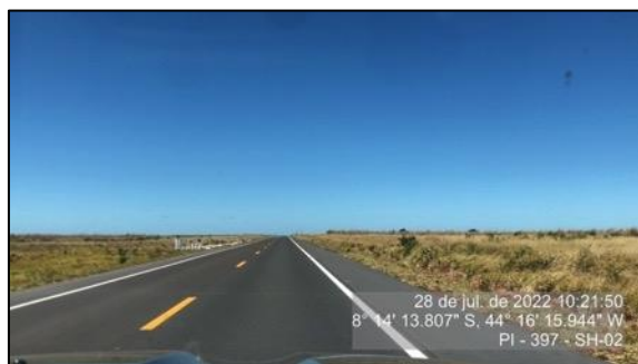
Figura 48 - Talude lateral com cobertura vegetal – SH-02
