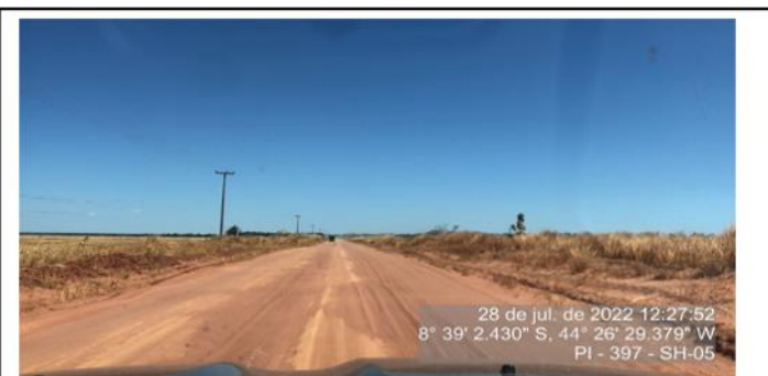
Trecho do segmento com material solto.
