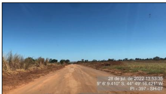
Figura 80 – Estado geral após intervenção da Concessionária – SH-07
