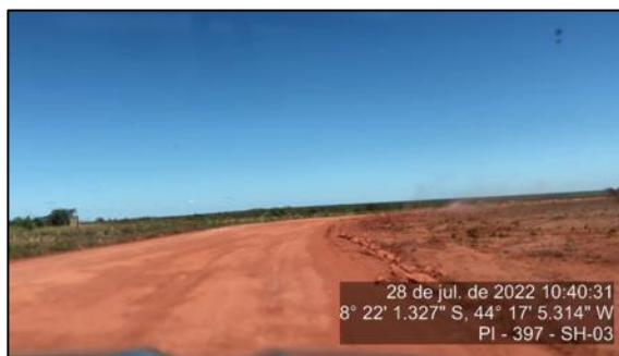
Figura 58 – Talude de aterro com revestimento vegetal – SH-03
