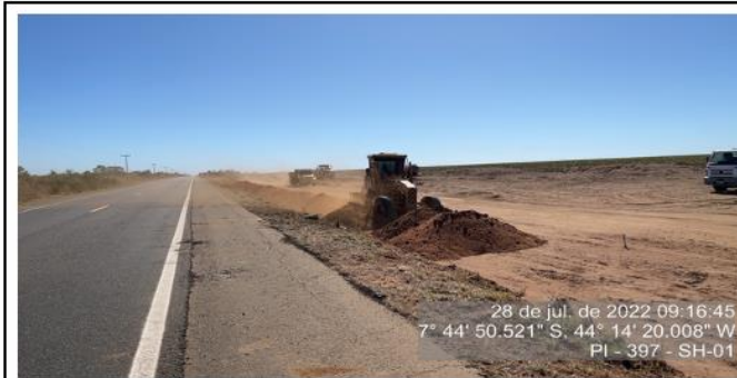
Obras das instalações da praça de pedágio 01.
