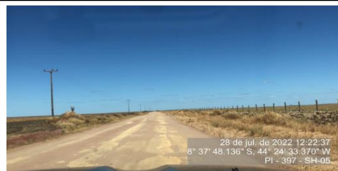
Equipe de serviço da Concessionária realizou o abaulamento da pista para evitar o acúmulo de água no seu eixo.
