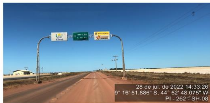
Início do segmento homogêneo 8 - segmento pavimentado.
