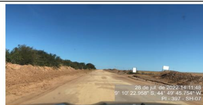
Equipe de serviço da Concessionária realizou o serviço de limpeza nos bordos da pista.
