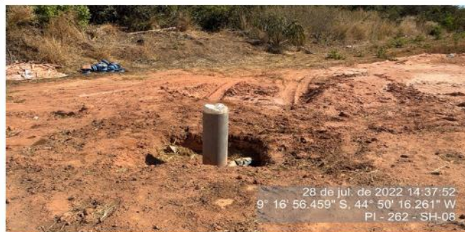
Poço de água da Praça de Pedágio P4 já implantado pela Concessionária.
