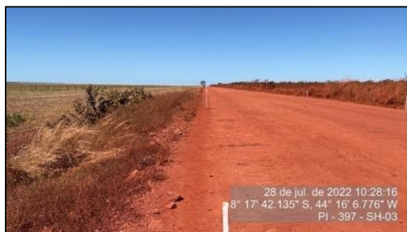
Figura 57 – Talude de aterro com bom aspecto – SH-03
