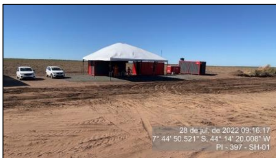
Figura 42 – Obras das instalações da praça de pedágio 01 – julho/22
