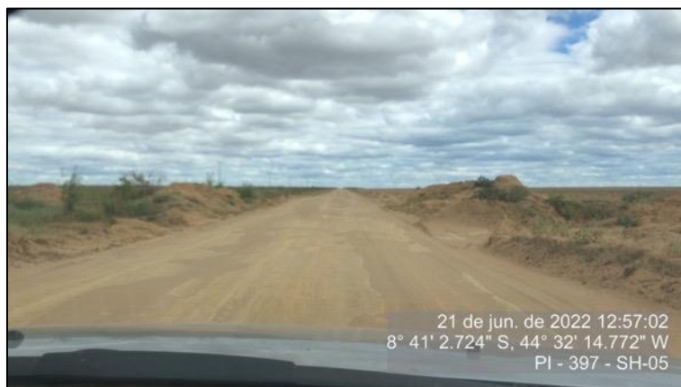
Figura 67 - Leito estradal no Segmento 05 – junho/22
