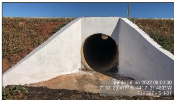
Figura 33 - Drenagem desobstruída após serviço de roçada (julho/22) – SH-01
