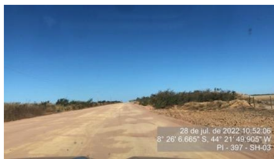
Figura 54 – Revestimento existente no último terço do SH-03
