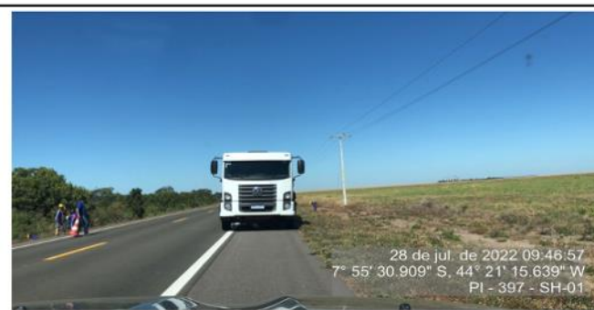
Equipe da Concessionária realizando o serviço de limpeza da faixa de domínio.
