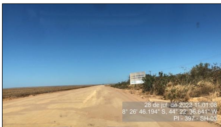
Figura 59 - Sinalização vertical informativa no SH-03
