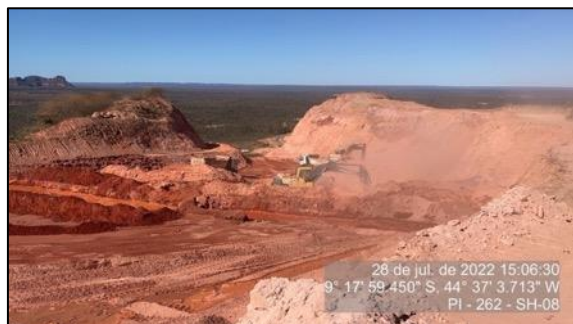
Figura 96 – Obra de correção do traçado no Km 33 – Início da Subida da Serra - SH-08
