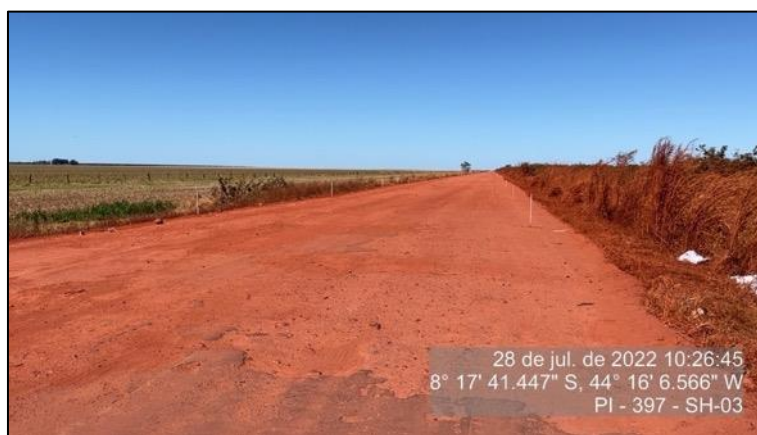
Figura 56 - Marcação topográfica das obras no SH-03
