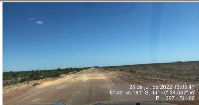
Início do segmento homogêneo 6 - segmento em leito natural.
