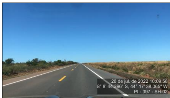
Figura 49 - Cobertura vegetal nos taludes laterais da pista – SH-02
