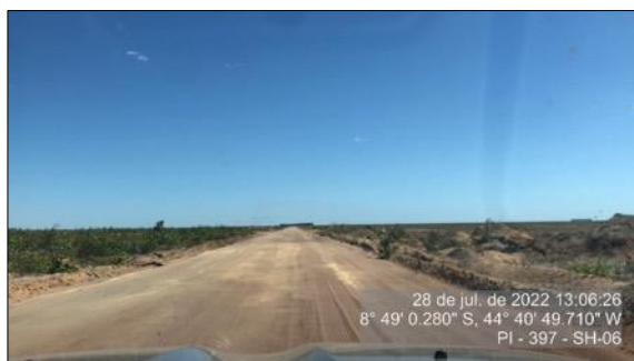
Figura 71 - Estado geral após intervenção da Concessionária – SH-06
