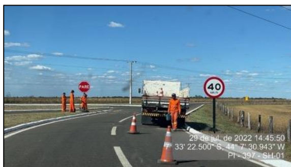
Figura 30 - Implantação da sinalização vertical - SH 01
