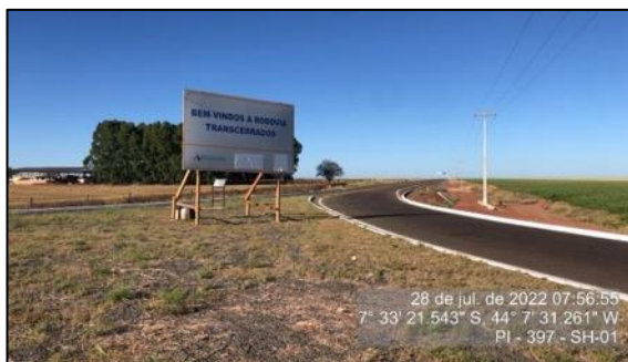
Figura 29 - Sinalização vertical reparada - SH 01 - (julho/22)
