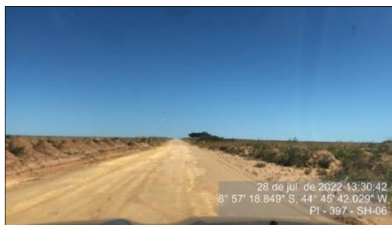
Figura 72 - Estado geral após intervenção da Concessionária – SH-06
