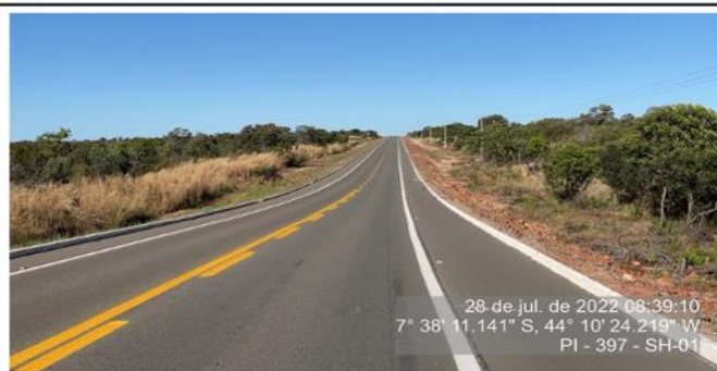
Sinalização horizontal (pintura) em boas condições.
