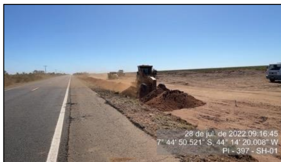
Figura 43 - Obras das instalações da praça de pedágio 01 – julho/22
