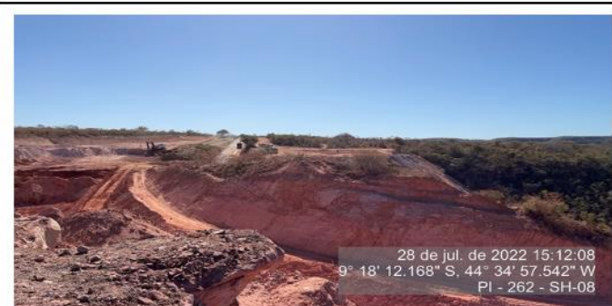
Obra de correção do traçado da Serra do Quilombo, km 33,65 da Rodovia PI-262, a serviço da SETRANS-PI.
