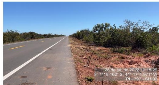
Talude lateral da pista - lado direito sentido crescente da pista.
