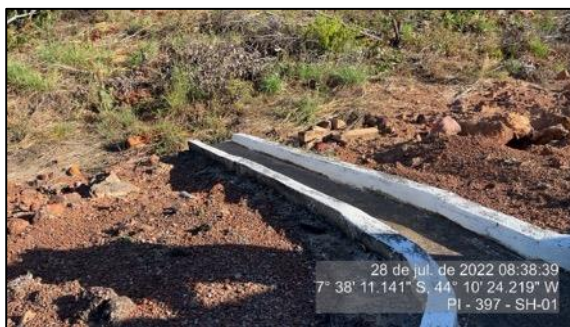
Figura 32 - Drenagem desobstruída após serviço de roçada (julho/22) – SH-01
