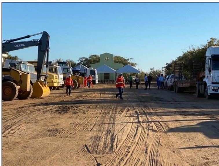
Figura 55 - Início da mobilização de equipamentos e pessoal para as obras de melhoria e ampliação
