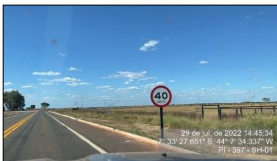
Figura 31 - Sinalização vertical implantada - SH 01
