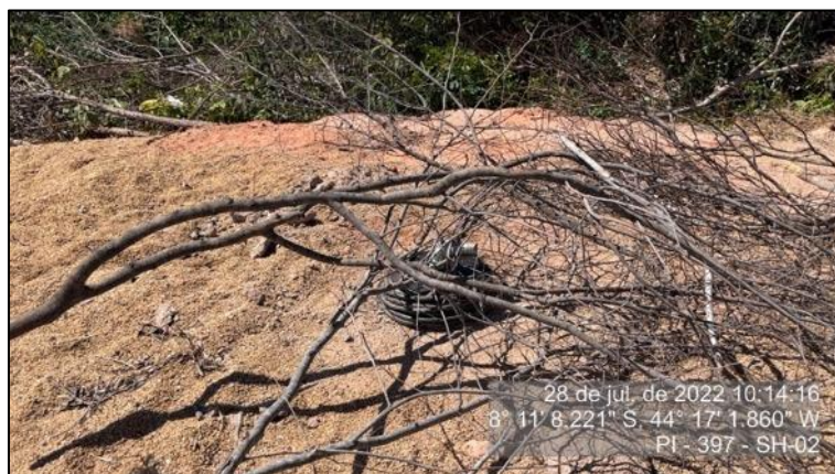
Figura 52 - Poço de abastecimento da Praça de Pedágio P2- SH-02
