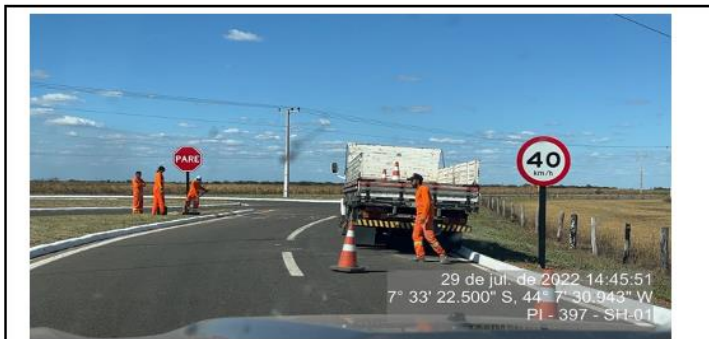
Implantação da sinalização vertical no trevo da interseção da Transcerrados (PI-397) com a PI-247 / BR 324.
