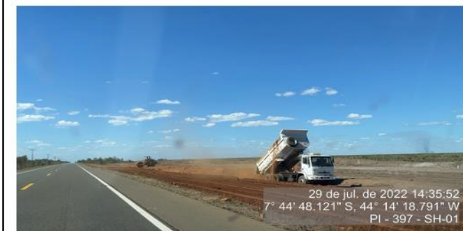
Obras das instalações da praça de pedágio 01.
