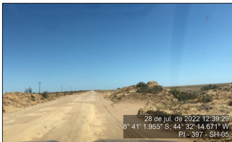
Figura 66 - Leito estradal no Segmento 05 – julho/22
