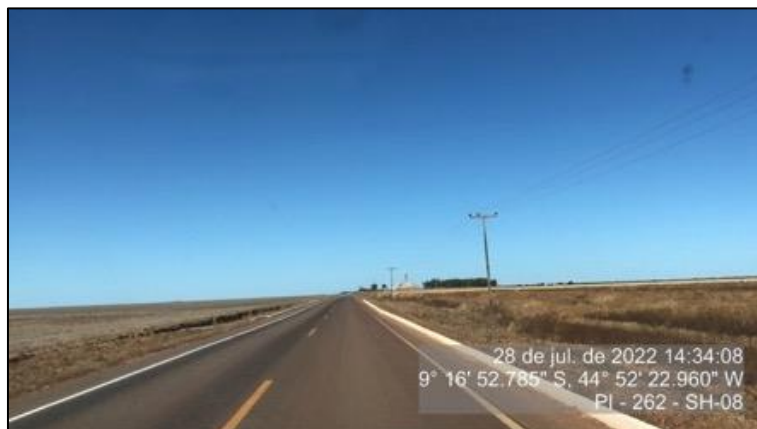
Figura 100 – Dispositivos de drenagem em bom estado – SH-08
