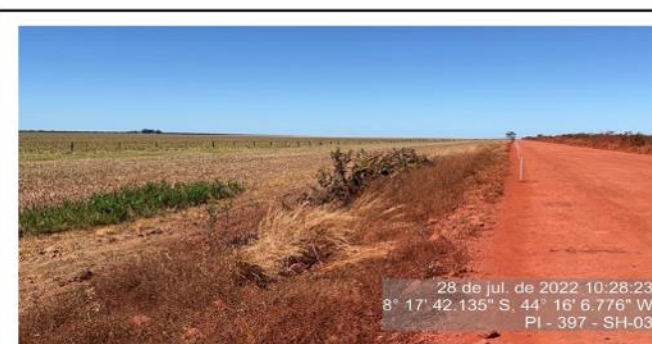
Terrapleno em boas condições.
