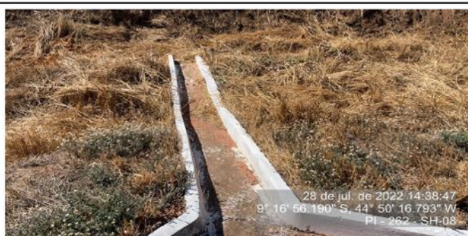
Descida d'água sem obstruções e em perfeito funcionamento.
