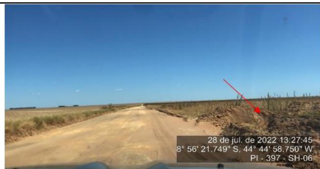
Poço de drenagem feito pela equipe de serviço da Concessionária.
