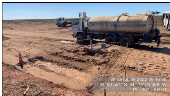
Figura 40 – Obras das instalações da praça de pedágio 01 – julho/22
