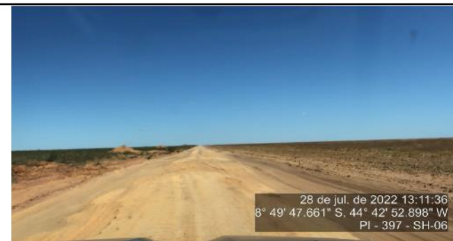
Segmento com eixo da pista mais alto que a cota do terreno, não ocasionando acúmulo de água na pista.
