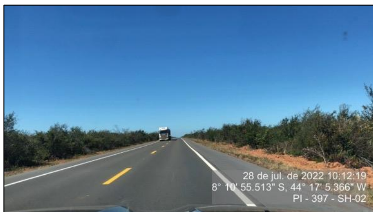
Figura 45 - Faixa de rolamento e acostamento em bom estado - SH-02
