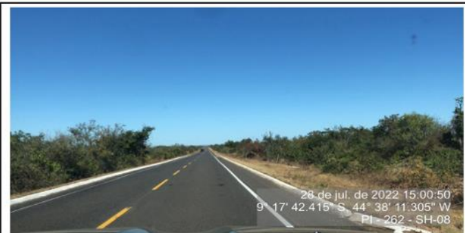
Pavimento asfáltico em boas condições para tráfego.
