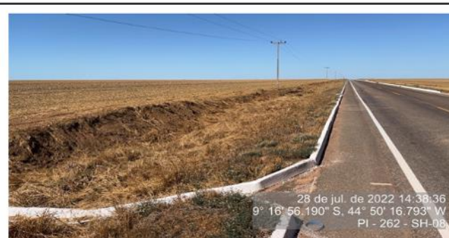
Bordos da pista após realização do serviço de roçada de acordo com o previsto no PER.
