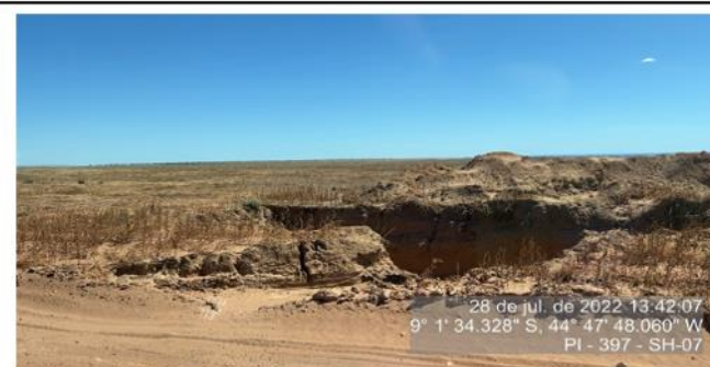
Poço de drenagem.
