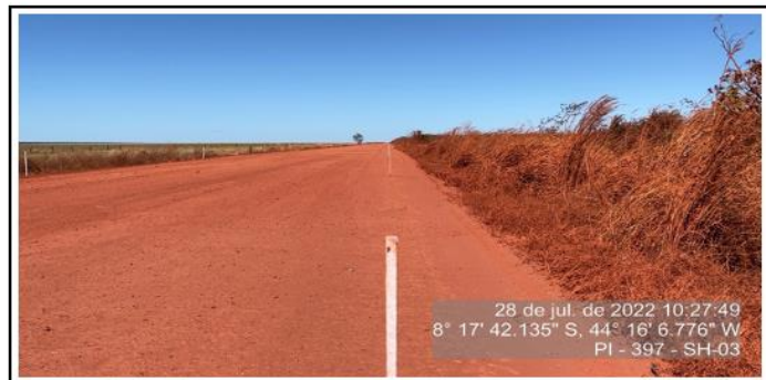
Marcação topográfica das obras de melhoria e ampliação no segmento.
