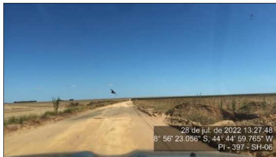
Figura 77 - Poço de drenagem à direita da pista- SH-06
