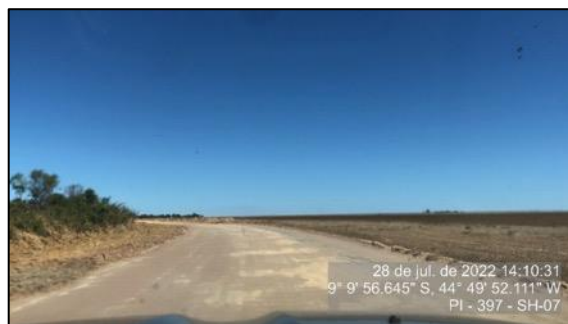
Figura 81 – Estado geral após intervenção da Concessionária – SH-07
