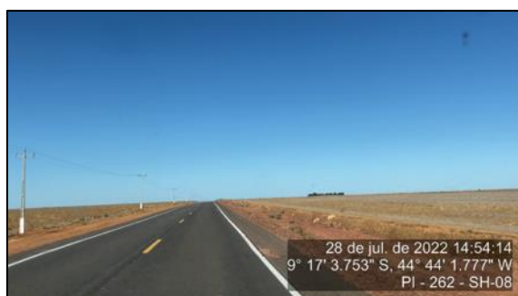
Figura 92 - Buraco no acostamento - SH-08
