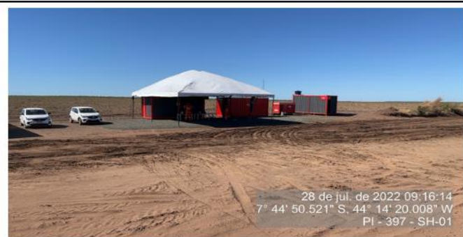
Canteiro de obras da praça de pedágio 01 implantada pela Concessionária.
