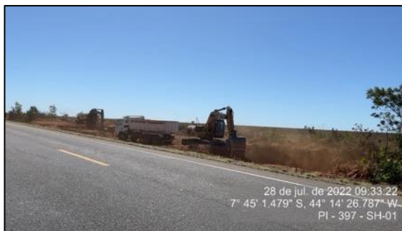
Figura 41 – Obras das instalações da praça de pedágio 01 – julho/22
