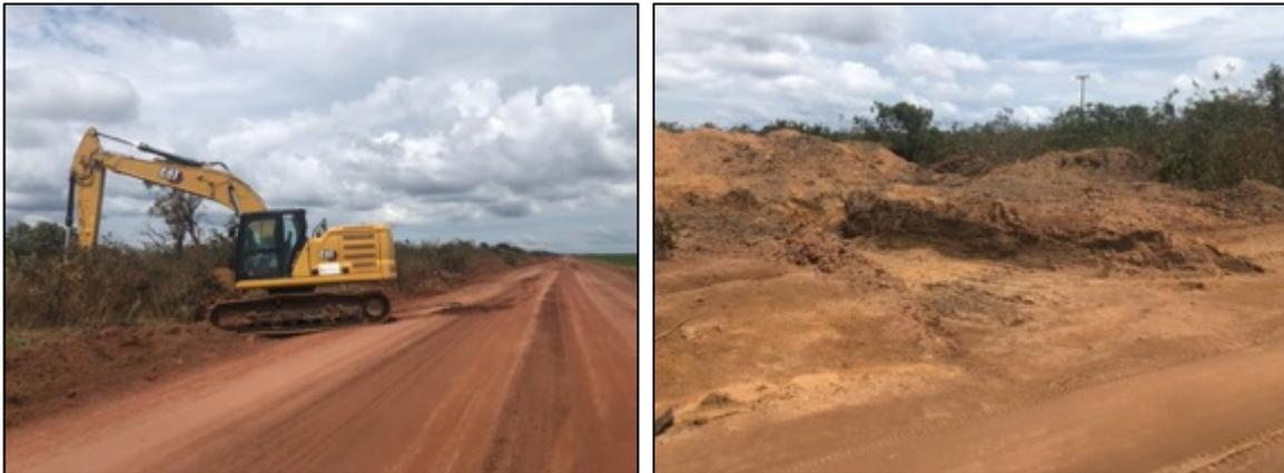
Ainda é possível verificar alguns pontos onde ocorrem grandes acúmulos de água nos buracos existentes, que por sua vez, saturam o solo e causam instabilidade no veículo que trafega. Esses pontos estavam, na ocasião da visita técnica, sob intervenção de uma das equipes da Concessionária, conforme imagens abaixo.
