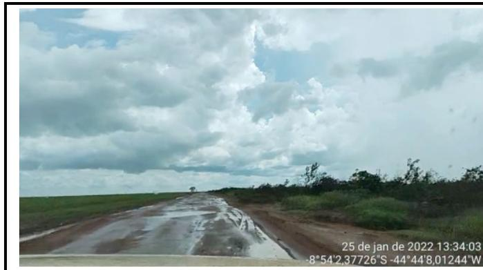
Solo saturado causando instabilidade no tráfego de veículos.
