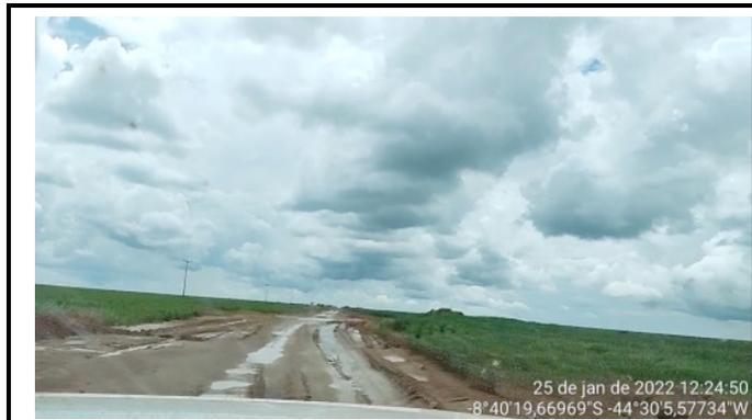
Trecho com solo saturado causando instabilidade no trafego de veículos.
