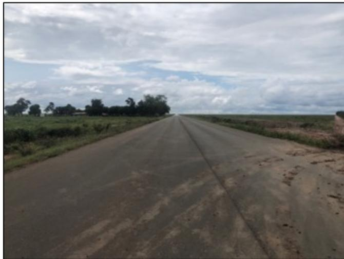
Foi possível verificar a ausência de buracos e “panelas”, inclusive nos acostamentos, bem como a ausência de áreas remendadas. Não há também a apresentação de zonas importantes com trincas, significando que o pavimento não foi prejudicado após as chuvas intensas do mês de dezembro/2021 e início de janeiro/2022.
