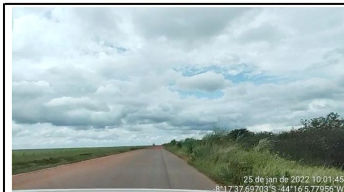
Final do segmento homogêneo 2 - Aumento de vegetação nos leitos da pista. Ainda com a ausência de sinalização horizontal.
