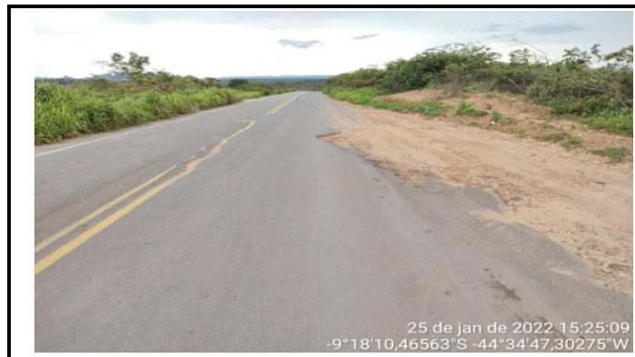
Deformação no pavimento em um dos lados do leito da pista.
