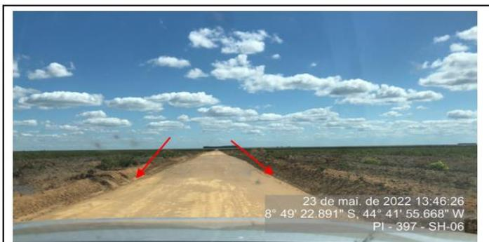
Valeta de drenagem feita pela motomiveladora, para melhorar o escoamento da água para os poços de drenagem.
