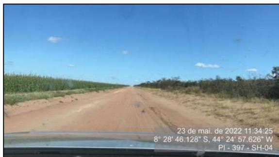
Figura 49 – Eixo da rodovia com elevação inferior ao bordo direito – SH-04
