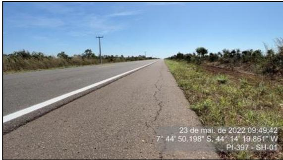
**Figura 17 – Trinca Transversal curta na pista de rolamento – SH-01**
