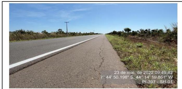
Trincas no pavimento asfáltico do acostamento.
