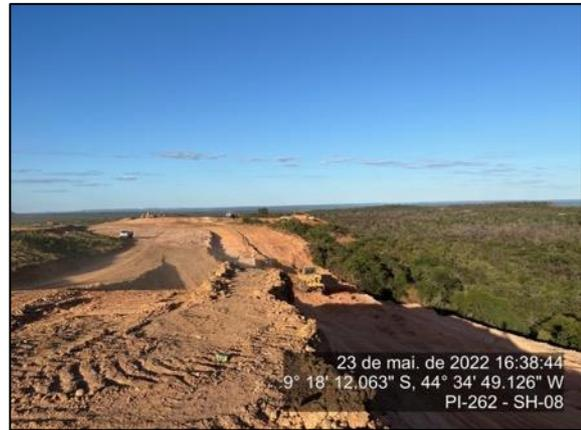
**Figura 77 – Obra de correção do traçado no Km 33 – Final da Subida da Serra - SH-08**
