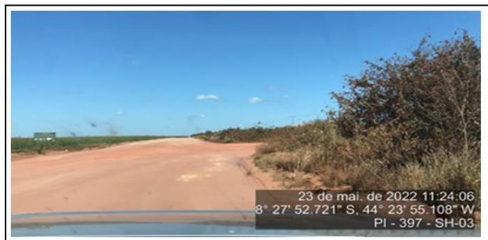
Final do segmento homogêneo 3 – segmento não pavimentado. Vegetação alta no bordo da pista.
