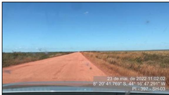
Figura 44 – Pista de rolamento com revestimento e presença de buracos – SH-03
