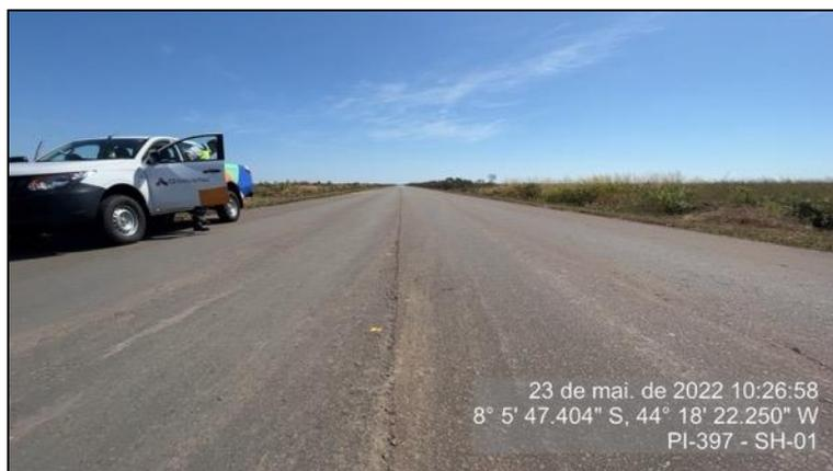
Figura 16 - Detalhe do desnível entre faixas contíguas – SH01
