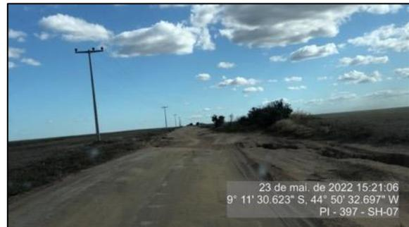
Figura 71 – Estreitamento da pista e baixa capacidade do solo – SH-07
