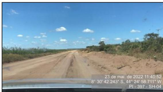
Figura 50 - Eixo da rodovia com elevação inferior aos bordos – SH-04
