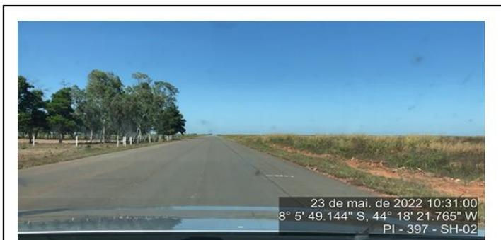
Início do segmento homogêneo 2 - segmento pavimentado. Ausência de sinalização horizontal.
