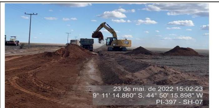
Escavadeira carregando o caminhão basculante com o material proveniente da escavação dos poços de drenagem, para o transporte.
