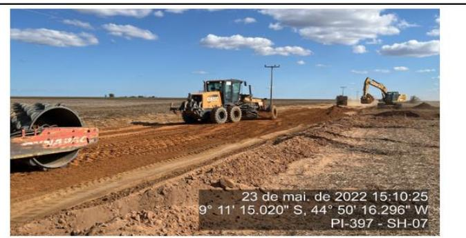
Motoniveladora fazendo o espalhamento do material no serviço de regularização da pista.
