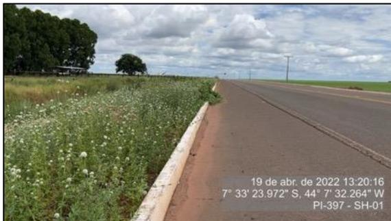
Figura 25 – Obstrução de drenagem superficial por vegetação - SH 01
