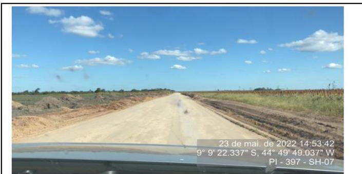
Equipe de serviço da Concessionária realizou o abaulamento da pista para evitar o acúmulo de água no seu eixo.
