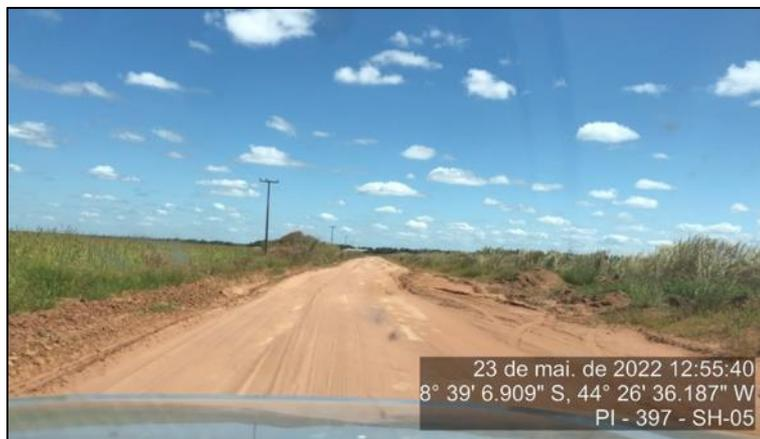
Figura 56 - Largura da pista comprometida devido à efeito erosivo - SH-05 - maio/22
