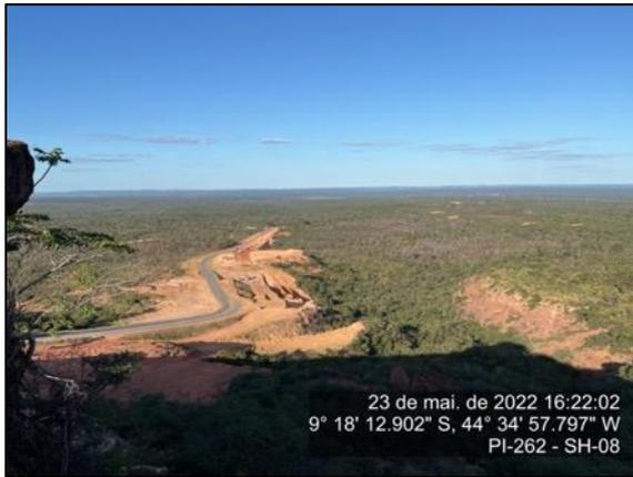
**Figura 76 – Obra de correção do traçado no Km 33 – Início da Subida da Serra - SH-08**
