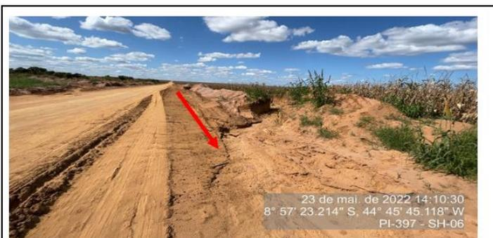
Linha de fluxo da água formada por escoamento para o poço de drenagem.
