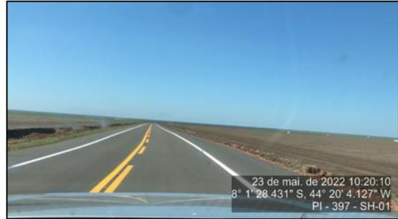
Figura 28 – Trecho sem dispositivos de drenagem – SH-01
