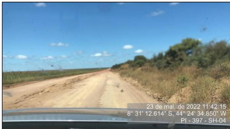
Figura 51 - Ponto com deterioração da superfície de rolamento - SH-04
