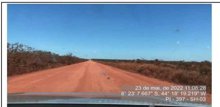
Segmento com eixo da pista mais alto que a cota do terreno, não ocasionando acúmulo de água na pista.
