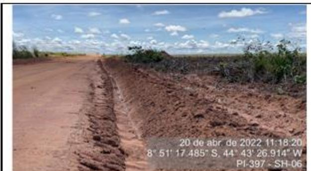
Valeta de drenagem feita pela motomiveladora, para melhorar o escoamento da água para os poços de drenagem.
