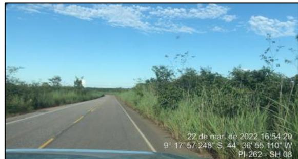
Figura 98 – Falta de sinalização vertical de ultrapassagem proibida - SH-08
