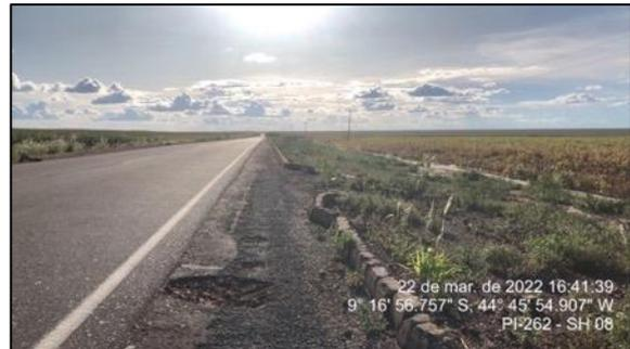
**Figura 102 - Detalhe da drenagem danificada - SH-08 - mar/22**
