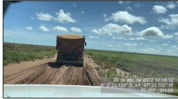
Figura 78 – Estreitamento da pista e baixa capacidade do solo – SH-06
