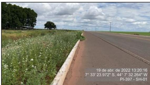
**Figura 33 - Obstrução de drenagem superficial por vegetação - SH 01**
