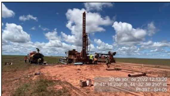
Figura 66 – Perfuração de poço artesiano na área da P3
