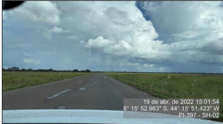
Figura 43 - Pontos de empocamento de água - SH-02
