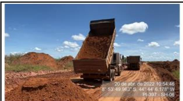
Caminhão basculante descarregando o material na pista para o serviço de regularização.
