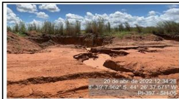
Erosão no solo causado pelo grande volume de água que transcorre para o poço de drenagem.
