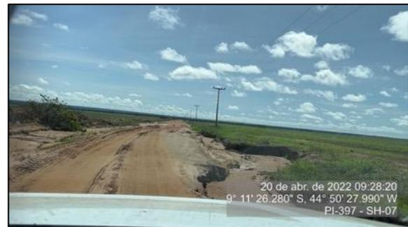
Figura 84 – Ponto com erosão no bordo esquerdo da pista – SH-07
