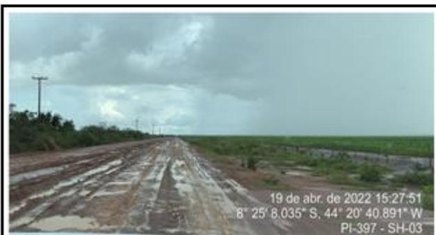
Solo saturado causando instabilidade nos veículos que trafegam no segmento.
