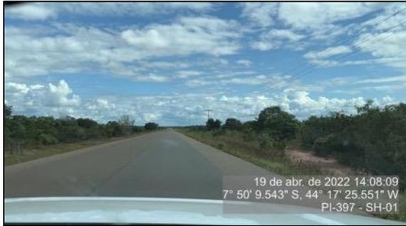
**Figura 31 - Trecho sem sinalização horizontal ou vertical - SH 01**
