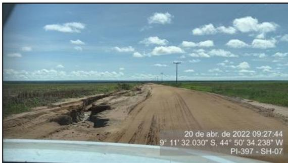
Figura 83 – Ponto com erosão no bordo direito da pista – SH-07
