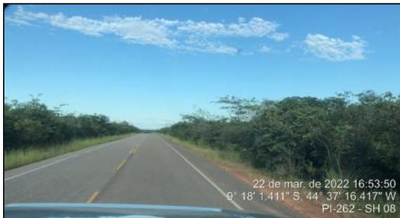
Figura 97 - Falta de sinalização vertical de ultrapassagem proibida - SH-08
