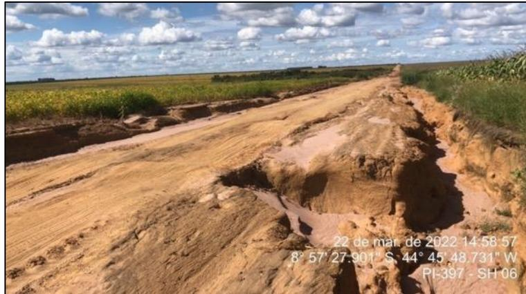
Figura 75 - Detalhe das erosões no SH-06
