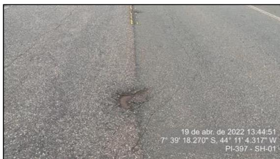
**Figura 27 – Formação de Buracos na junta das pistas de rolamento – SH-01**
