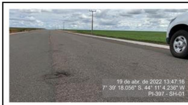
Início de formação de buraco/panelas no pavimento asfáltico da faixa de rolamento.
