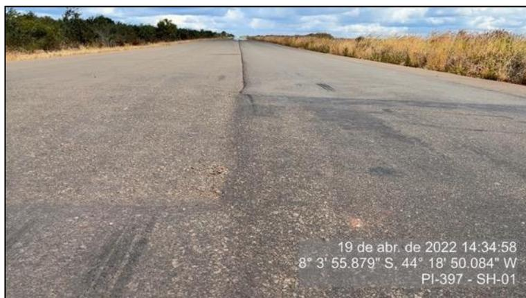
Figura 23 - Detalhe do desnível entre faixas contíguas – SH01
