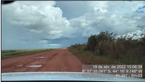
Figura 51 – Pista de rolamento com revestimento e presença de buracos – SH-03
