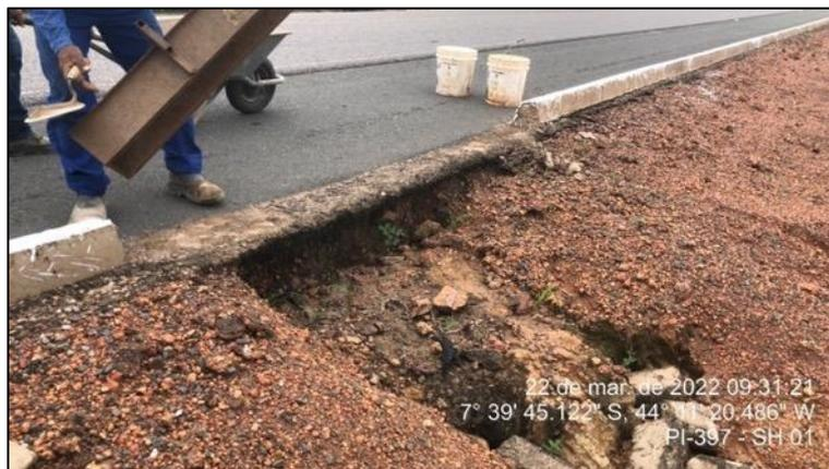
Figura 37 - Processo de reparo em dispositivo de drenagem evitando continuidade do processo erosivo por concentração de fluxo d'água
