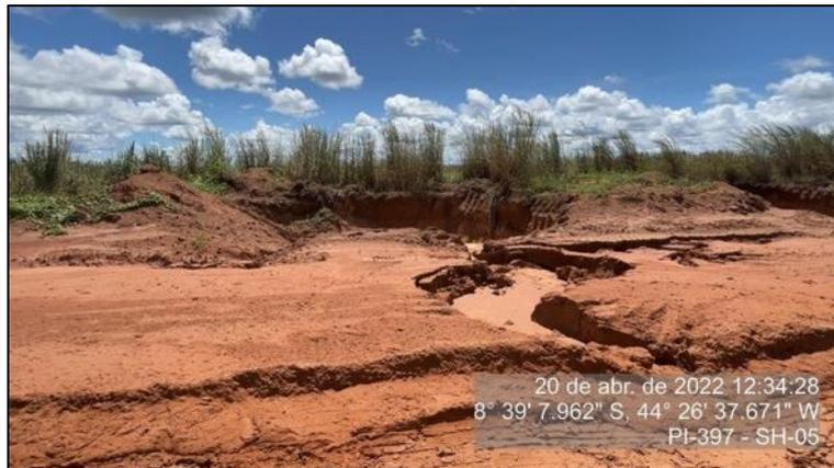
Figura 63 - Erosão causa pelo fluxo de água das chuvas - SH-05
