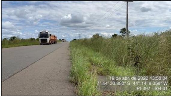
Figura 35 – Trecho sem dispositivos de drenagem – SH-01
