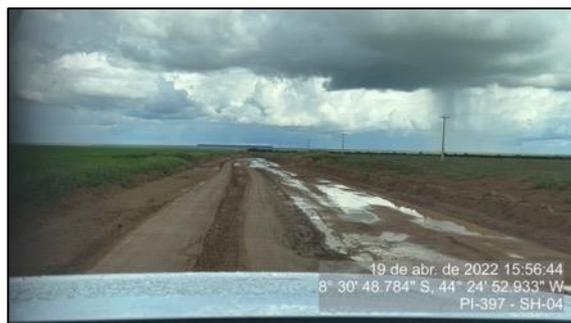
Figura 56 - Eixo da rodovia com elevação inferior aos bordos – SH-04
