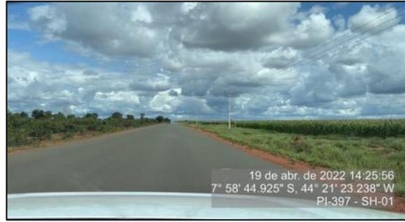
**Figura 32 - Trecho sem sinalização horizontal ou vertical - SH 01**
