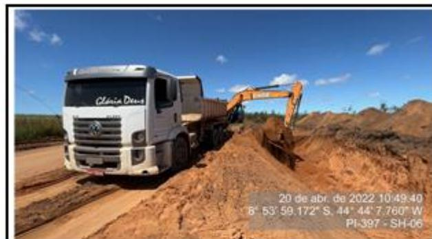
Escavadeira carregando o caminhão basculante com o material proveniente da escavação dos poços de drenagem, para o transporte.
