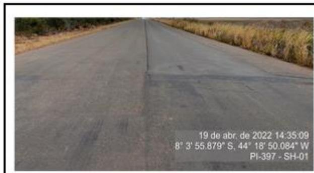
Diferença de nível do pavimento asfáltico entre as faixas de rolamento da pista, no KM 65,5.
