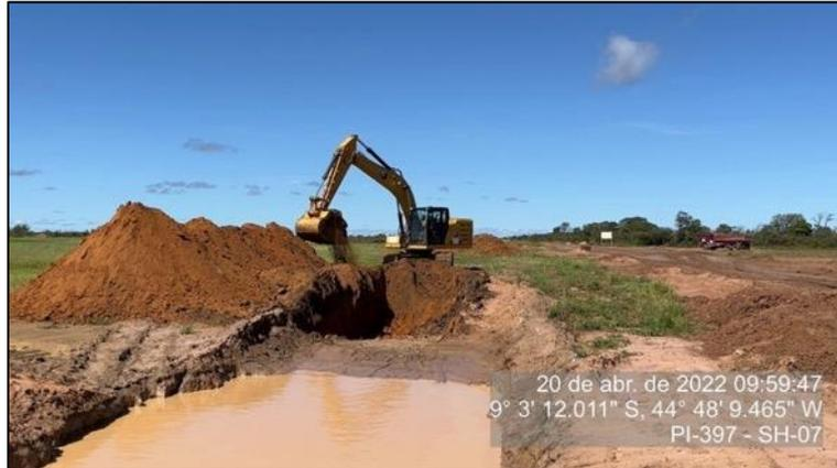
Figura 85 - Abertura de poços de drenagem - SH-07
