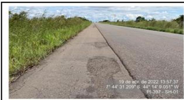
Início de formação de buraco/panelas no pavimento asfáltico do acostamento.
