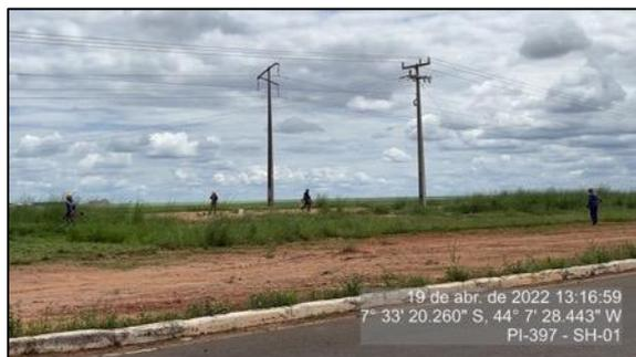
Figura 38 – Trecho sem dispositivos de drenagem – SH-01
