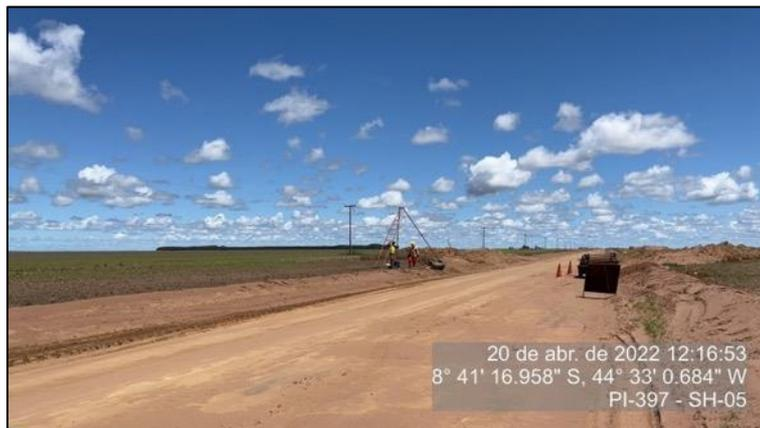
Figura 68 - Execução de sondagem do tipo SPT
