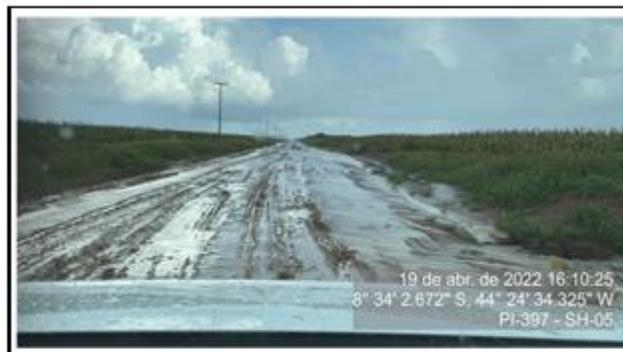
Solo saturado causando instabilidade nos veículos que trafegam no segmento.
