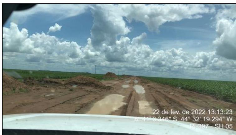
Figura 60 - Conformação original das pistas de rolamento - SH-05
