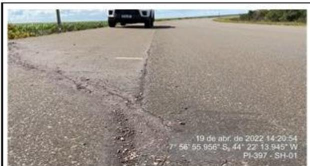
Fissuras no pavimento asfáltico do acostamento que se estende para o pavimento asfáltico da faixa de rolamento.
