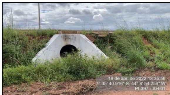
**Figura 34 - Obstrução de drenagem profunda por vegetação - SH 01**
