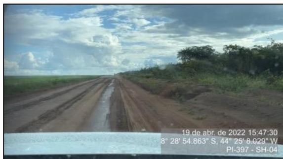
Figura 55 – Eixo da rodovia com elevação inferior ao bordo direito – SH-04
