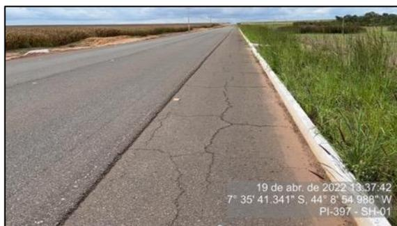
**Figura 25 – Trincas interligadas tipo bloco no acostamento – SH-01**
