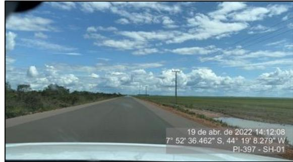
Figura 36 – Trecho sem dispositivos de drenagem – SH-01
