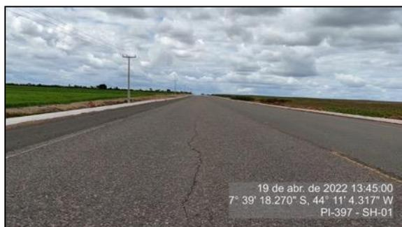
**Figura 26 – Trinca longitudinal longa na pista de rolamento – SH-01**
