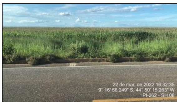
Figura 93 – Drenagem obstruída pela vegetação – SH-08
