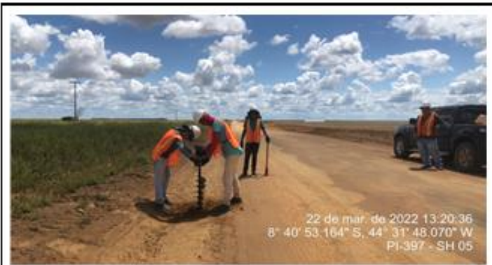
Equipe do laboratório da concessionária realizando a coleta de material para caracterização no leito da rodovia.
