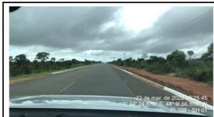
Meio fio reparado pela concessionária.
