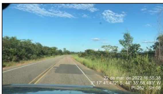
Figura 71 – Reparo no pavimento do segmento 08
