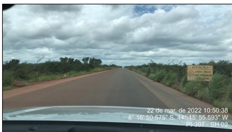
Figura 30 - Placa informando a falta de sinalização horizontal - Divisa entre SH 02 e SH 03
