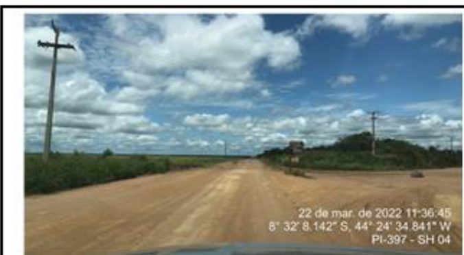
Final do segmento homogêneo 4 – segmento com leito natural. Vegetação alta no bordo da pista.
