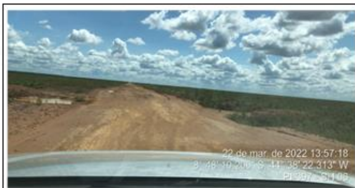
Poço de drenagem com sua capacidade máxima.
