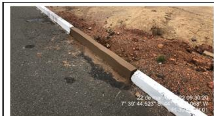
Meio fio reparado pela concessionária.
