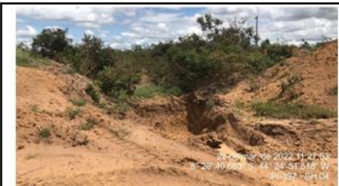
Poço de drenagem feito pela concessionária seco.
