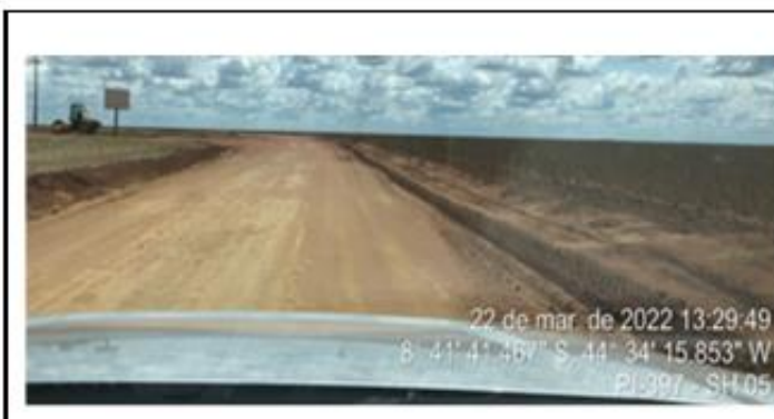
Rolo compactador liso usado nos serviços de conformação da pista.
