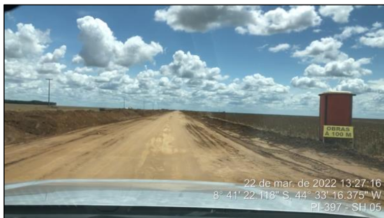
Figura 58 - Sinalização provisória de obra no SH-05
