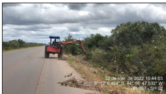
Figura 33 – Execução do serviço de roçada com equipamento no SH 02
