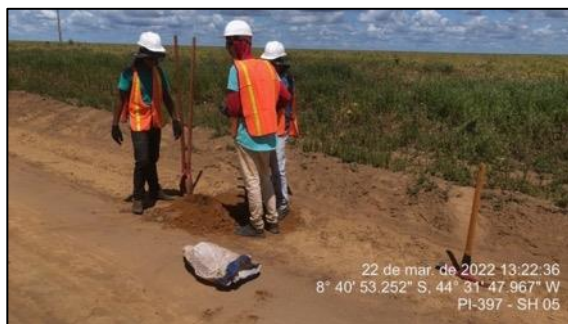
Figura 53 - Equipe de laboratório realizando coleta de materiais – SH-05
