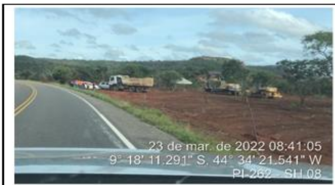
Canteiro de obra avançado da Construtora Hidros LTDA a serviço da SETRANS-PI.
