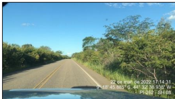
Figura 94 - Vegetação densa nos bordos da rodovia - SH-08
