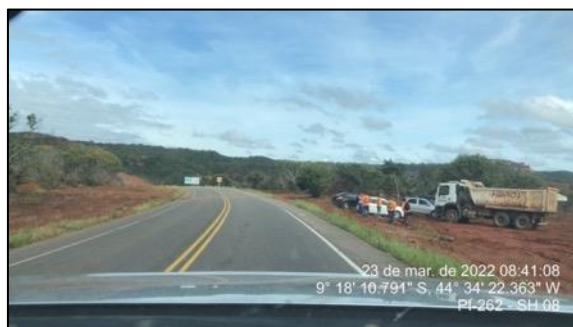
Figura 81 – Mobilização da Construtora Hidros no SH-08
