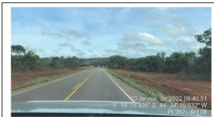
Faixa de domínio limpa pela Construtora Hidros LTDA a serviço da SETRANS-PI.
