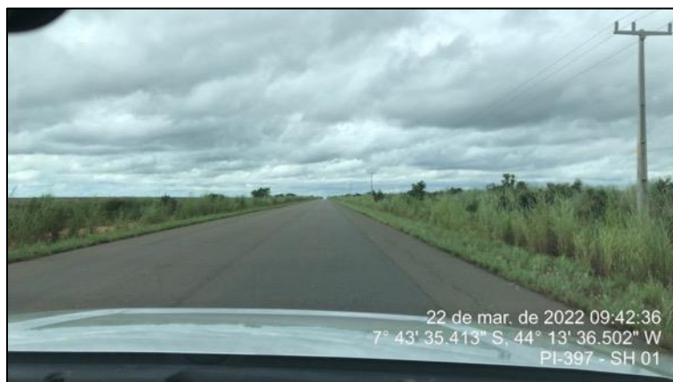
Figura 27 - Margens da rodovia após o serviço de capina e roçada no SH 01
