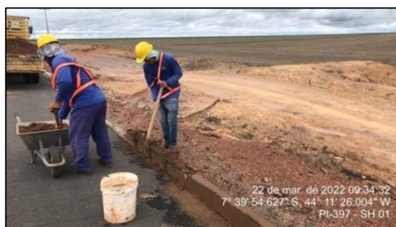
Figura 24 – Meio-fio sendo reparado no SH 01 – Lado direito
