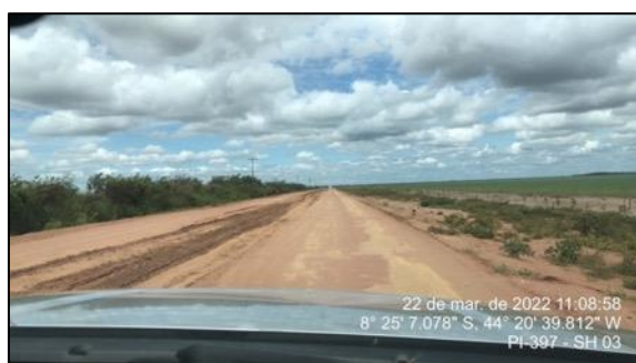
Figura 38 - Pista de rolamento em março/22 - SH 03
