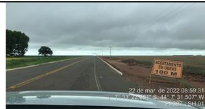
Placa de aviso de obras no segmento.
