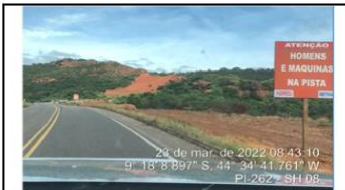
Obra de correção do traçado da Serra do Quiombo, km 33,65 da Rodovia PI-262, executada pela Construtora Hidros LTDA a serviço da SETRANS-PI.
