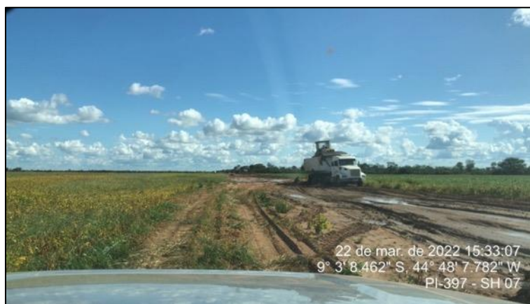
Figura 66 - Ponto de atolamento no SH-07
