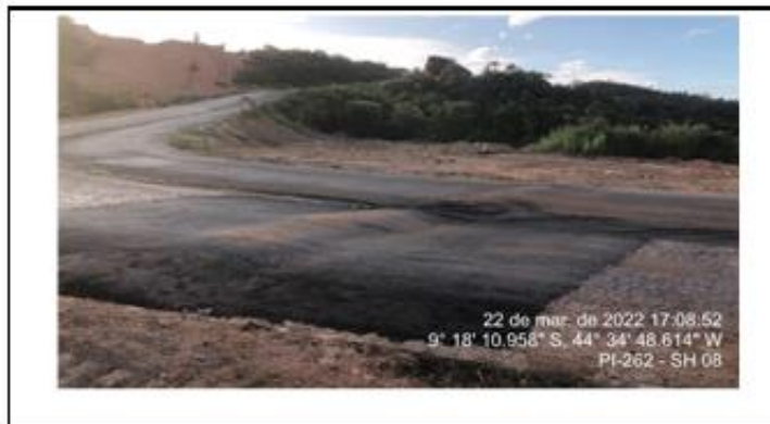
Quebra-molas reparado pela equipe de serviço da concessionária.
