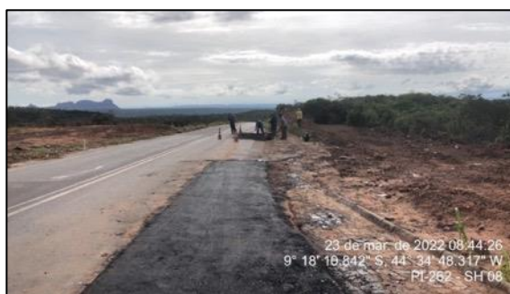
Figura 77 – Reparo de buracos na via – SH-08 – março/2022
