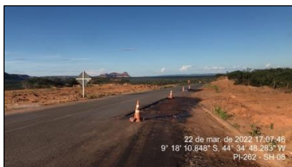
Figura 76 – Reparo de buracos na via – SH-08 – março/2022
