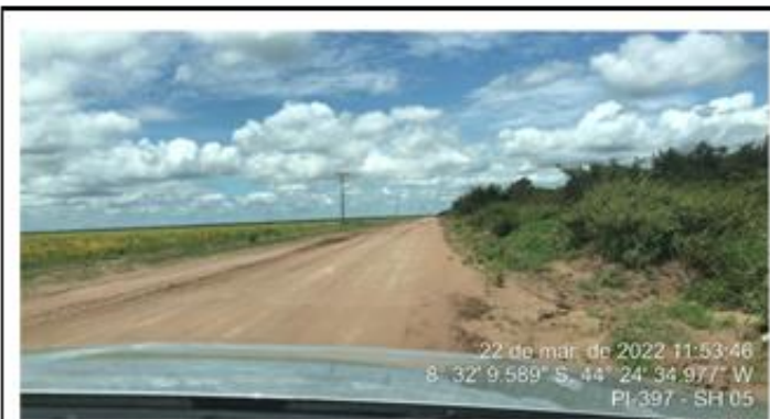
Início do segmento homogêneo 5 - segmento em leito natural. Vegetação alta no bordo da pista.
