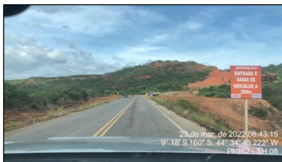
Figura 82 – Início das obras de correção do traçado no SH-08
