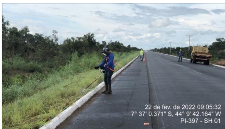
Figura 26 - Serviço de capina e roçada iniciado em fevereiro/2022 no SH 01
