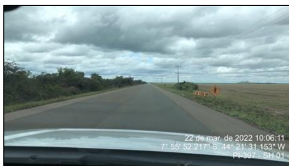
Figura 22 – Sinalização de obras no SH 01
