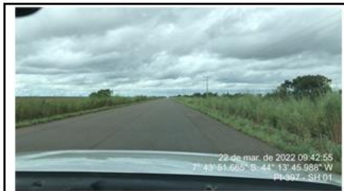
Bordos da pista após serviço de roçada de acordo com o previsto no PER.
