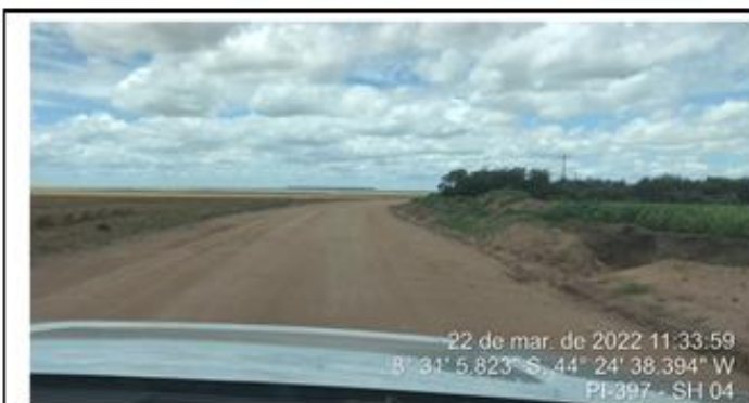
Poço de drenagem feito pela concessionária em perfeito funcionamento.
