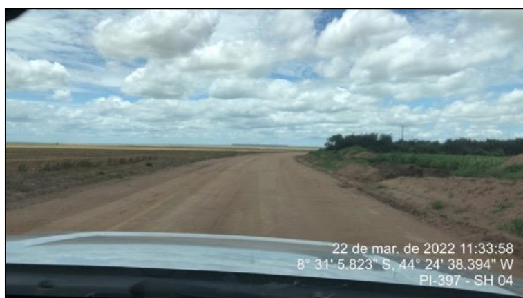
Figura 45 - Pista de rolamento sem acúmulo de água no SH-04
