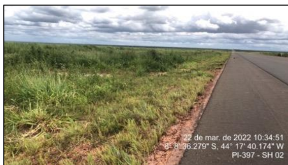
Figura 34 – Vegetação baixa após execução do serviço de roçada no SH 02
