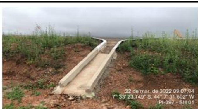
Descida d'água reparada pela concessionária.
