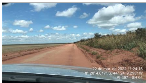
Figura 42 – Eixo da rodovia com elevação inferior ao bordo direito – SH-04
