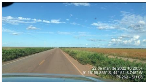
Figura 88 - Drenagem obstruída por acúmulo de sedimentos - SH-08
