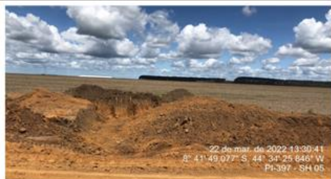
Novos poços de drenagem feitos pela equipe de serviço da concessionária.
