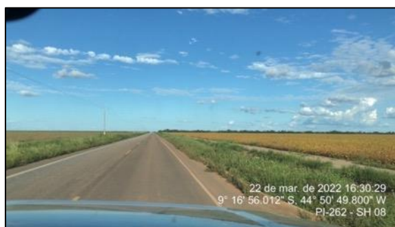
Figura 92 – Meio-fio obstruído devido a obstrução da drenagem pela vegetação - SH-08
