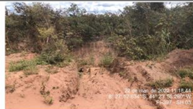
Poço de drenagem seco.
