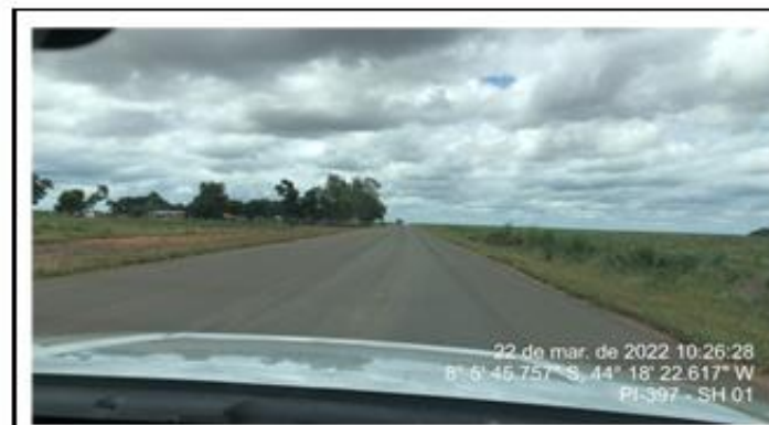
Final do segmento homogêneo 1 - Ainda com ausência de sinalização horizontal.
