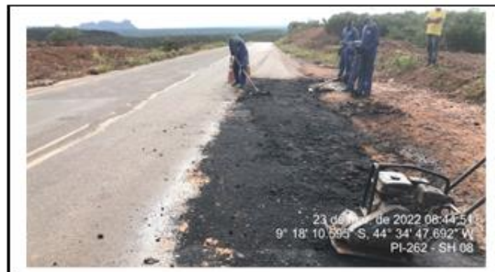
Equipe de serviço da concessionária fazendo reparos nos buracos da pista.
