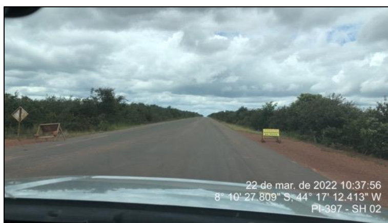
Figura 31 - Sinalização provisória de obra no SH 02
