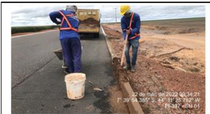
Frete serviço da concessionária, fazendo reparos no meio fio da pista.
