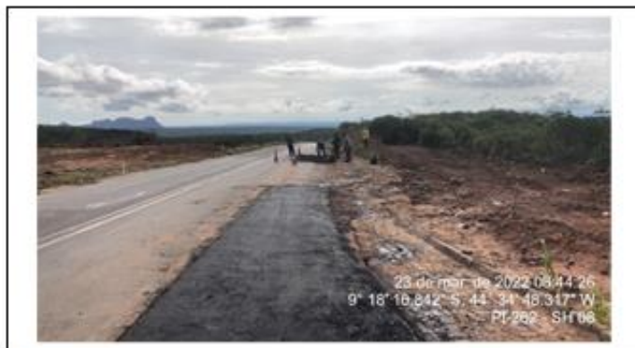
Buraco de grande proporção reparado pela equipe de serviço da concessionária.
