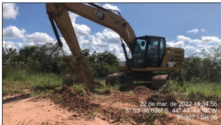
Figura 60 - Frente de abertura de poços de drenagem no SH-06
