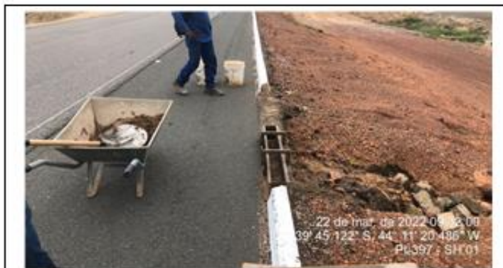
Frente serviço da concessionária, fazendo reparos no meio fio da pista.
