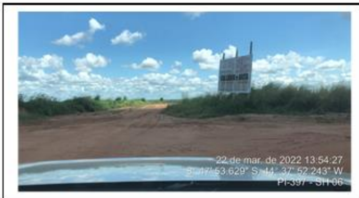
Início do segmento homogêneo 6 - segmento em leito natural.
