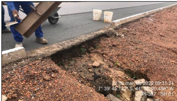
Figura 25 - Processo de reparo em dispositivo de drenagem evitando continuidade do processo erosivo por concentração de fluxo d'água
