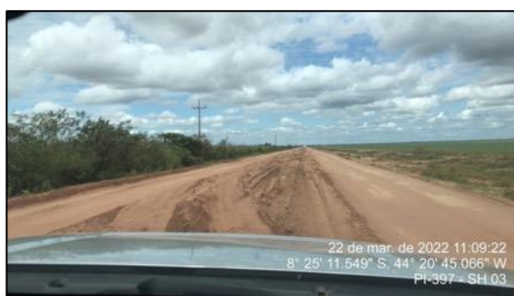
Figura 39 - Pista de rolamento em março/22 - SH 03
