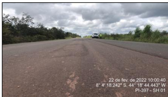
Figura 15 - Desnível entre faixas contíguas – SH01
