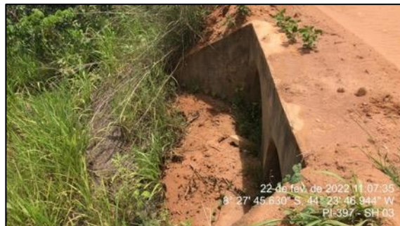
Figura 38 - Saída do Bueiro celular localizado no final do Segmento 03
