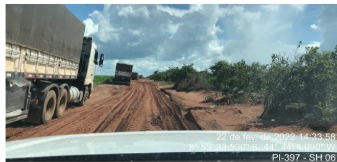
Caminhões atolados devido a instabilidade do solo.
