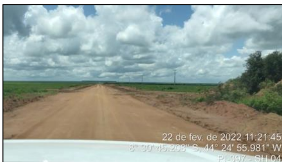
Figura 46 - Pista de rolamento - SH 04
