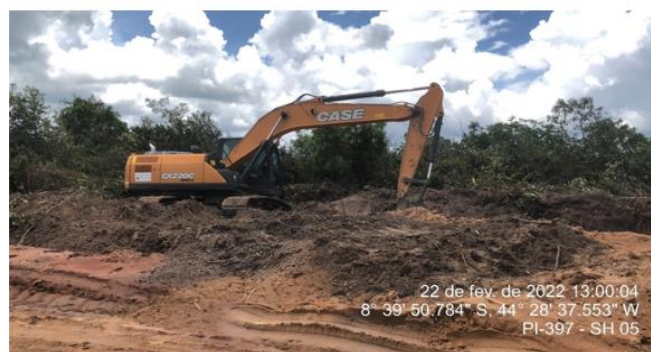
Maquinário realizando a abertura dos poços de drenagem .
