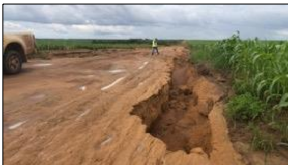
Figura 59 - Bordos da estrada com processo erosivo em janeiro/22 - SH 06
