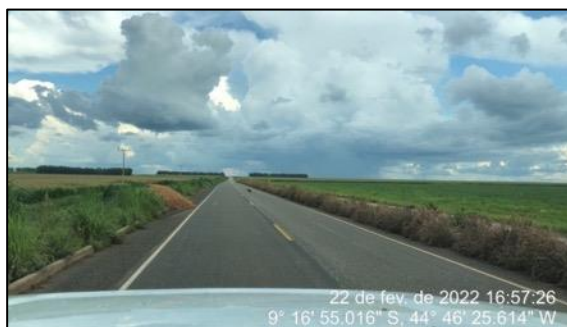
Figura 86 - Drenagem obstruída por ação humana - SH-08
