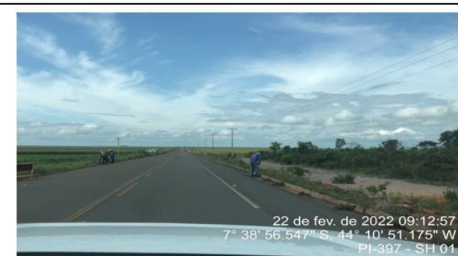
Equipe da concessionária fazendo a Limpeza da vegetação nos leitos da pista.
