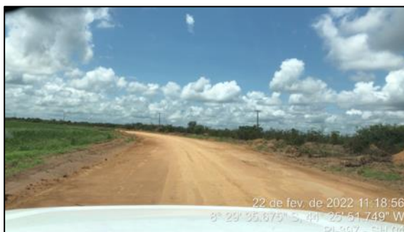
Figura 47 - Pista de rolamento - SH 04
