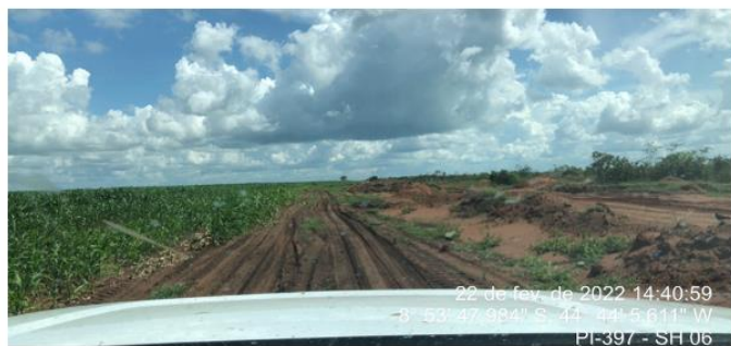
Atoleiro comprometendo a pista, necessário desvio em propriedades privadas.
