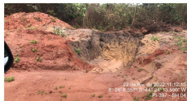
Poço de drenagem feito pela concessionária .
