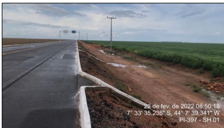
Figura 24 - Meio fio e descida d'água em fevereiro/22
