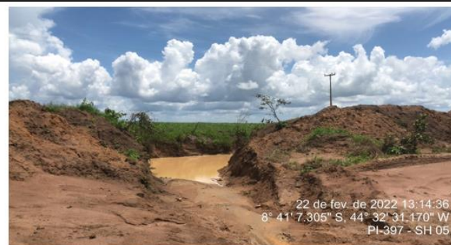
Poço de drenagem cheio.
