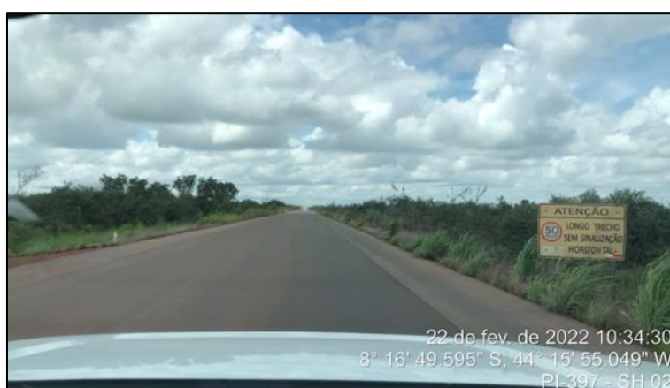
Figura 31 - Placa informando a falta de sinalização horizontal - Divisa entre SH 02 e SH 03
