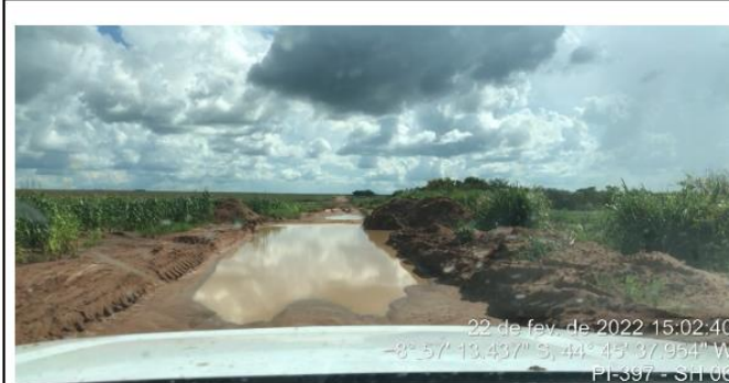
Buraco de grande proporção comprometendo a pista.
