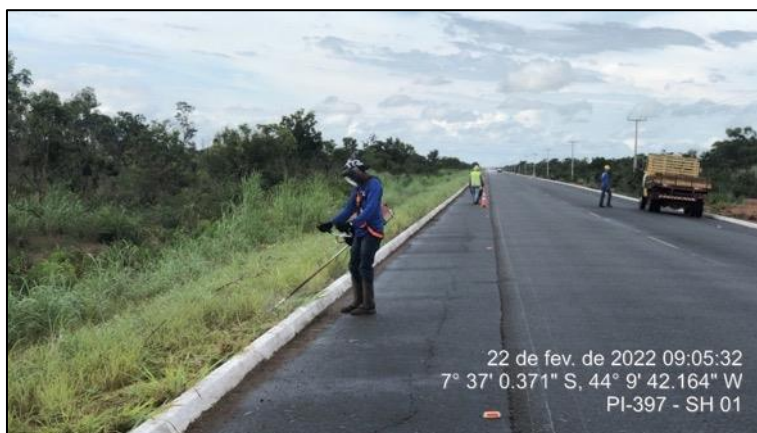
Figura 26 – Início dos serviços de roçada
