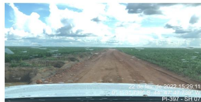
Poços de drenagem já existentes.
