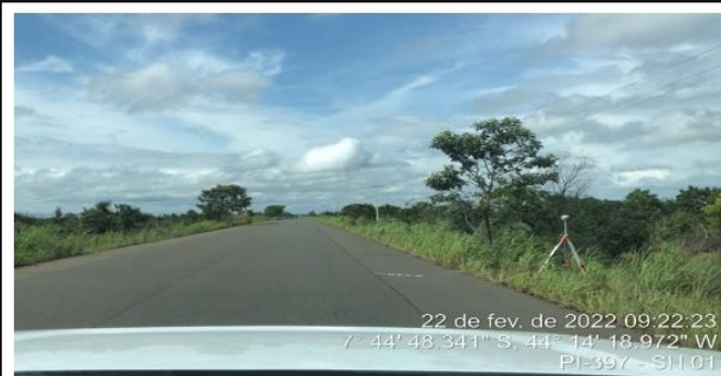
Equipe de topografia fazendo locações na pedágio 1, no KM 24,49, na localização sugerida pela concessionária.
