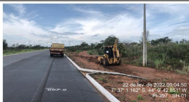
Maquinário da concessionária fazendo a Limpeza na faixa de domínio.
