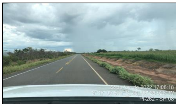
Figura 83 - Falta de sinalização vertical de ultrapassagem proibida - SH-08
