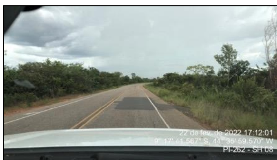
Figura 72 – Reparo no pavimento do segmento 08
