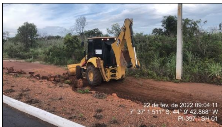
Figura 27 - Limpeza da faixa de domínio
