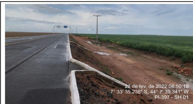
Meio fio e descida d'água pintados. Os Leitos da pista estão limpos.
