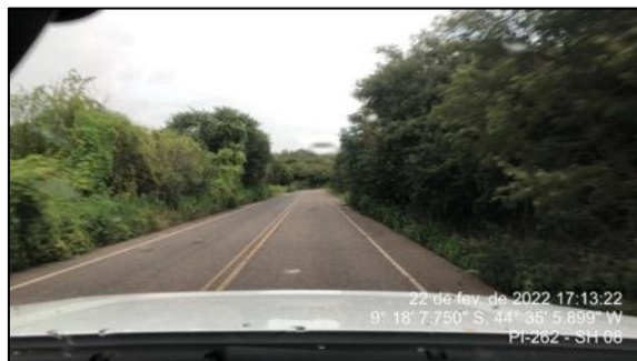
Figura 90 - Vegetação densa nos bordos da rodovia - SH-08
