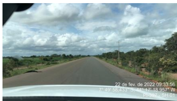
Figura 22 - Trecho sem sinalização horizontal ou vertical - SH 01
