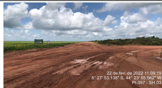
Final do segmento homogêneo 3 – segmento não pavimentado.
