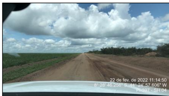
Figura 42 - Saída do Bueiro celular localizado no final do Segmento 03
