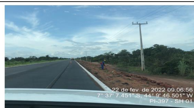
Equipe da concessionária fazendo a Limpeza da faixa de domínio.
