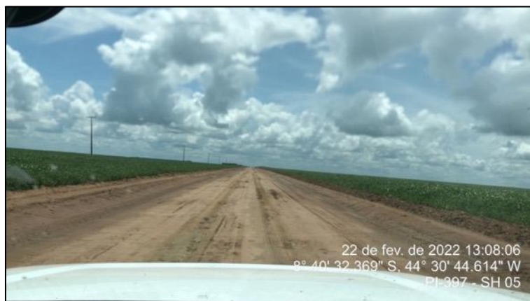
Figura 56 - Rodovia conformada em leiro natural
