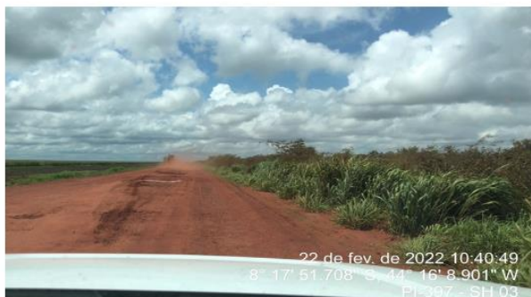
Início do segmento homogêneo 3 – segmento não pavimentado.
