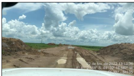
Figura 54 - Ponto de alagamento em fev/22 - SH 05
