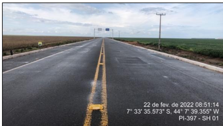
Figura 20 - Sinalização no SH 01
