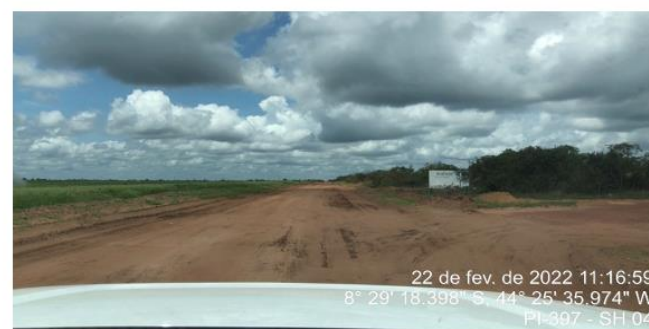
Pista sem acúmulo de água devido ao bom funcionamento dos poços de drenagem.
