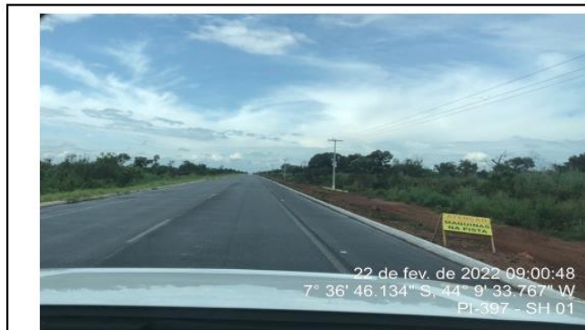
Placa de aviso de obras no segmento.
