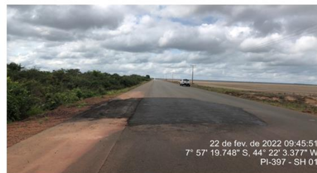
Reparo do buraco de grande proporção na pista.
