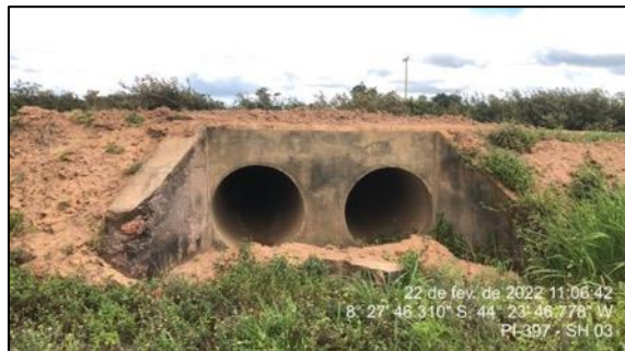
Figura 37 – Entrada do Bueiro celular localizado no final do Segmento 03
