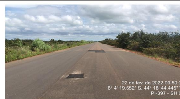
Reparo dos buracos na pista.
