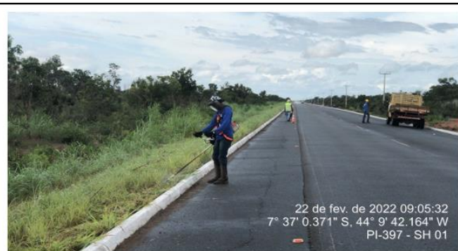
Equipe da concessionária fazendo a Limpeza da vegetação na faixa de domínio.
