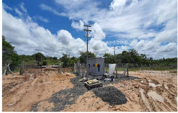
Figuras 9 a 13 – transformador e obras para o cabeamento subterrâneo
