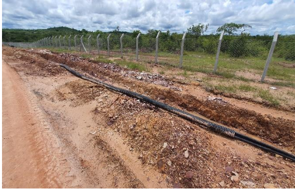
Figuras 38 a 43 – obras para passagem de cabos pela via subterrânea
