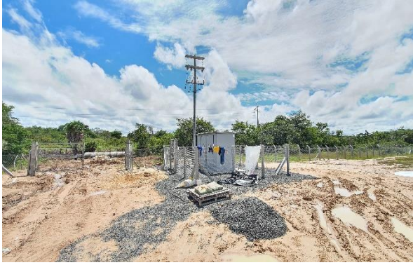
Figuras 9 a 13 – transformador e obras para o cabeamento subterrâneo
