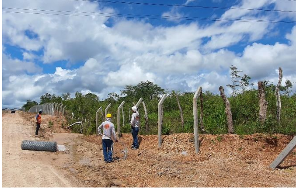
Figuras 3 a 8 – obras da cerca de delimitação interna das miniusinas
