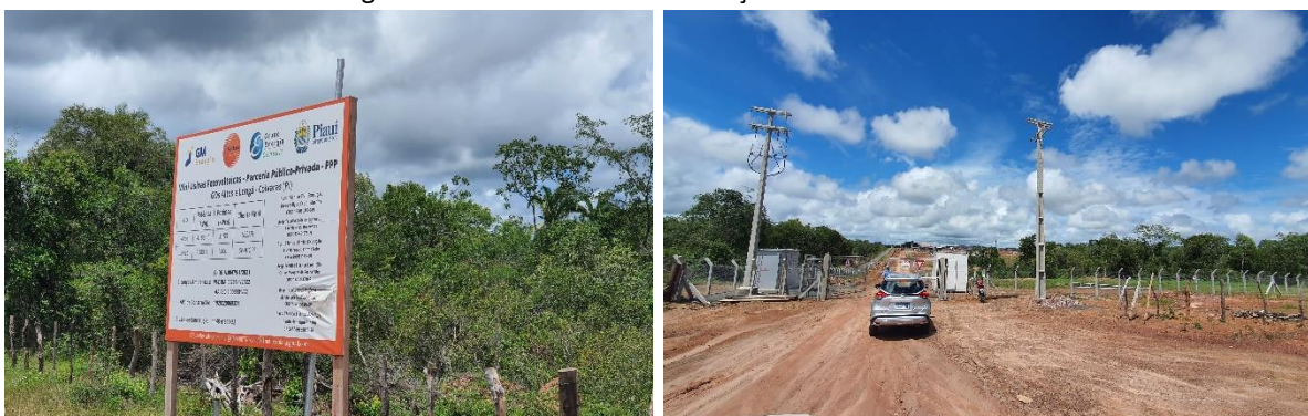
Figuras 1 e 2 – Placa de identificação da obra e entrada
