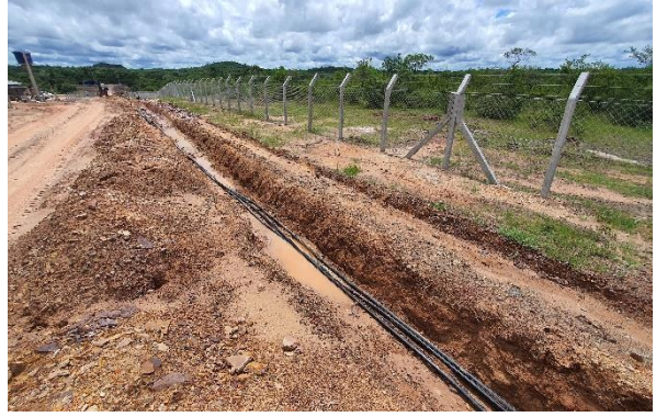
Figuras 38 a 43 – obras para passagem de cabos pela via subterrânea
