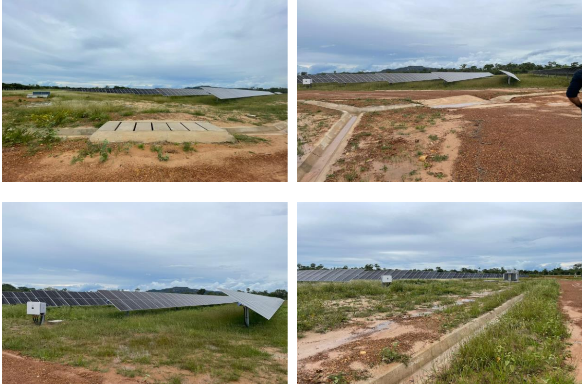
Figura 6 a 10 – painéis, inversores e sistema de drenagem
