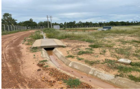
Figura 2 - Sistema de drenagem na pista da entrada do terreno
