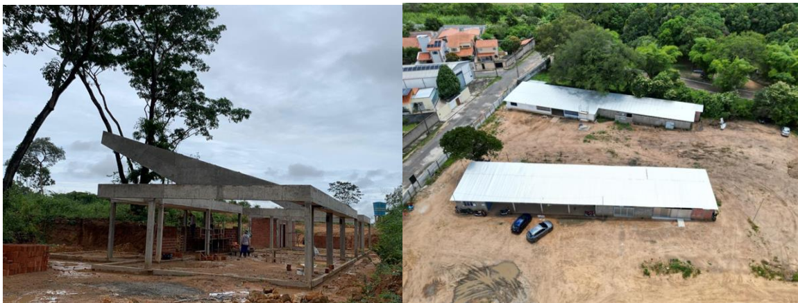
Canteiro de obras(vista aérea)
