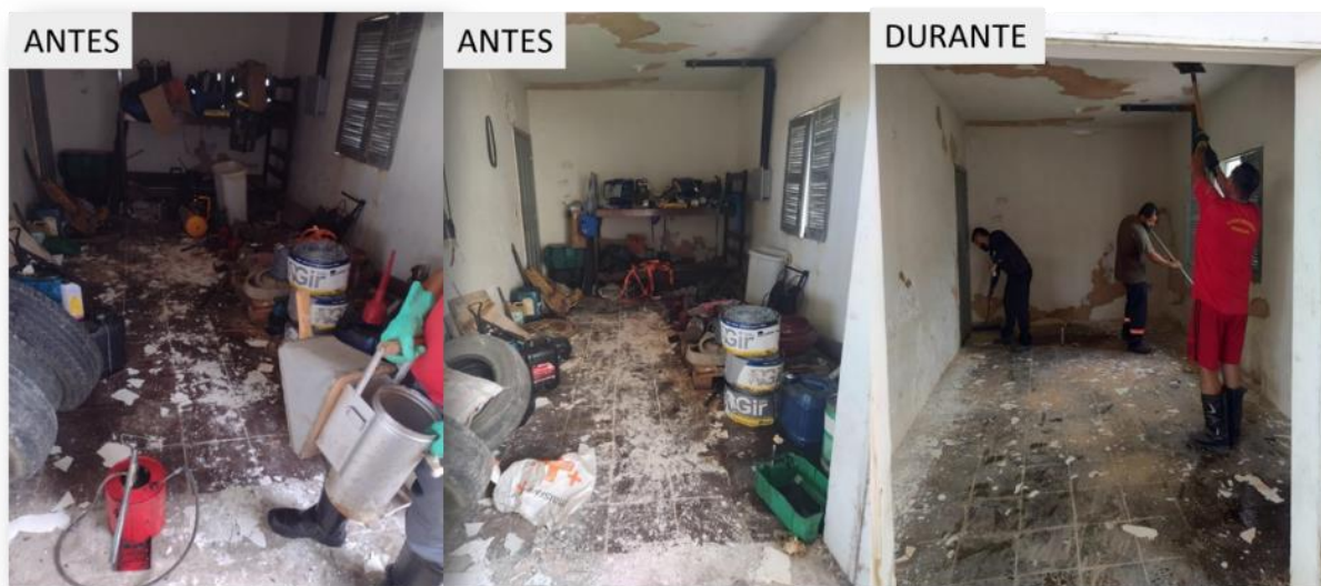
Figura 9. Trabalhos de limpeza e revitalização de sala de guarda de materiais operacionais na oficina
