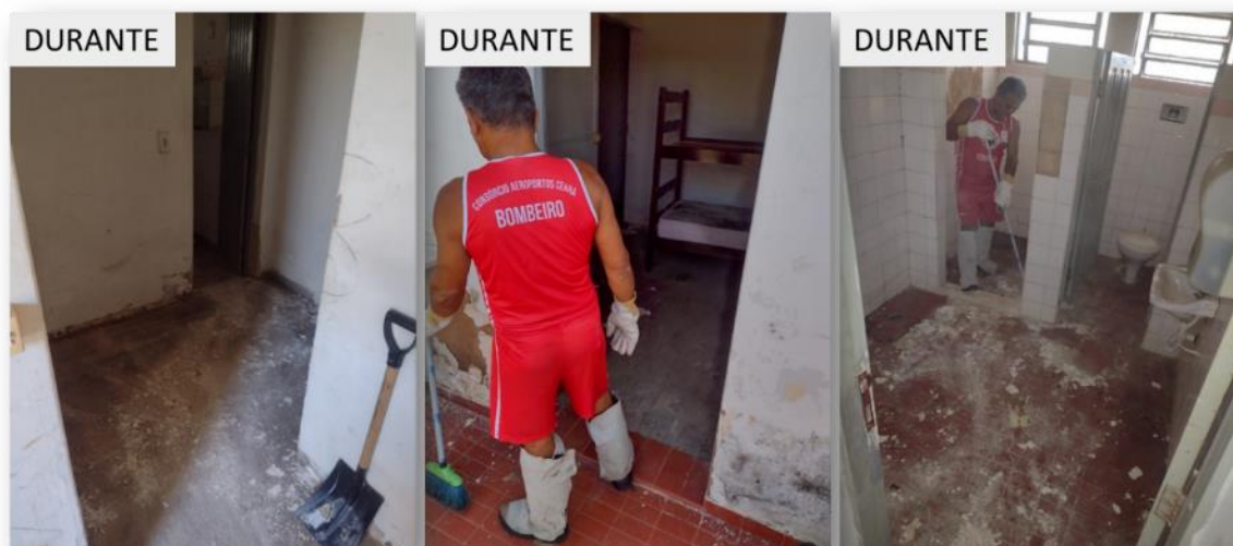
Figura 10. Trabalhos de limpeza e revitalização nas salas de dormitório e banheiro
