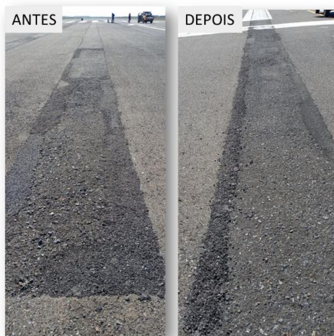
Figura 18. Demonstração de reparos pontuais realizados na PPD (2)
