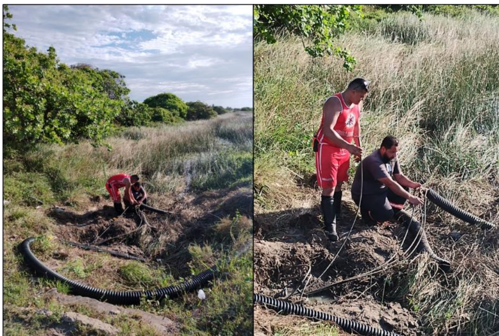
Figura 16. Trabalhos de reparo realizados pela Concessionária
