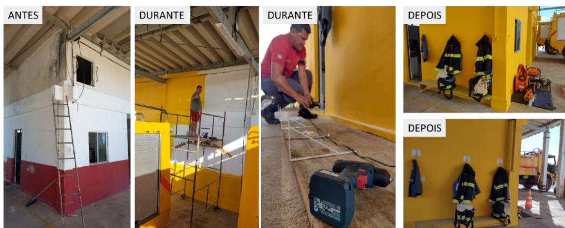
Figura 6. Trabalhos de melhoramento da estrutura operacional da SCI
