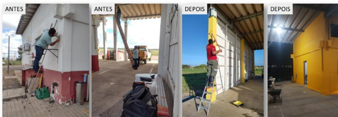
Figura 4. Realização dos trabalhos de pintura na SCI (2)
