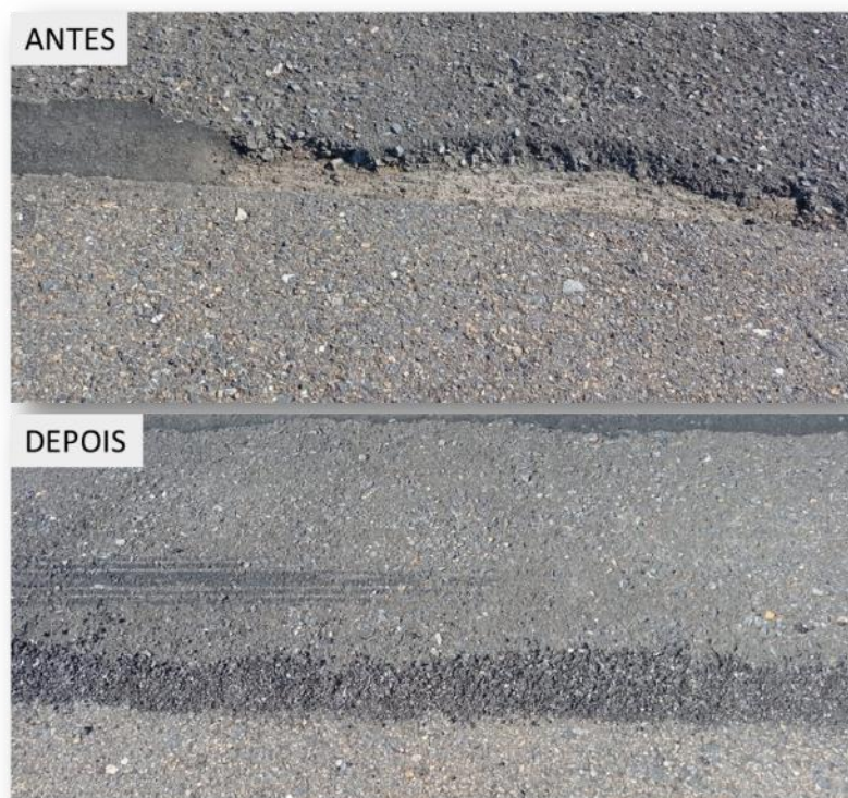
Figura 17. Demonstração de reparos pontuais realizados na PPD (1)
