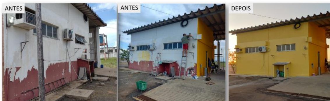
Figura 3. Realização dos trabalhos de pintura na SCI (1)
