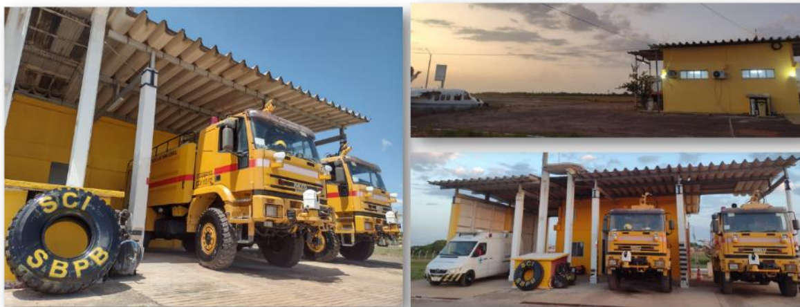
Figura 8. SCI revitalizada após os trabalhos da Concessionária
