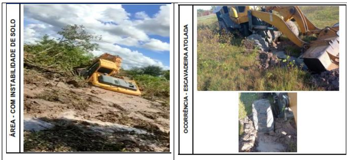
Foto 1 – Área de solo mole durante remoção da vegetação
