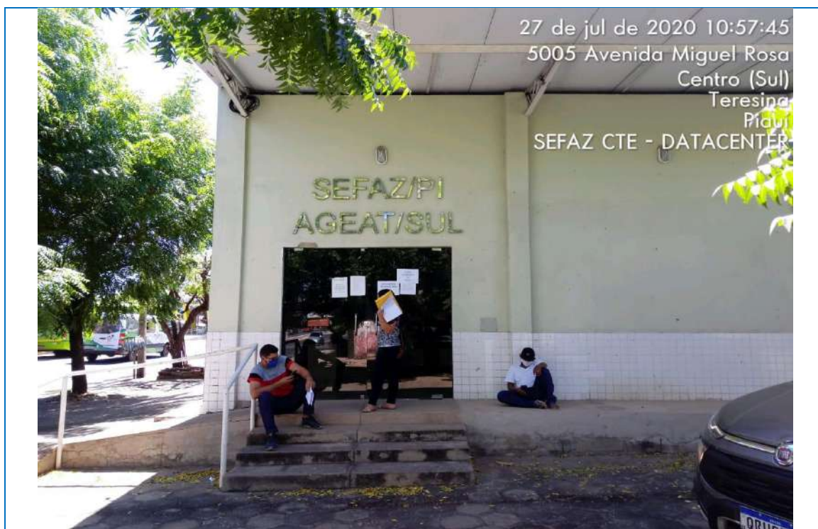
Figura 36 – PAG SEFAZ CTE (DATACENTER) - Teresina
