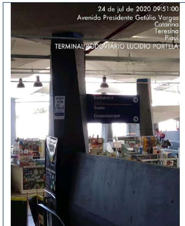
Figura 85 – PAP Terminal Rodoviário Lucídio Portela - Teresina
