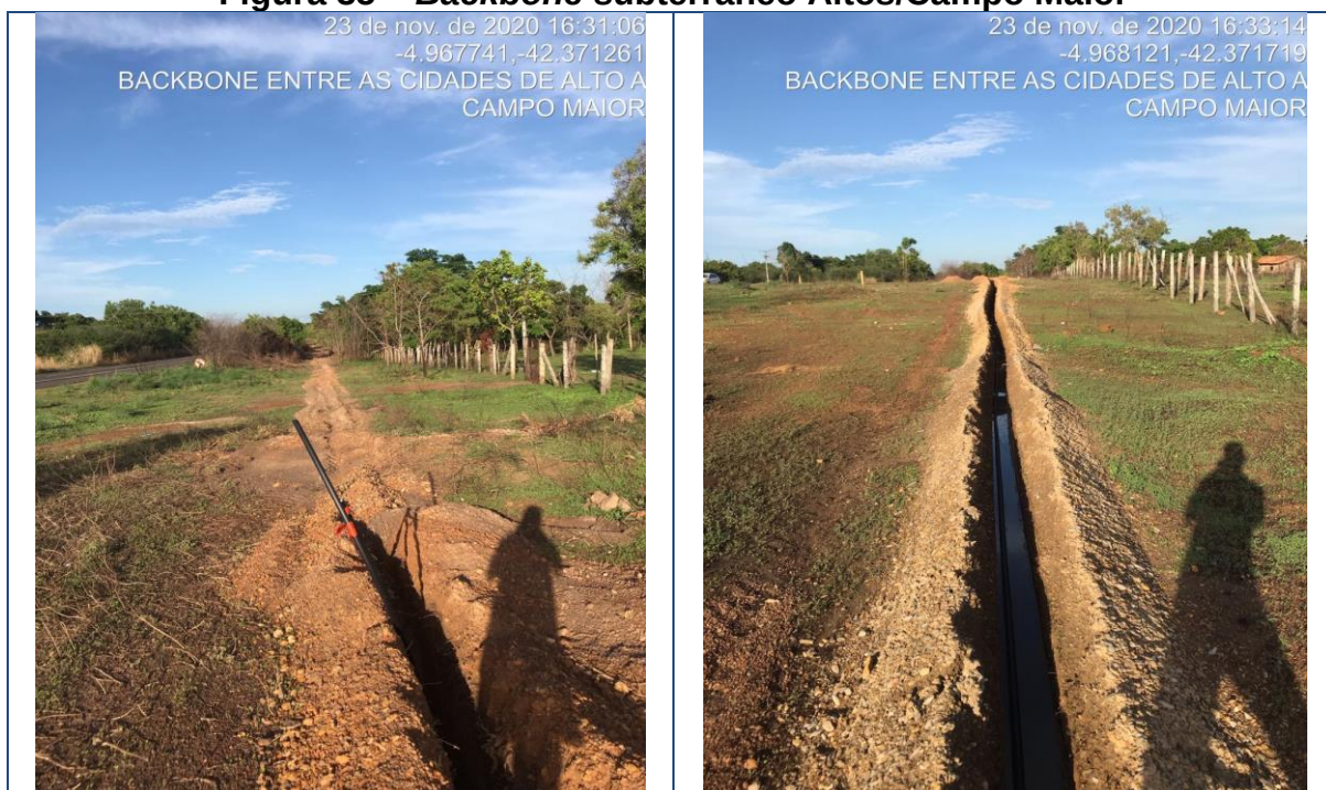
Figura 35 – Backbone subterrâneo Altos/Campo Maior
