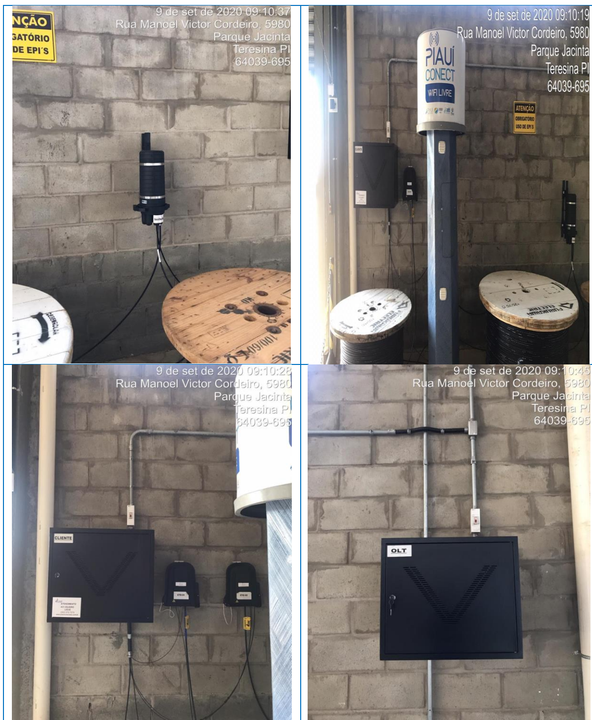
Figura 98 – Materiais e equipamentos utilizados na implantação do projeto
