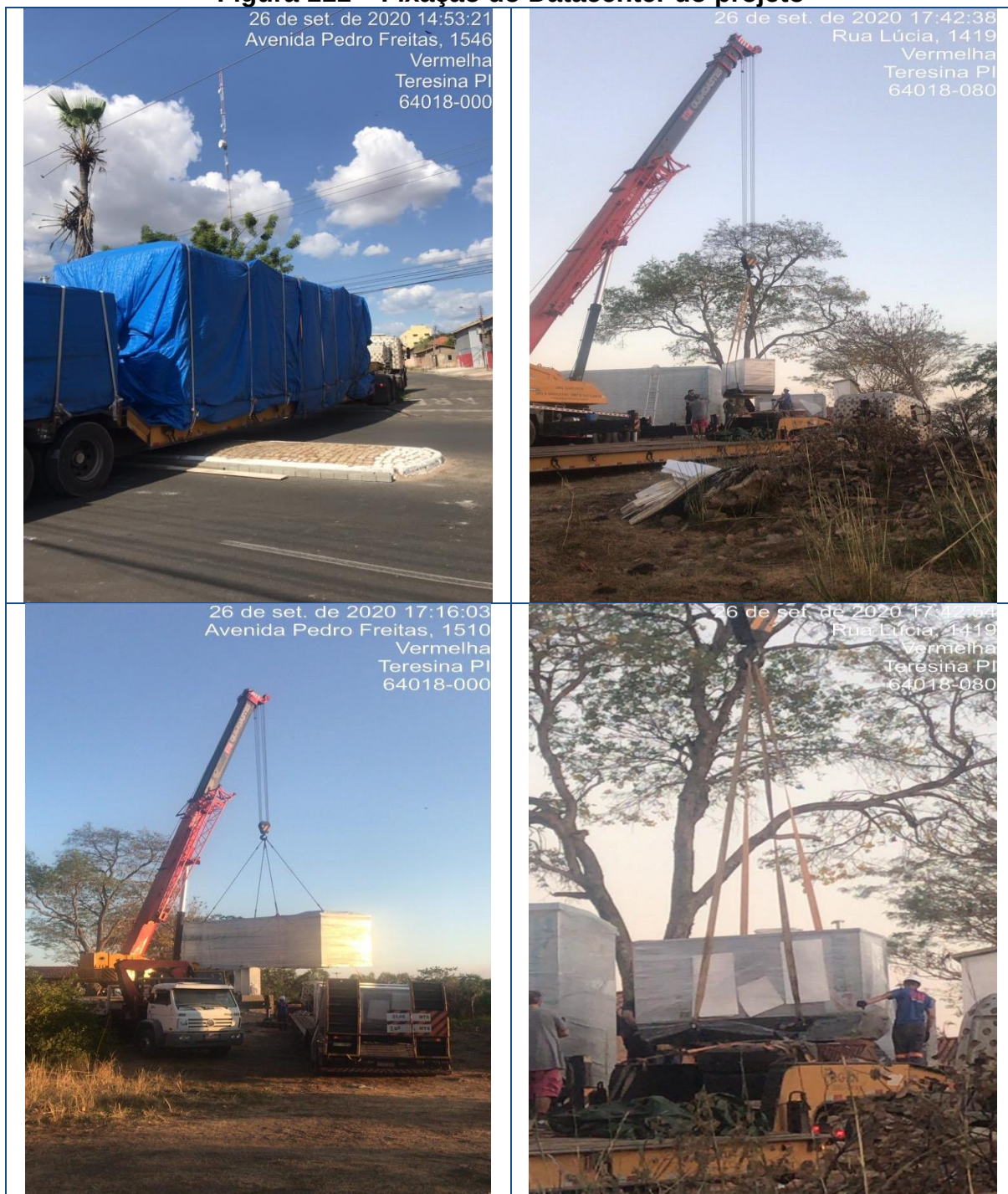
Figura 111 – Fixação do Datacenter do projeto
