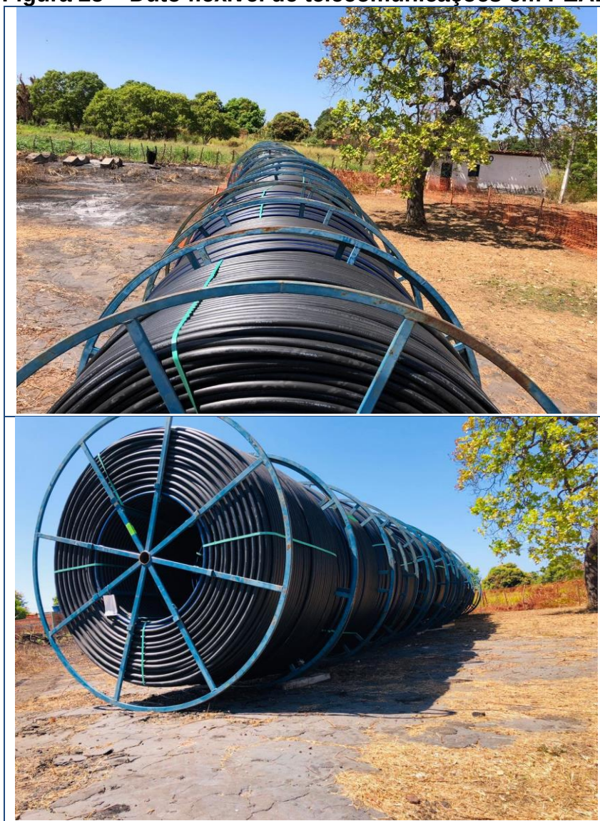
Figura 25 – Duto flexível de telecomunicações em PEAD
