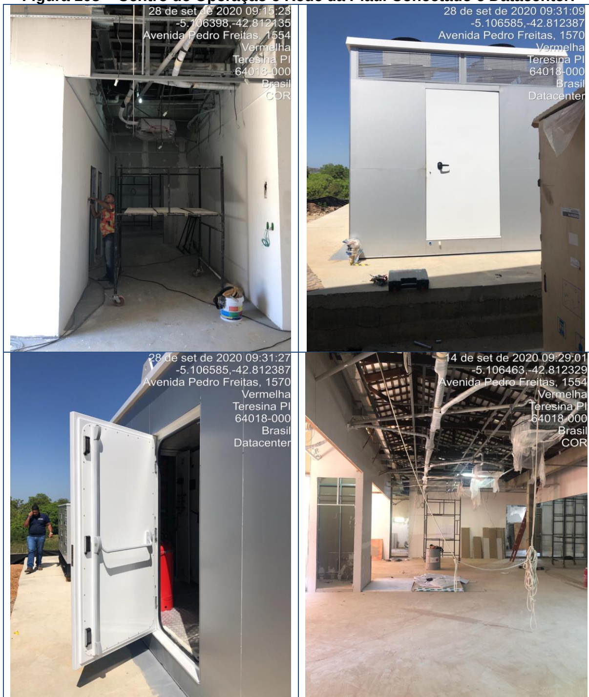
Figura 108 – Centro de Operação e Rede da Piauí Conectado e Datacenter.
