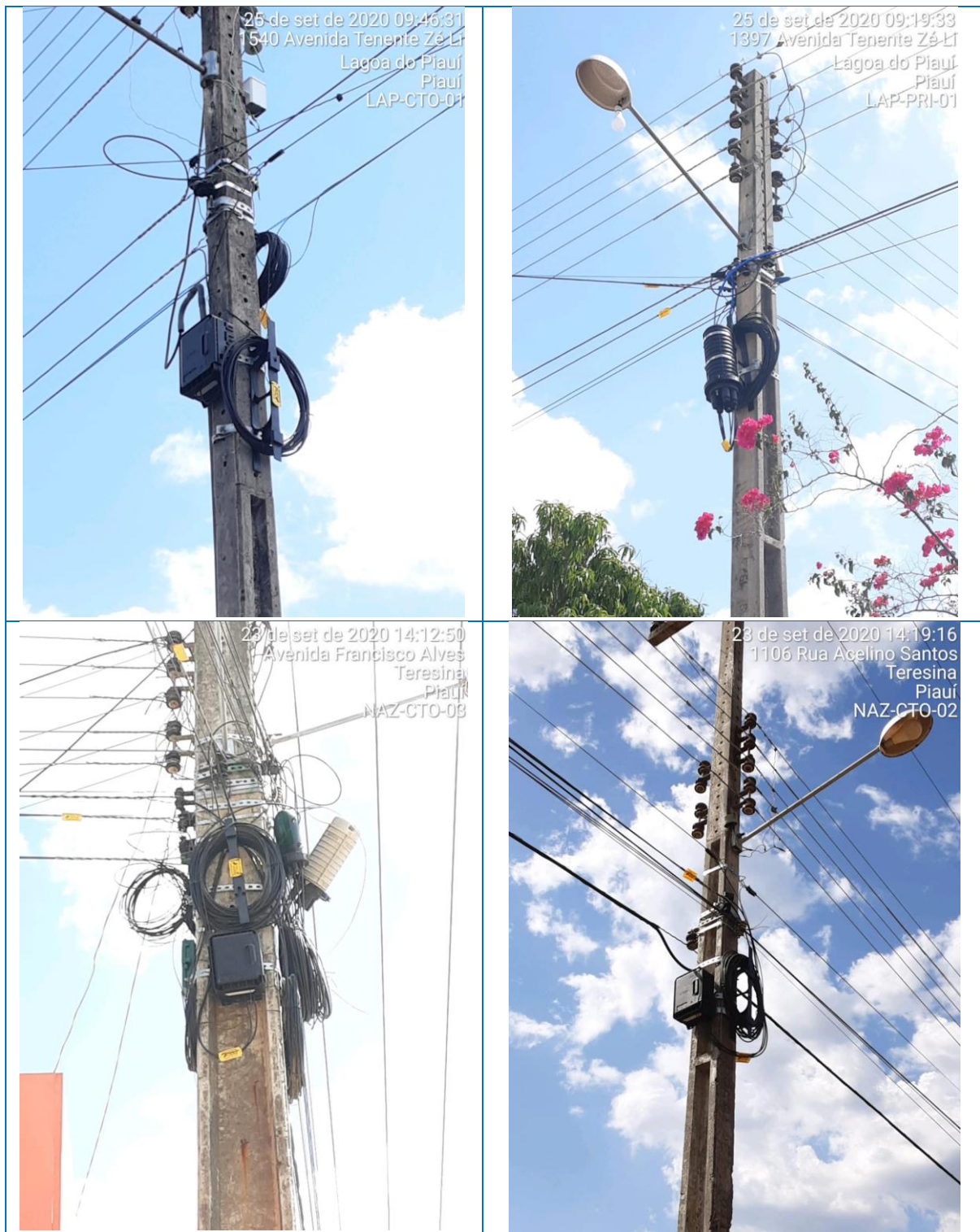
Figura 49 – Inspeção de não conformidades no lançamento da fibra óptica no mês de setembro/2020
