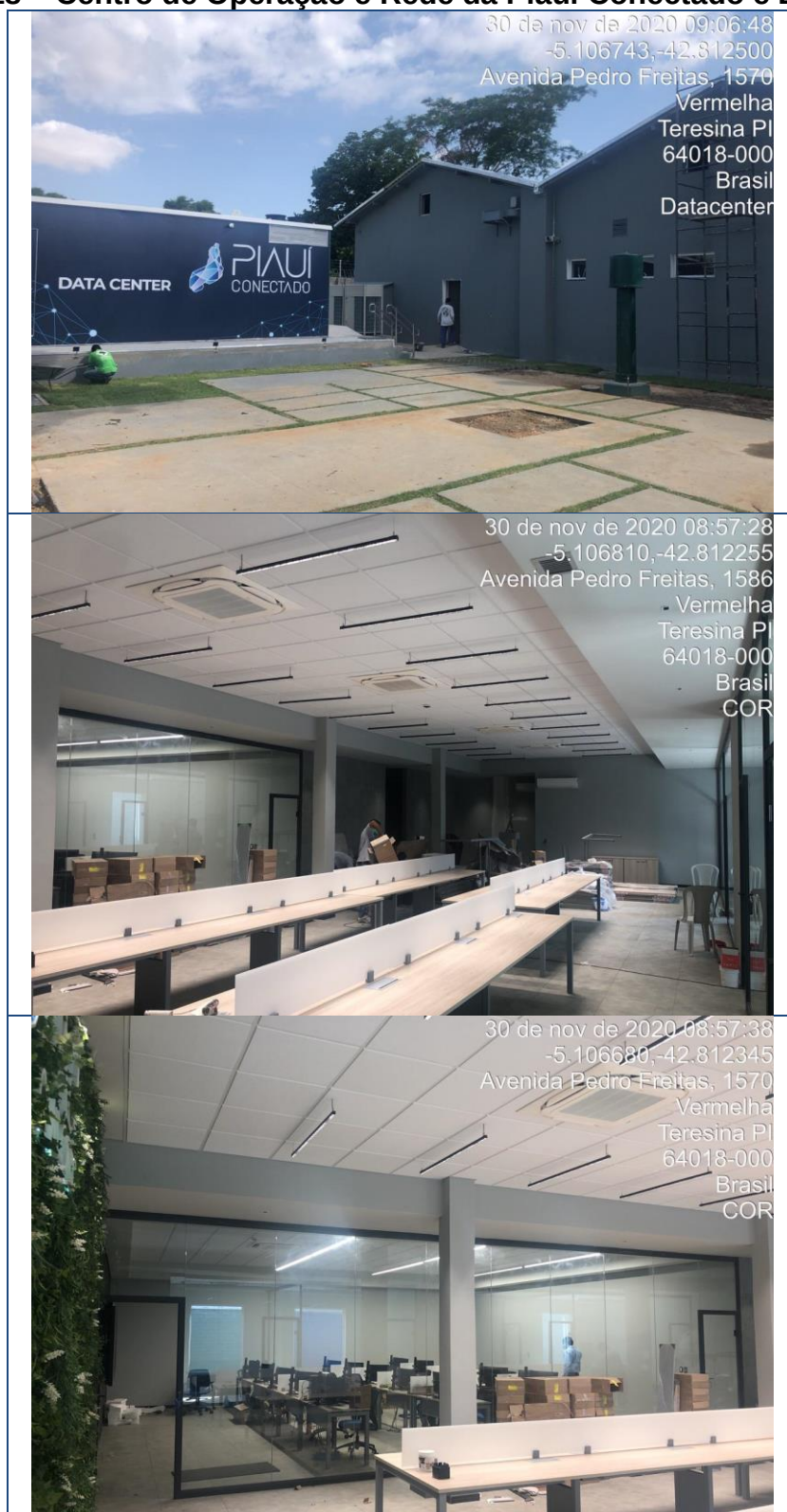
Figura 118 – Centro de Operação e Rede da Piauí Conectado e Datacenter
