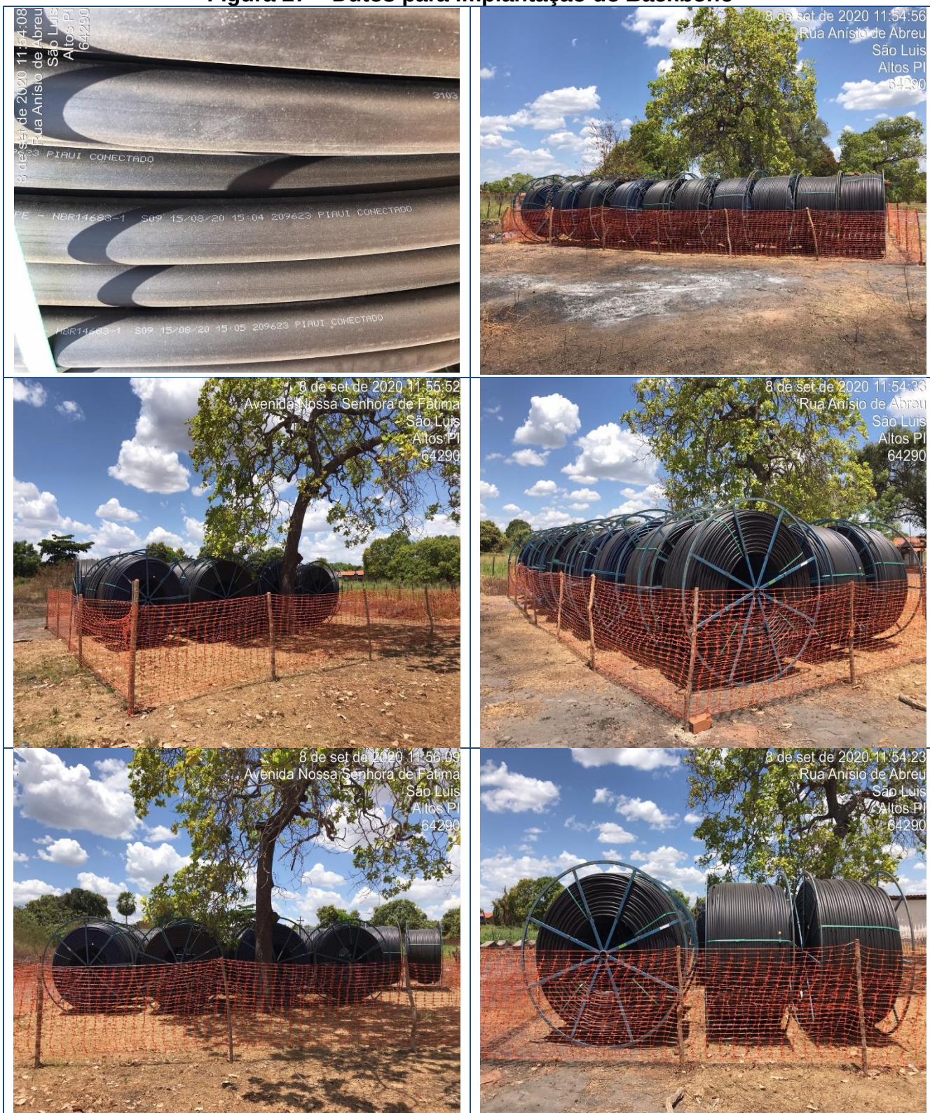
Figura 27 – Dutos para implantação do Backbone
