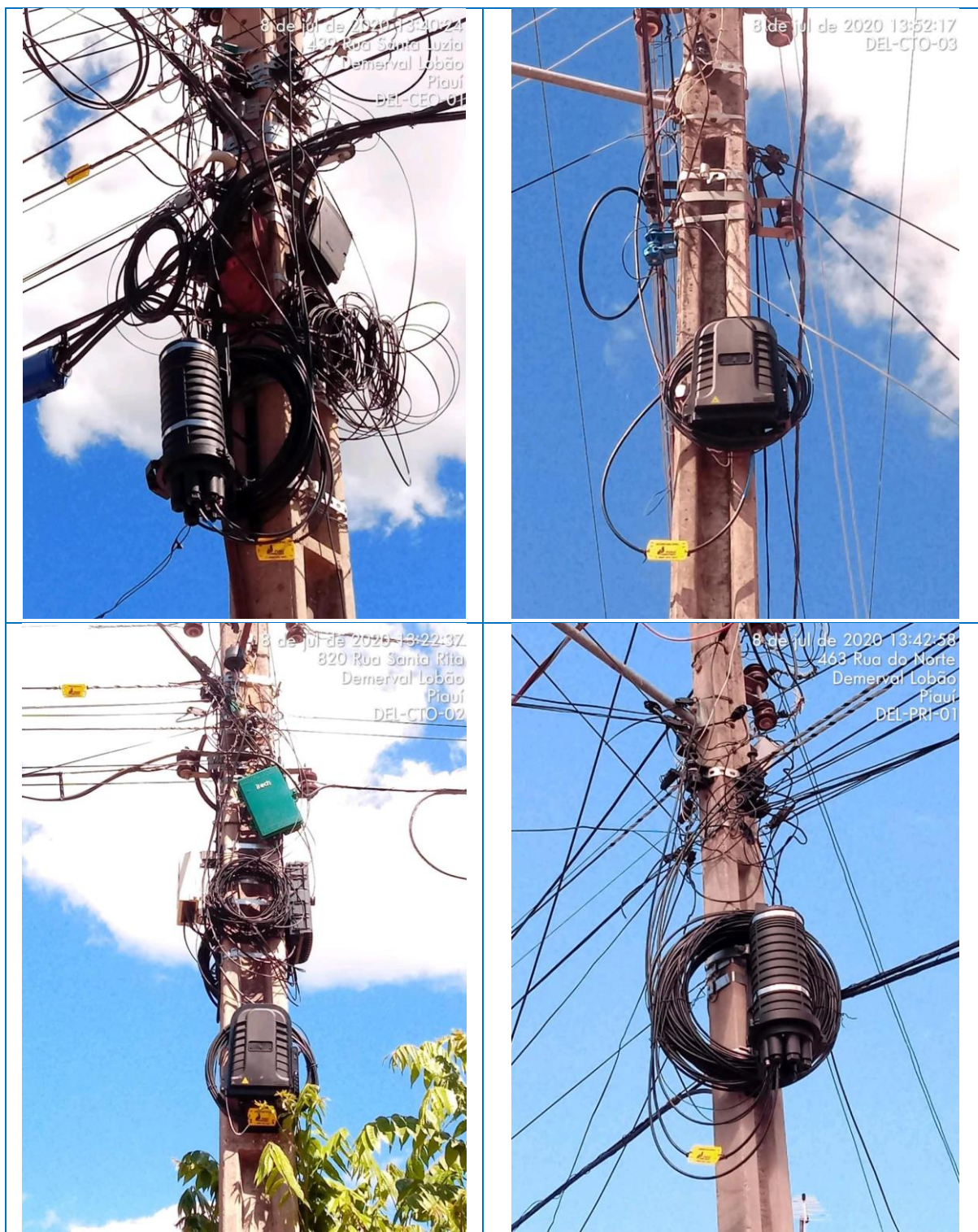
Figura 55 – Inspeção de não conformidades no lançamento da fibra óptica no mês de julho/2020
