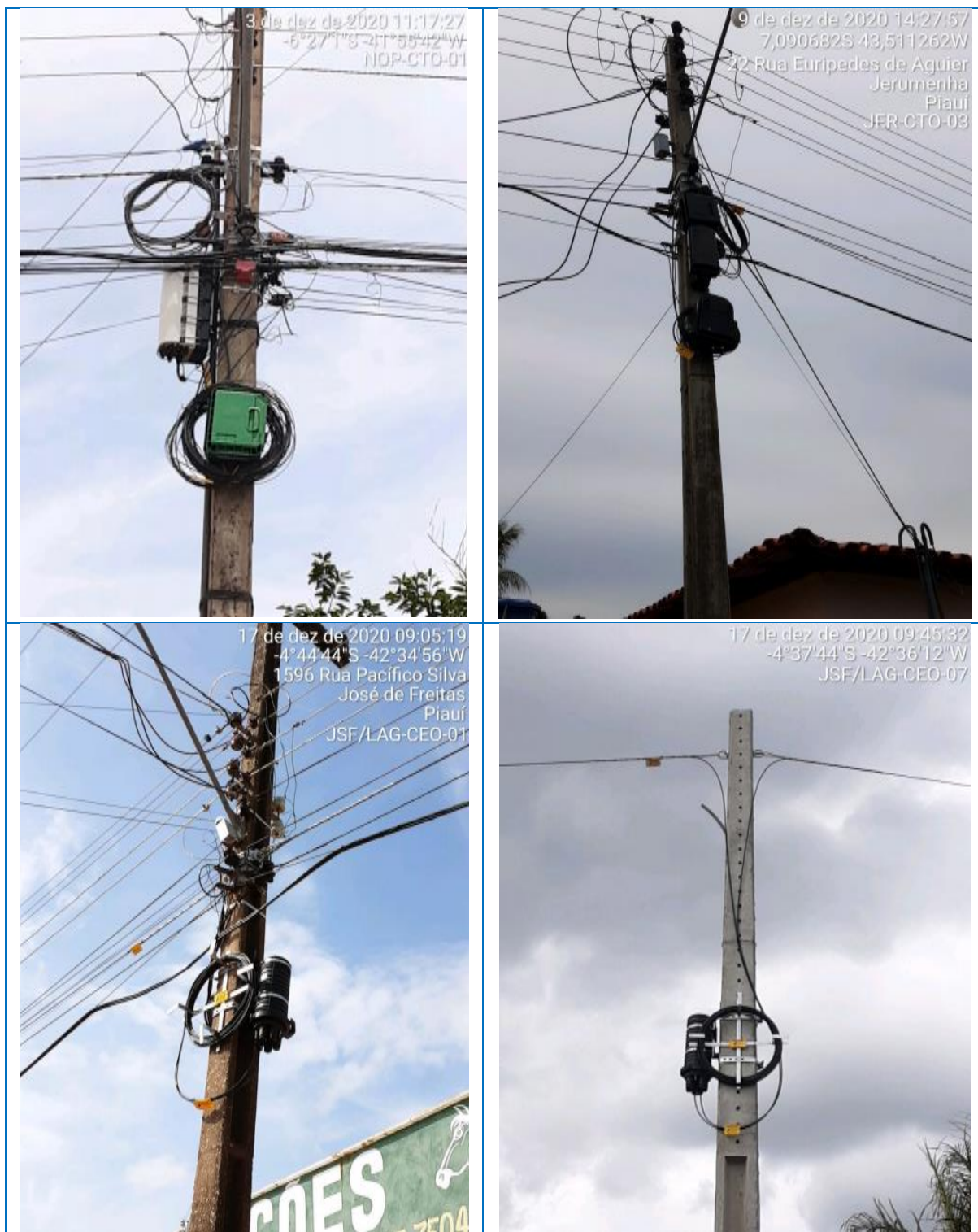
Figura 52 – Inspeção de não conformidades no lançamento da fibra óptica no mês de dezembro/2020
