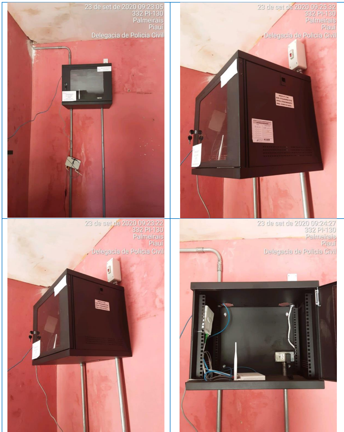
Figura 74 – Registro de inspeção de não conformidades nas instalações das unidades com internet no mês de setembro/2020
