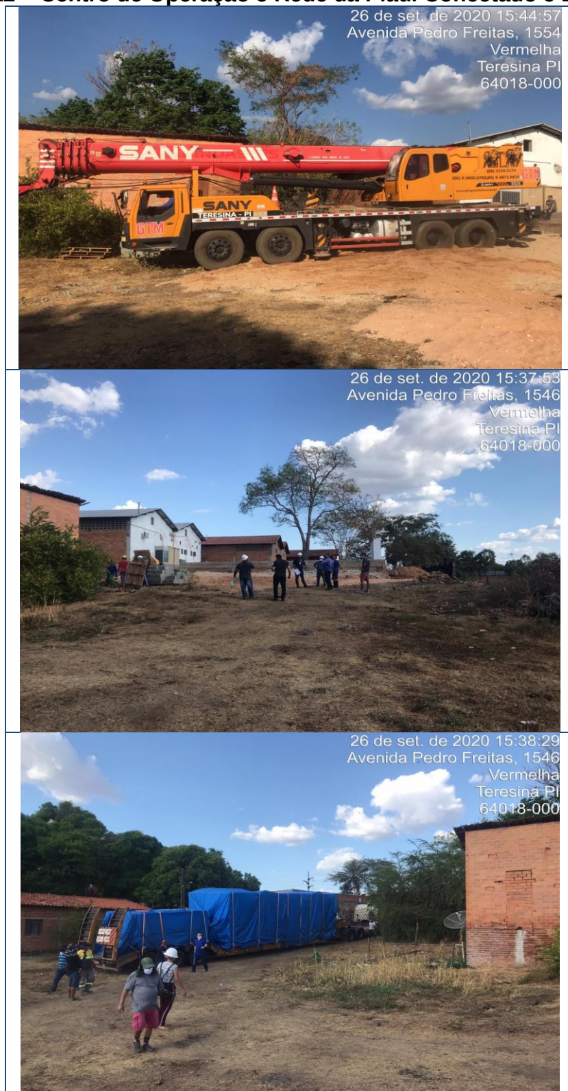
Figura 112 – Centro de Operação e Rede da Piauí Conectado e Datacenter
