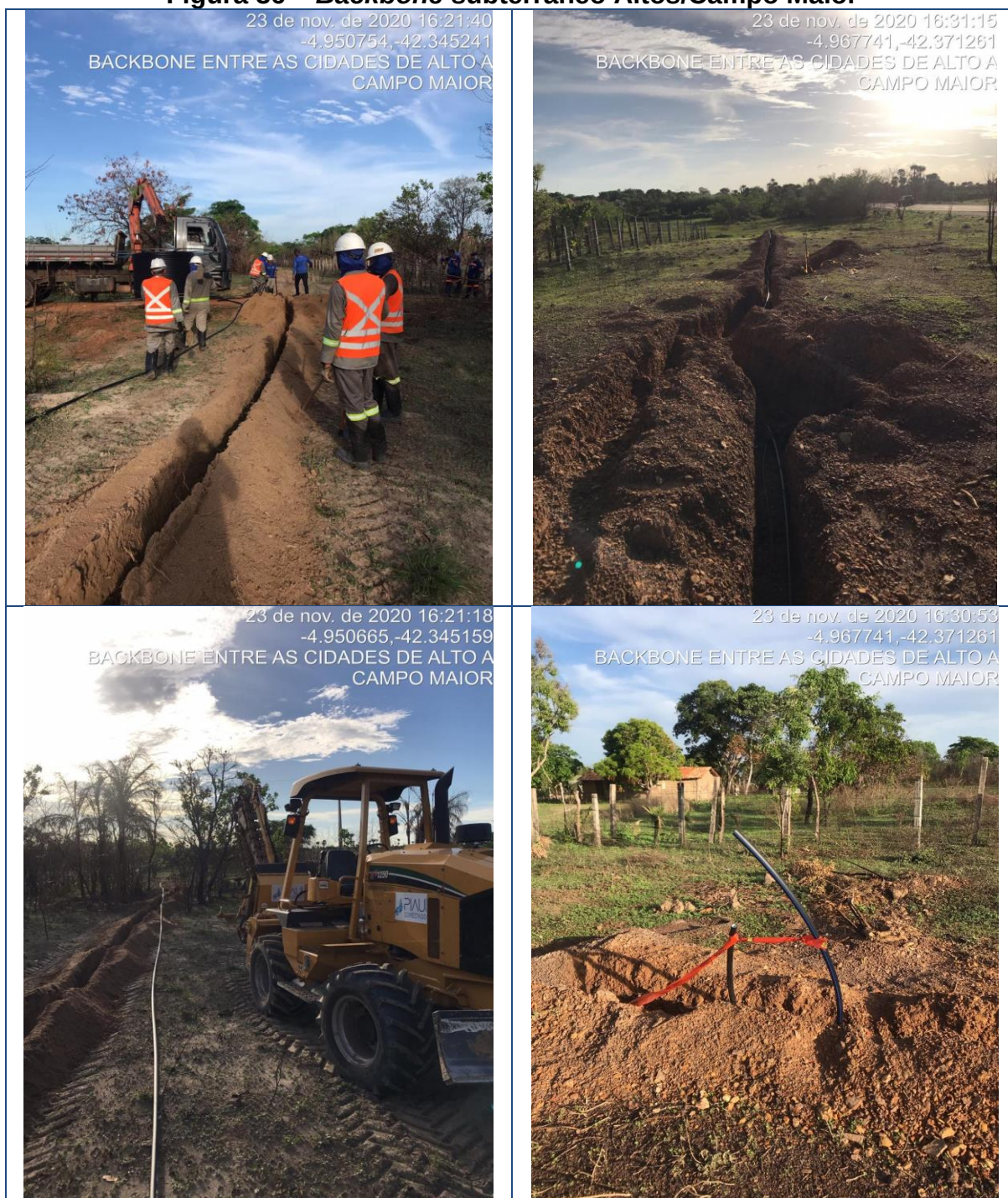
Figura 36 – Backbone subterrâneo Altos/Campo Maior
