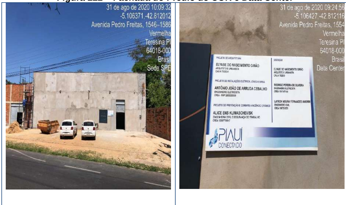
Figura 222 – Fachada do Prédio do COR e Data Center
