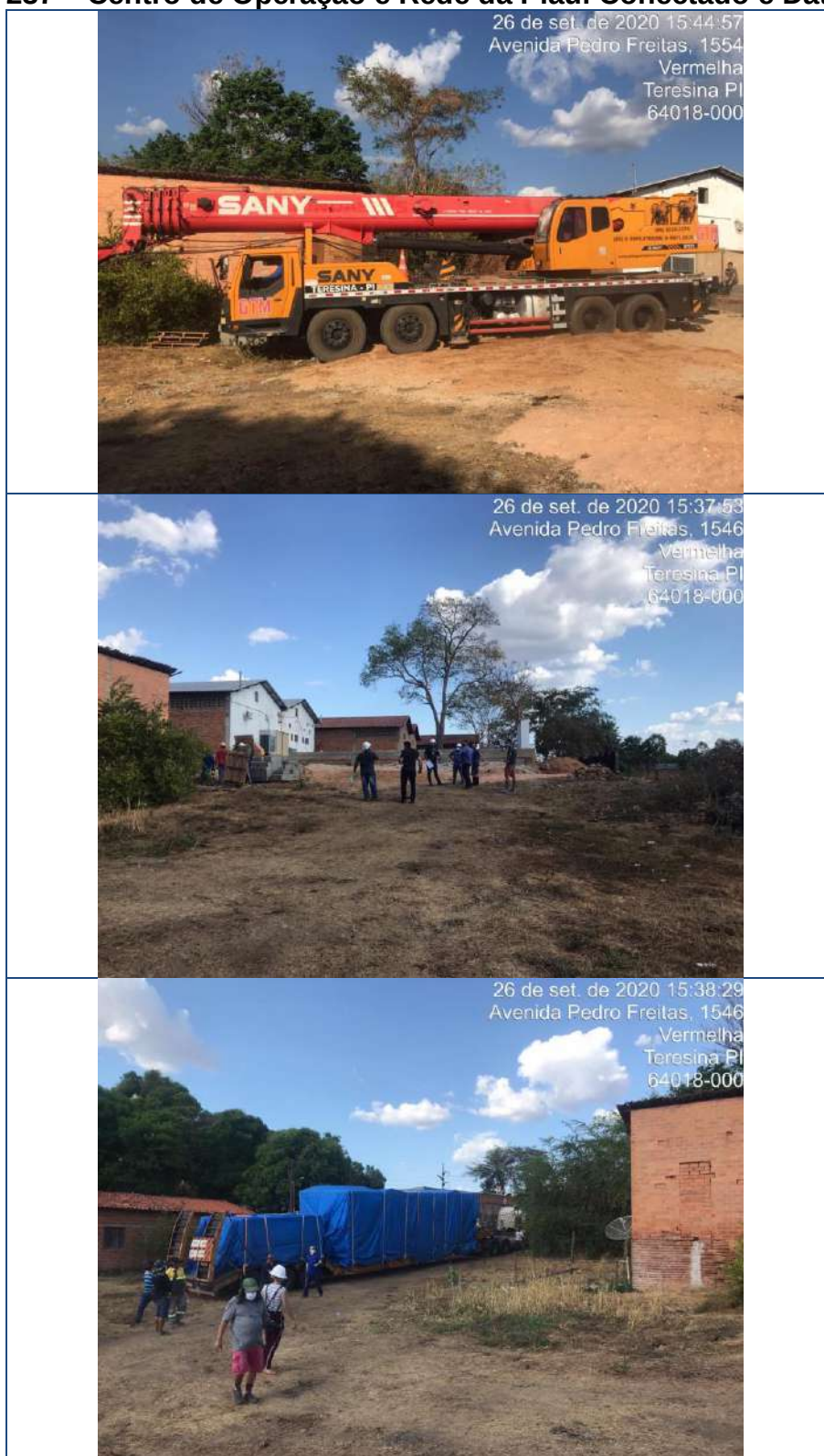
Figura 237 – Centro de Operação e Rede da Piauí Conectado e Datacenter
