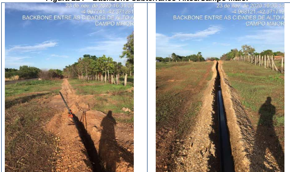
Figura 214 – Backbone subterrâneo Altos/Campo Maior
