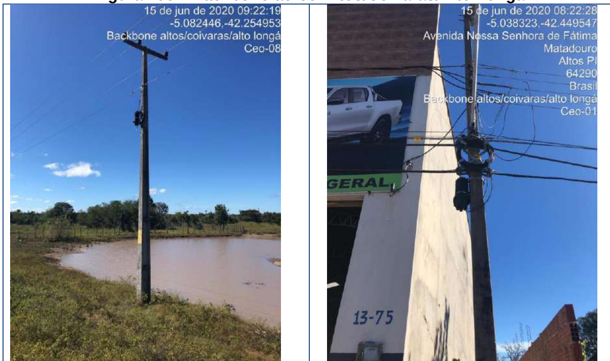
Figura 196 – Backbone aéreo Altos/Coivaras/Alto Longá
