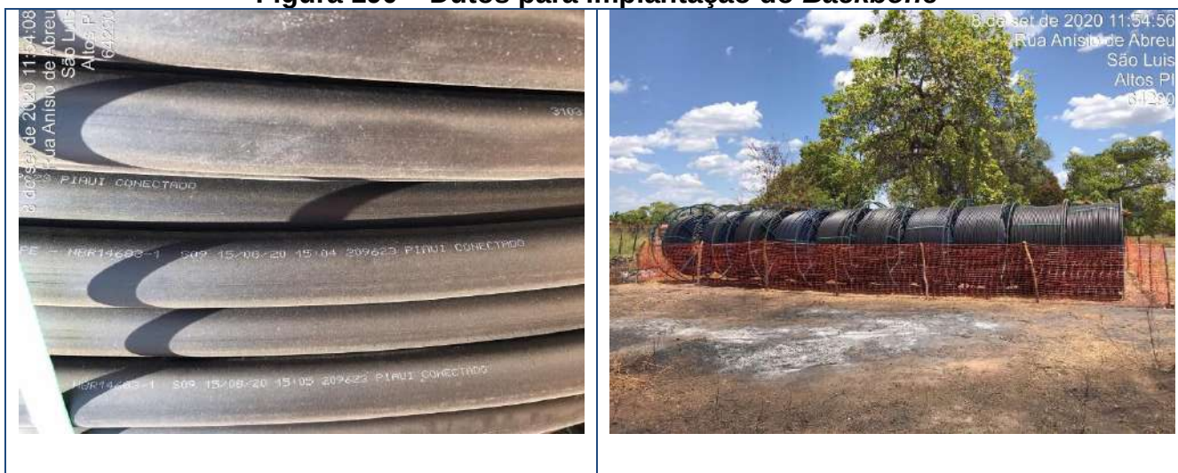
Figura 190 – Dutos para implantação do Backbone
