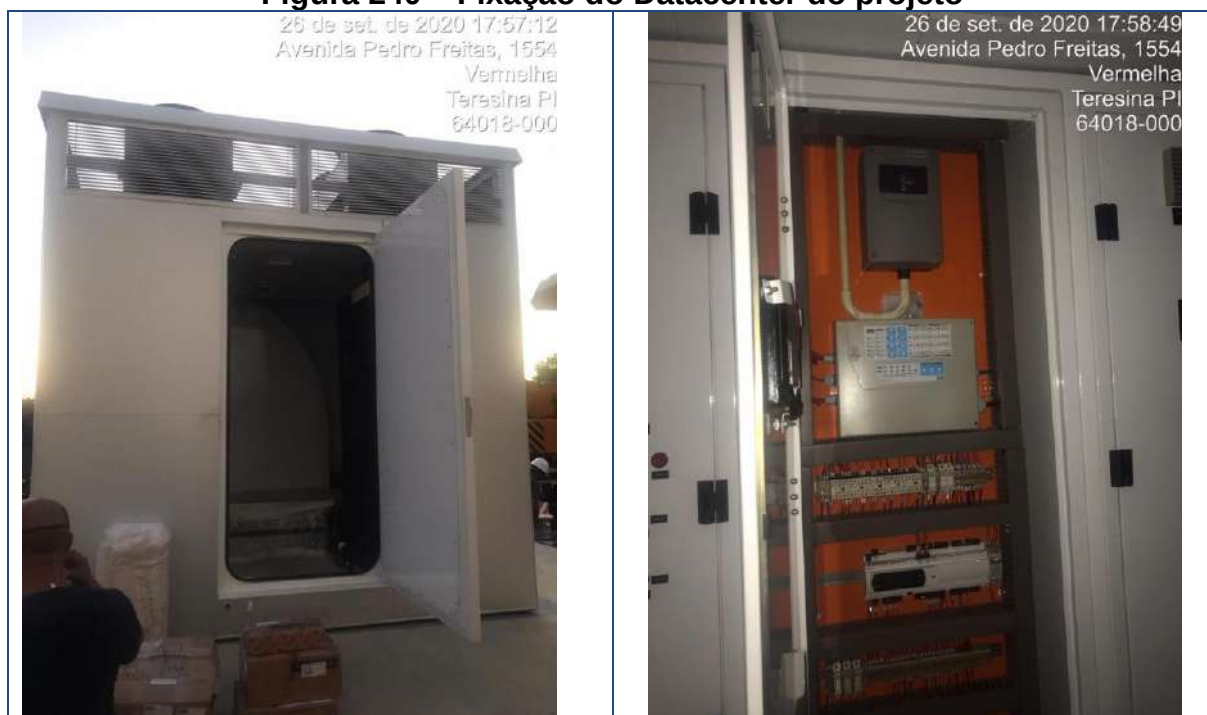
Figura 240 – Fixação do Datacenter do projeto
