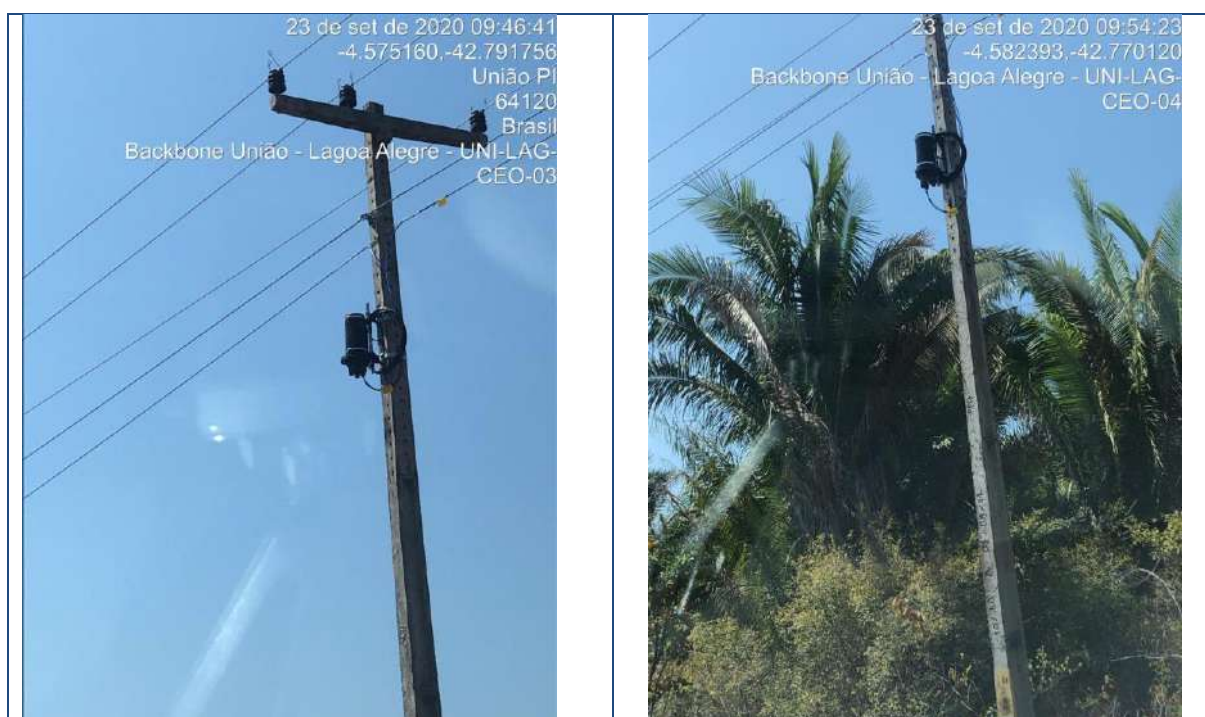
Figura 210 - Backbone aéreo União/Lagoa Alegre
