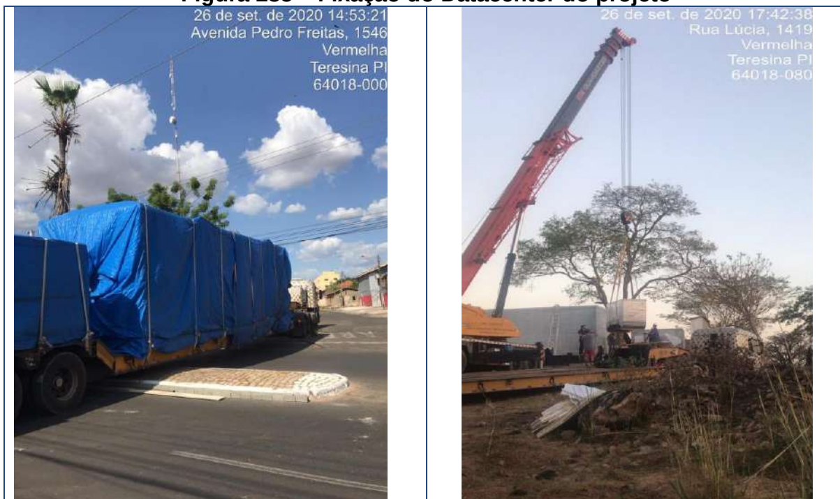
Figura 235 – Fixação do Datacenter do projeto
