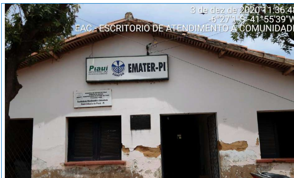
Figura 28 – PAG EAC - Escritório de Atendimento à Comunidade – Novo Oriente
