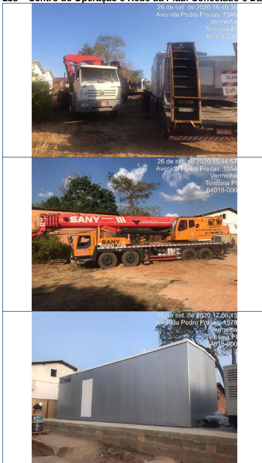
Figura 238 – Centro de Operação e Rede da Piauí Conectado e Datacenter
