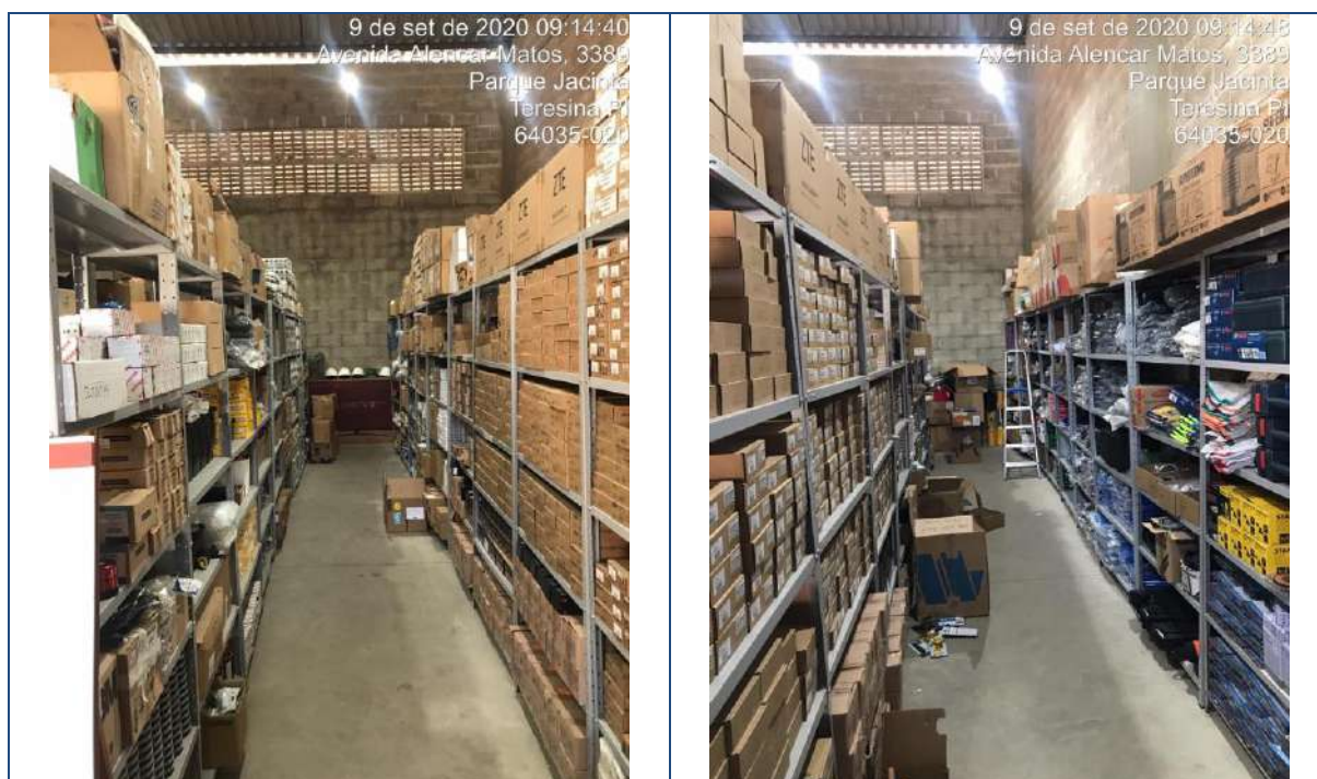
Figura 193 – Materiais e Equipamentos para implantação do Backbone
