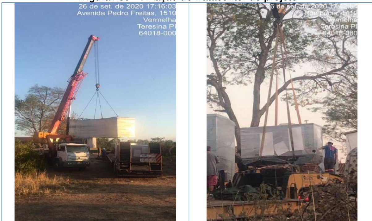
Figura 236 – Fixação do Datacenter do projeto
