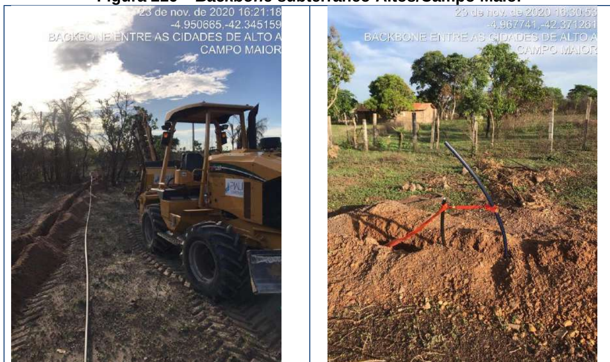
Figura 216 – Backbone subterrâneo Altos/Campo Maior
