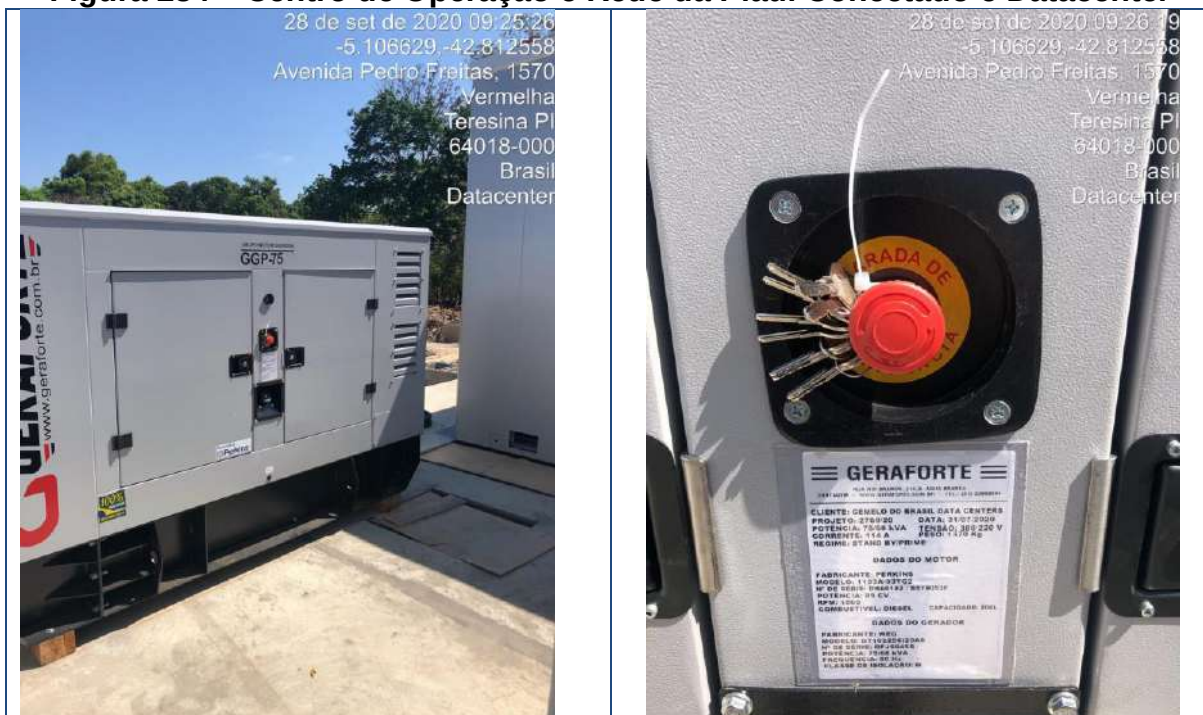
Figura 234 – Centro de Operação e Rede da Piauí Conectado e Datacenter
