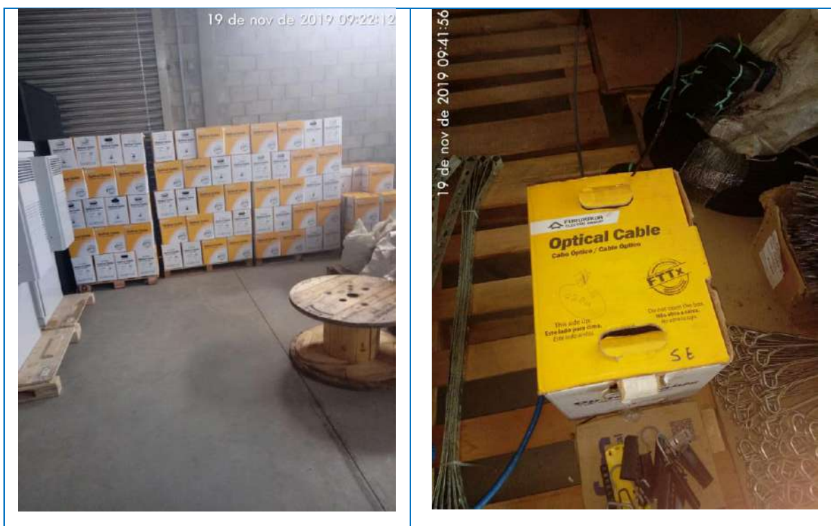
Figura 44 - Caixas de DROP FURUKAWA
