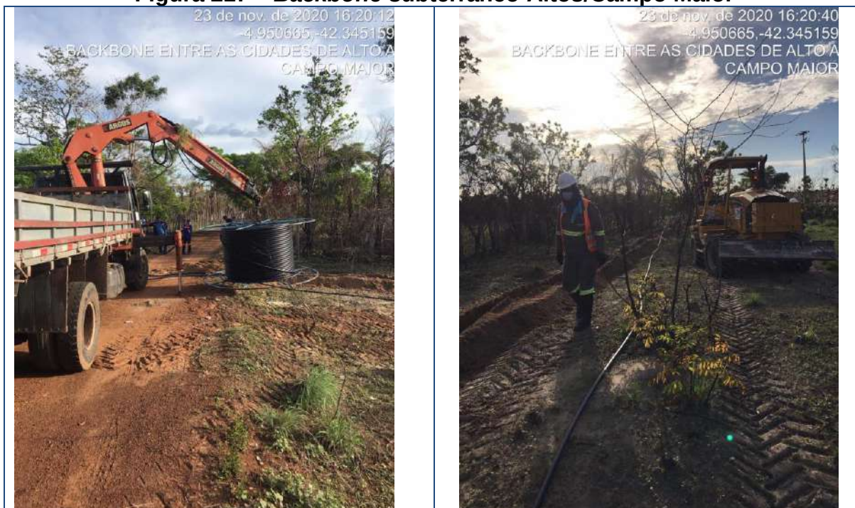
Figura 217 – Backbone subterrâneo Altos/Campo Maior
