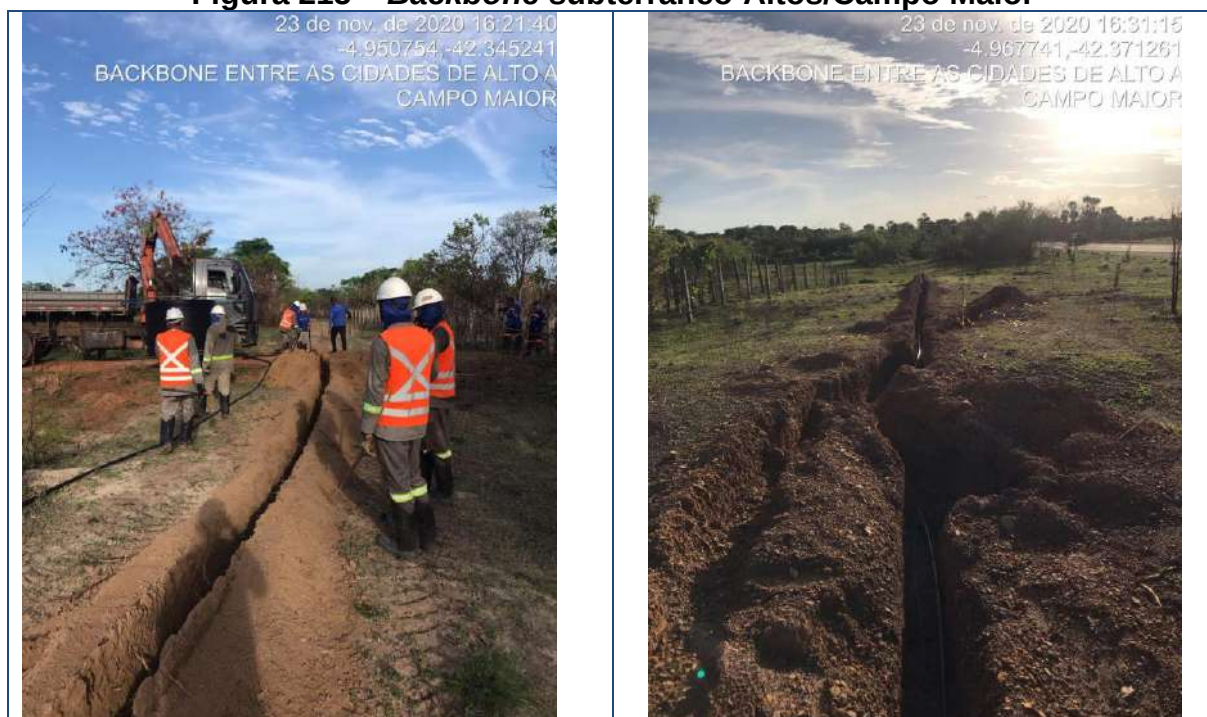
Figura 215 – Backbone subterrâneo Altos/Campo Maior
