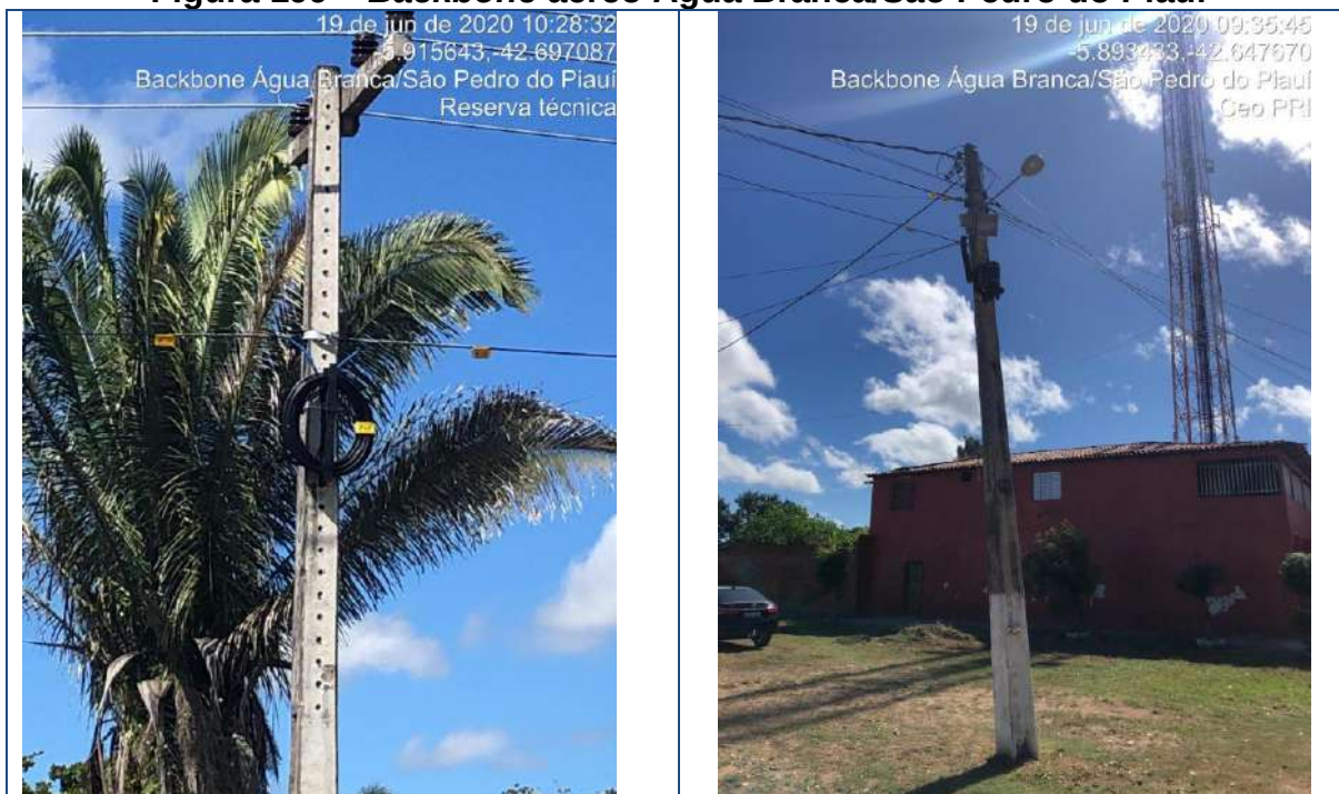
Figura 199 – Backbone aéreo Água Branca/São Pedro do Piauí
