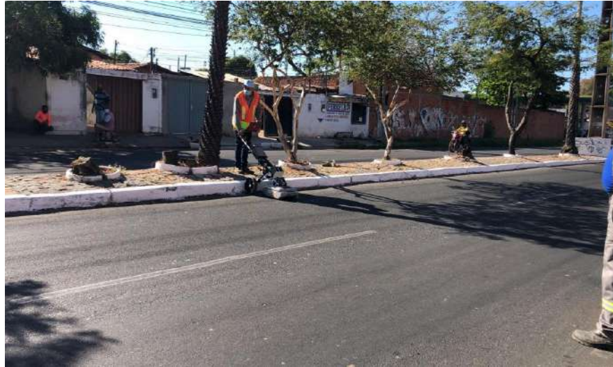
Figura 205 – Equipe SPE realizando sondagem MND
