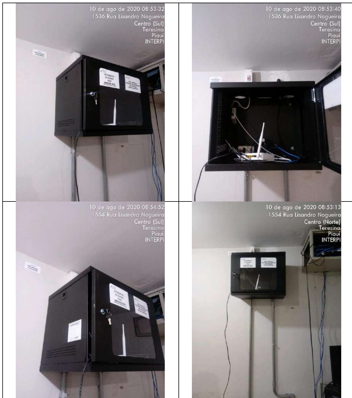
Figura 143 – PAG INTERPI: NÃO CONFORME – Ausência de adesivo com identificação do rack – Teresina
