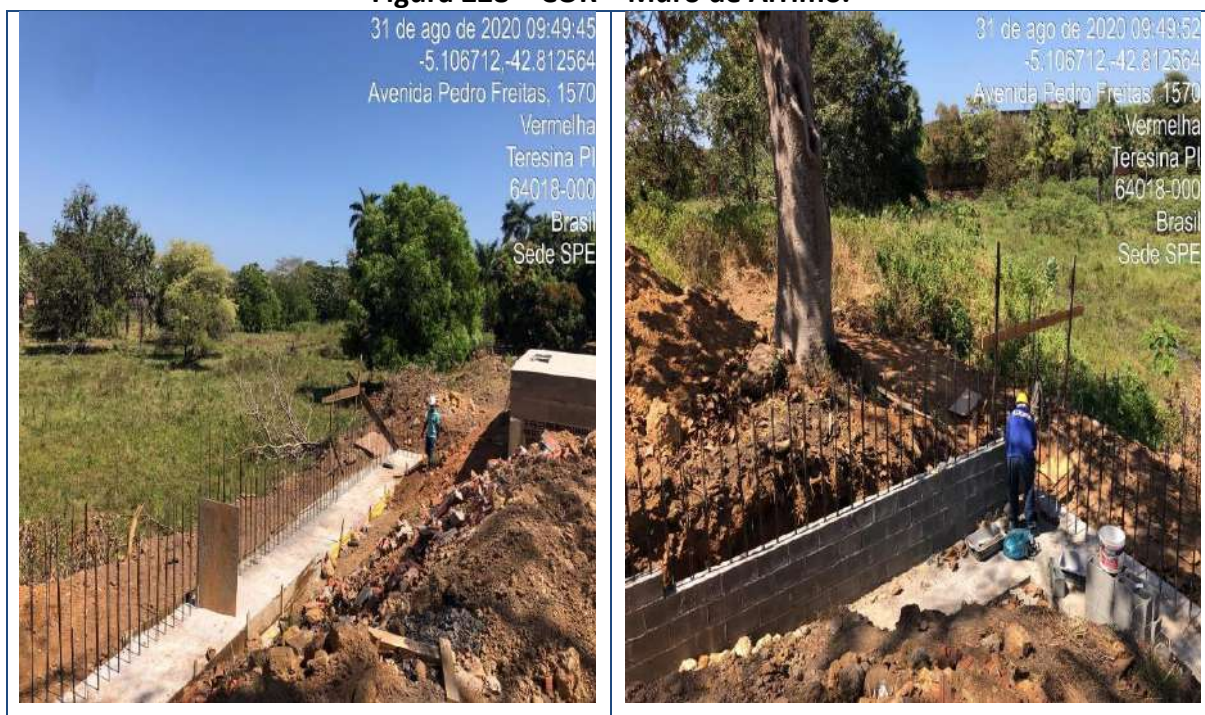
Figura 228 – COR – Muro de Arrimo.
