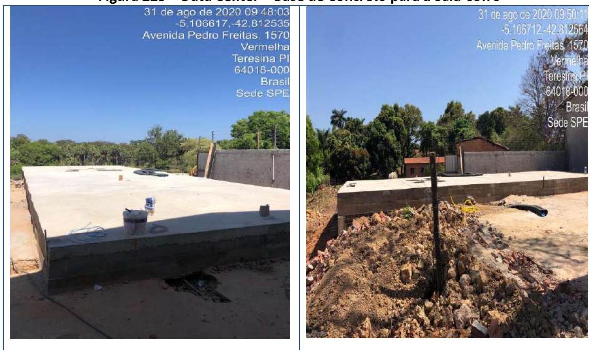
Figura 225 – Data Center – Base de Concreto para a Sala Cofre
