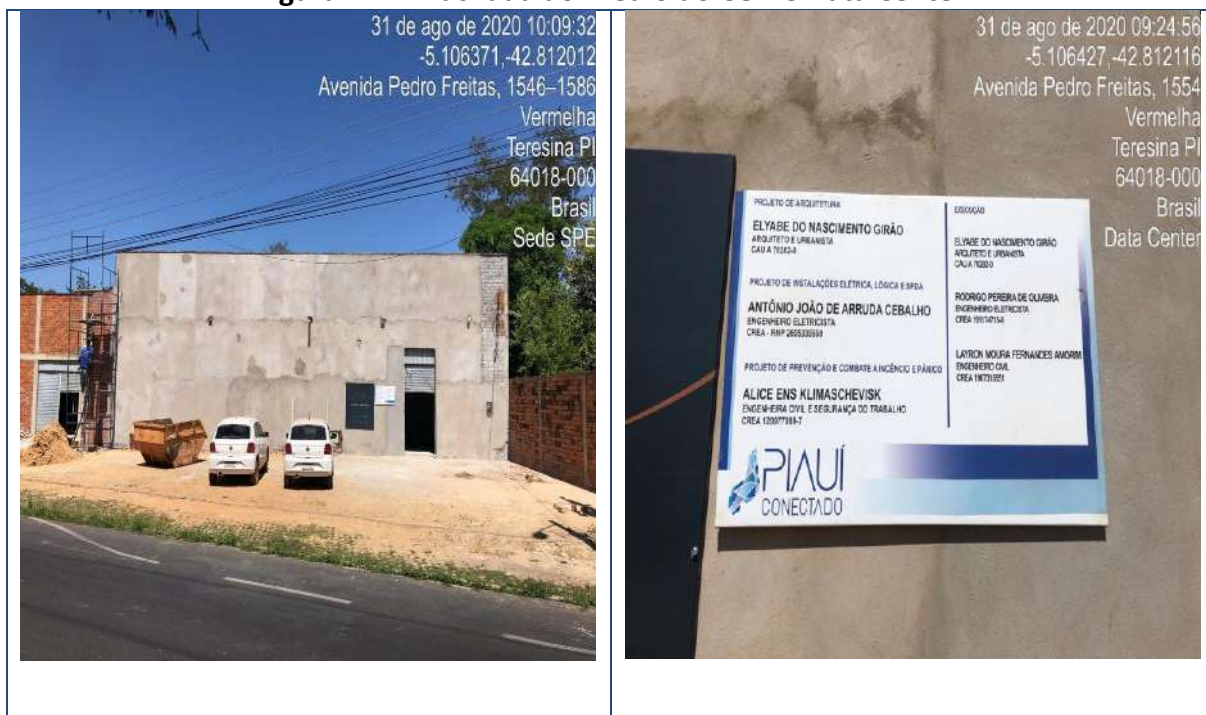
Figura 221 – Fachada do Prédio do COR e Data Center
