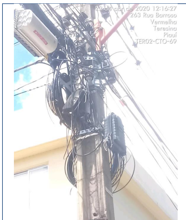
Figura 70 – TER02-CTO-69 – CTO sem plaqueta de identificação e sem cruzeta para reserva técnica - Teresina
