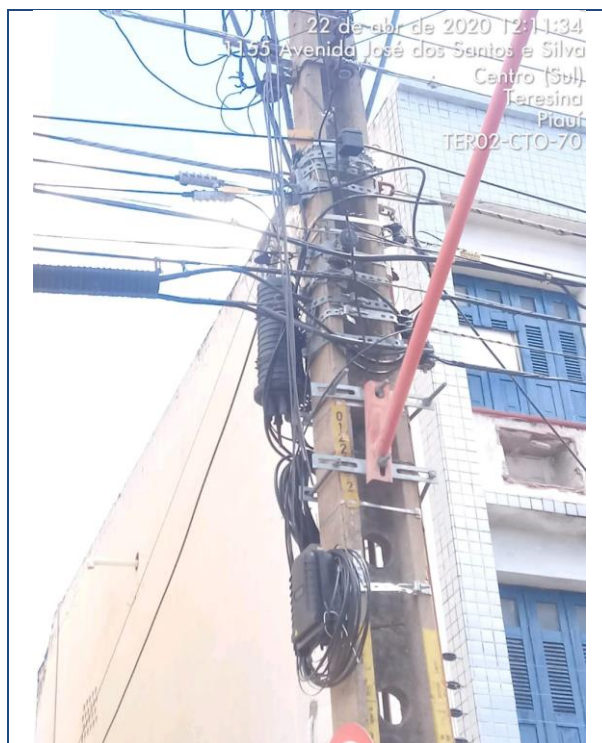
Figura 68 – TER02-CTO-70 – CTO sem plaqueta de identificação - Teresina
