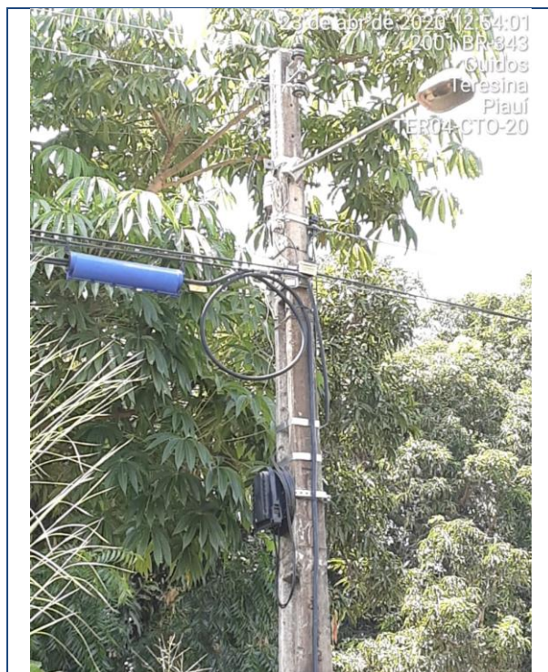
Figura 80 – TER04-CTO-20 – CTO sem plaqueta de identificação - Teresina
