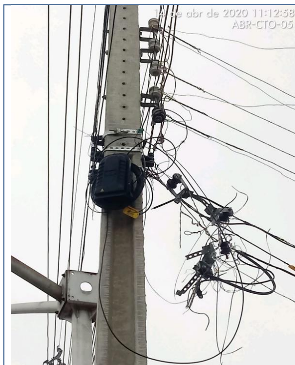
Figura 54 – ABR-CTO-05 – CTO com cabo abaixo da altura mínima de 5,20 – Água Branca
