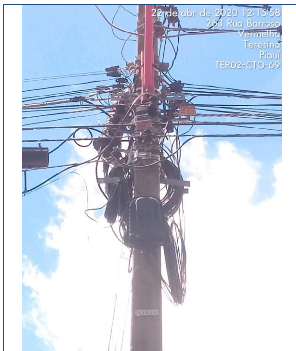
Figura 69 – TER02-CTO-69 – CTO sem plaqueta de identificação e sem cruzeta para reserva técnica - Teresina
