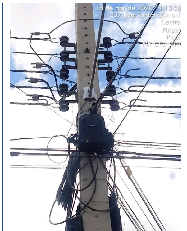
Figura 64 – PIR-CTO-010 – CTO sem cruzeta para reserva técnica – Piripiri
