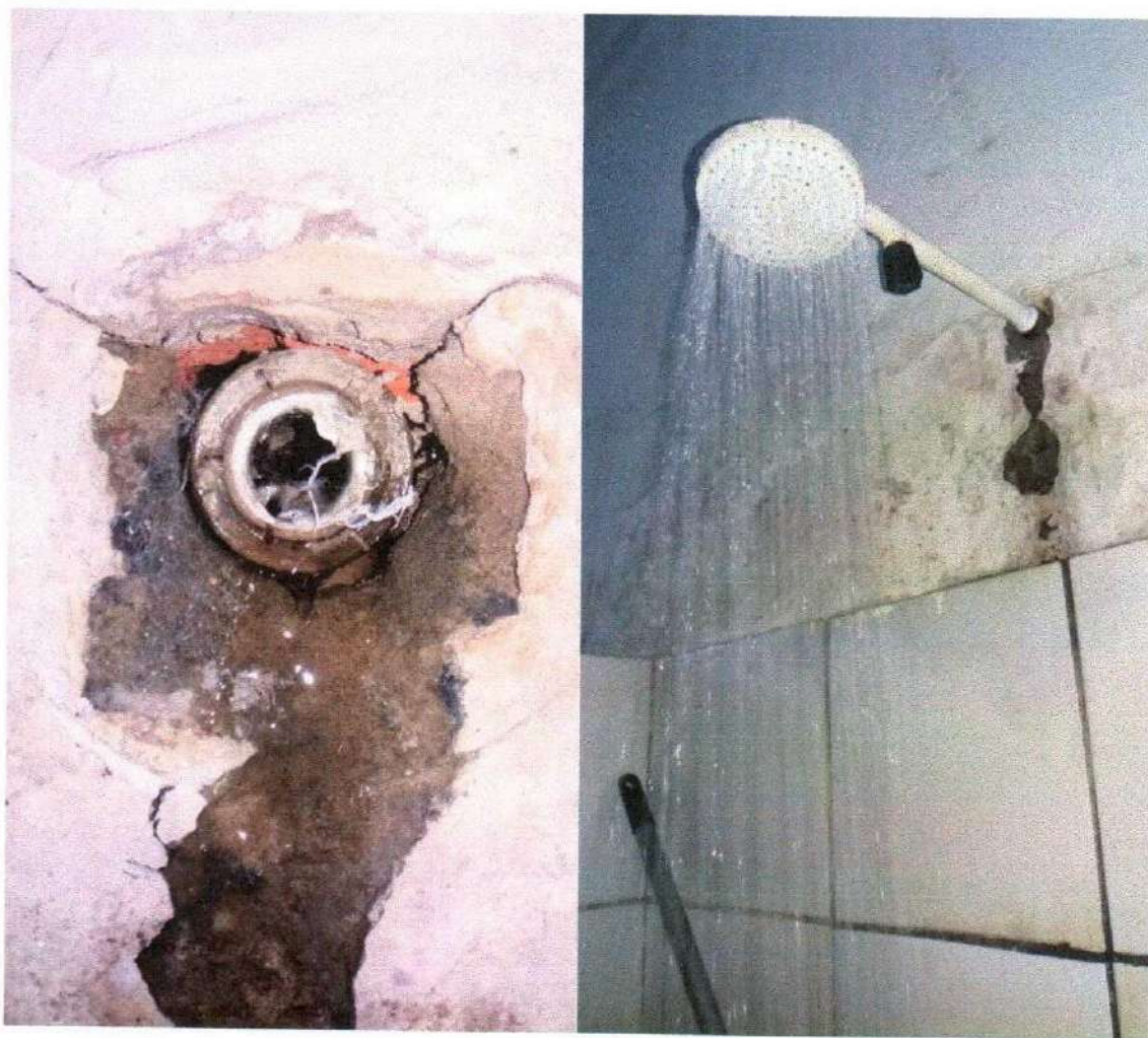
Fig. 5 e 6 – Reparo na instalação hidráulica e troca de chuveiro no Banheiro Central
