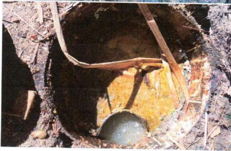
Fig. 3 e 4 – Desentupimento de Ralo Sifonado no Galpão PP/III
