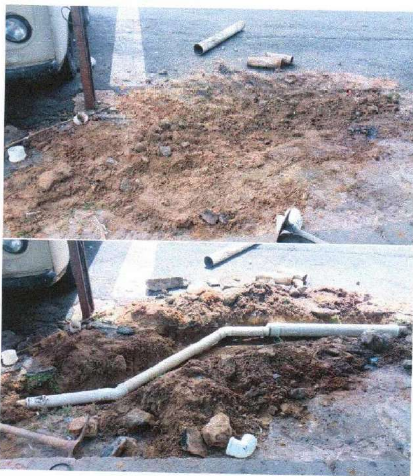
Fig. 1 e 2 – Instalação Sanitária em frente ao Galpão PPII
