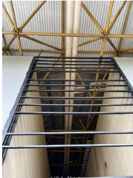
Figura 5 – Tubulação de águas pluviais
